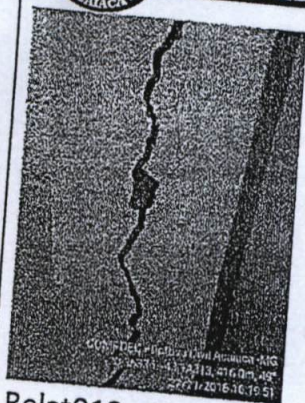
Relat018 – Zoom da Rachaduras das Colunas e Cintas de Concreto indo do corredor para cozinha.
