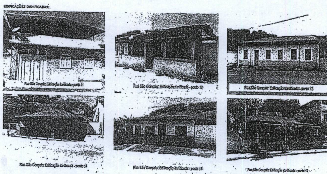
Figura 7 - Edificações danificadas localizadas na Rua São Gonçalo (Figura 5 do anexo)
