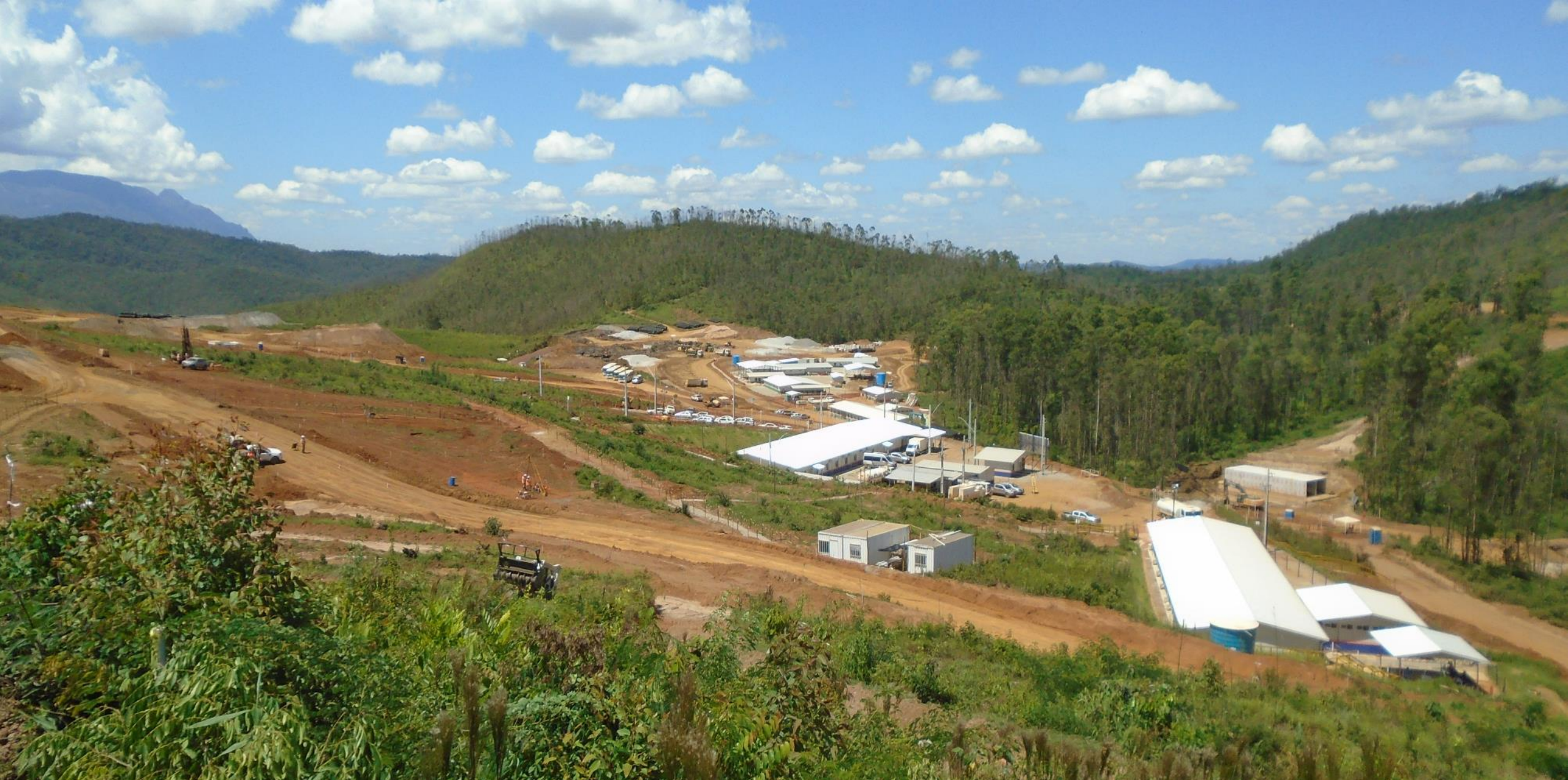
Vista Geral Área 3 – Canteiros de Obras - 15/01/19
