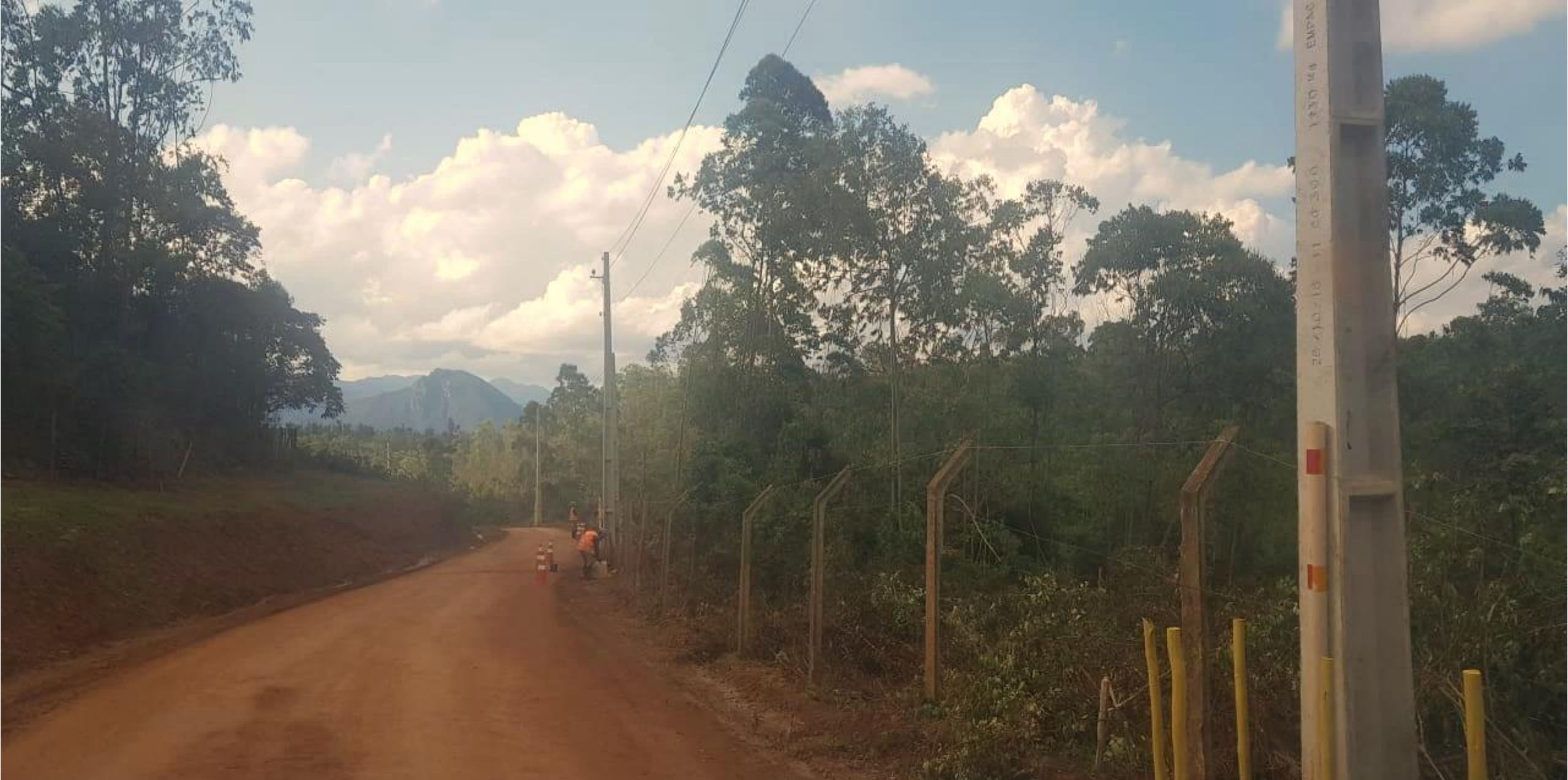
Linha da rede provisória concluída – 10/12/18
