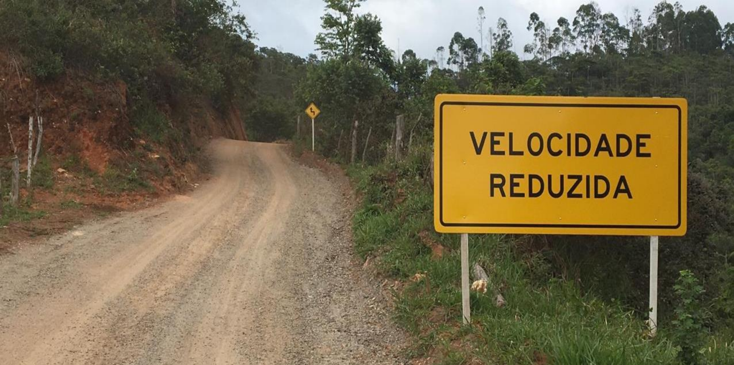
Melhoria do acesso a área do reassentamento de Paracatu de Baixo
