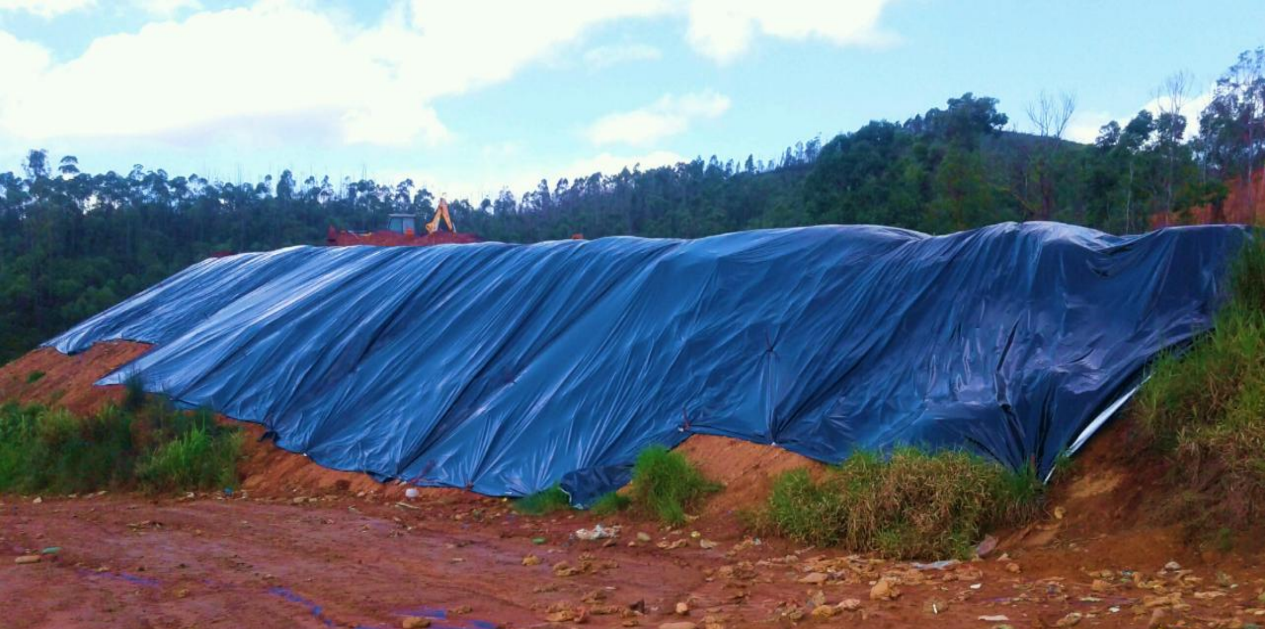
Obras de Intervenção Emergencial Período Chuvoso – Aterro Sanitário, concluído em 20/12/18
