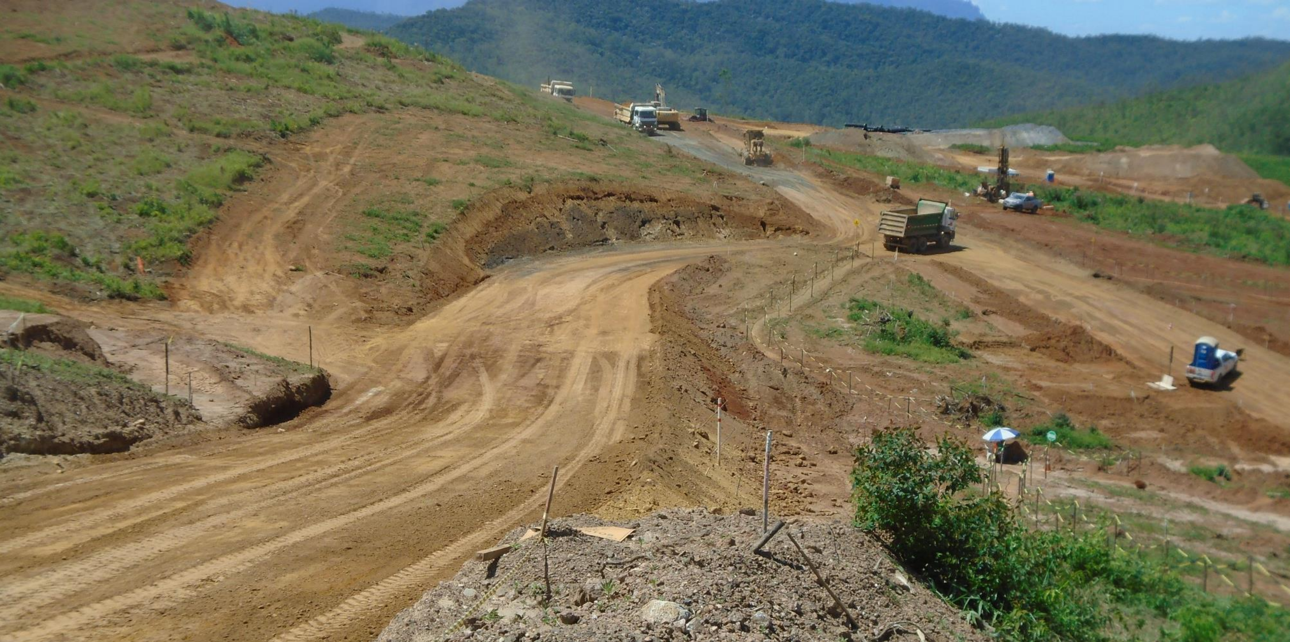
Compactação de Aterro – Área 2 - 15/01/19
