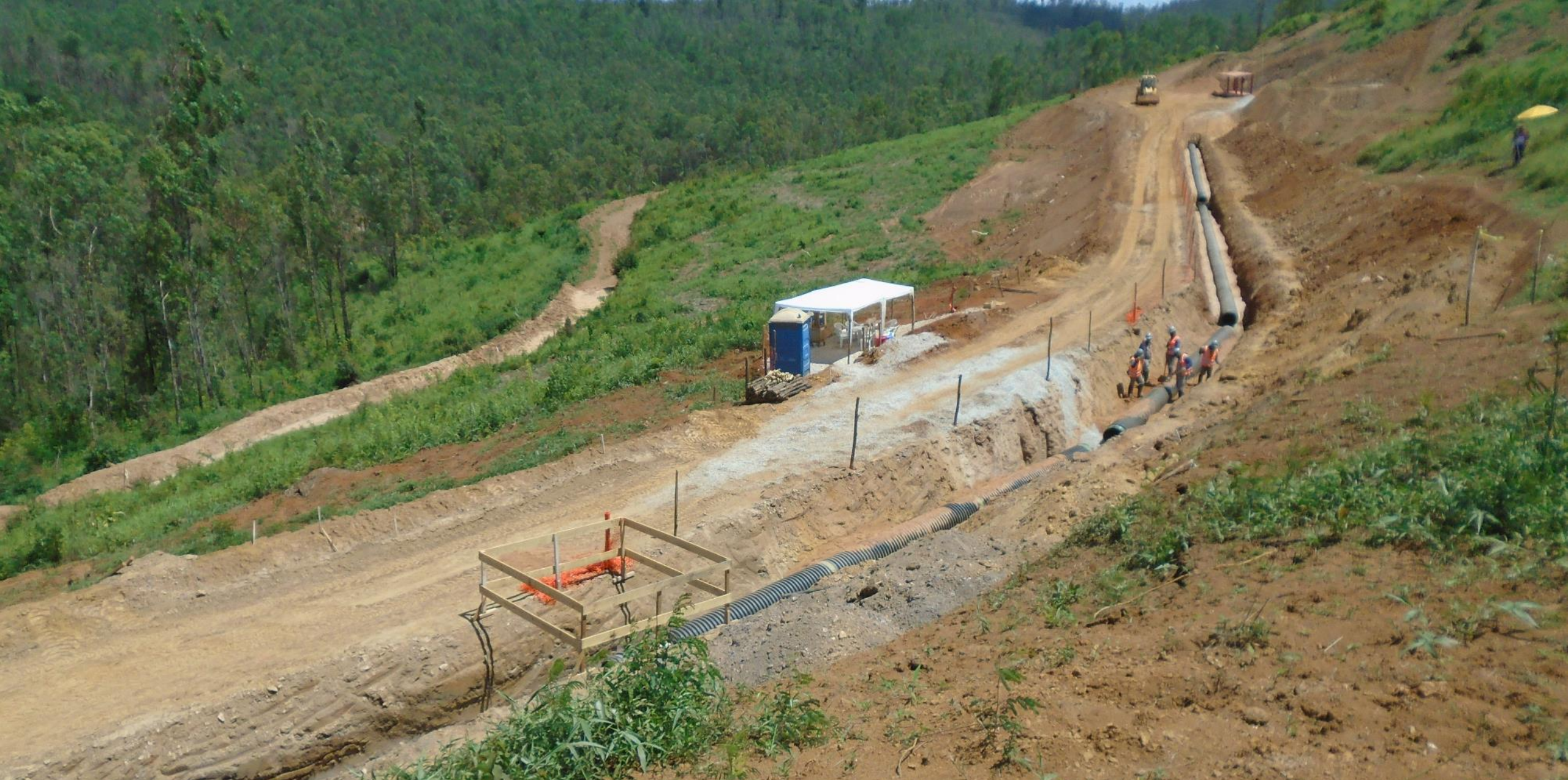
Execução Atividades de Drenagem – Área 2, Rua Nova - 15/01/19
