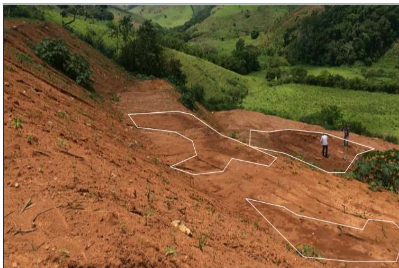
Foto 20: Manchas de chorume na superfície do Aterro de Barra Longa.
