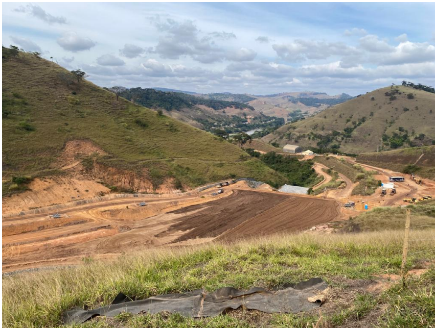
Figura 7 - Contrapilamento de material
