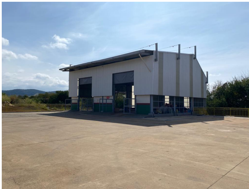
Figura 1 - Usina de Triagem e Compostagem - Galpão de Transbordo (parte externa)
