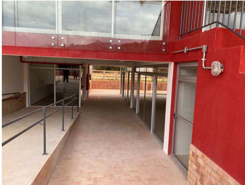
Foto 3 - Área das salas multifuncionais
