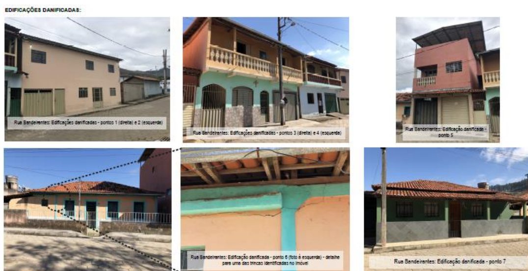
Figura 6 - Edificações danificadas localizadas na Rua Bandeirantes (Figura 4 do anexo)
