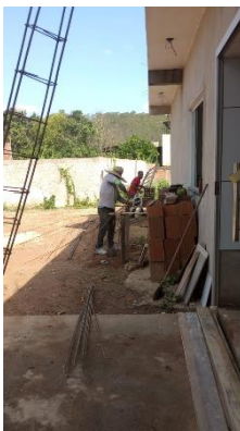
Figura 1-Vista da futura área de recepção do pescado para
