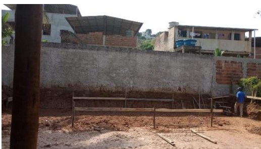
Figura 2 - Vista da futura área de locação dos vestiários
