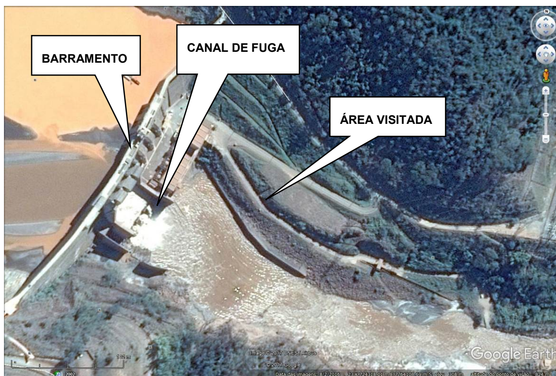
Figura 12 – Vista da área logo a jusante do barramento ao lado do canal de fuga.
