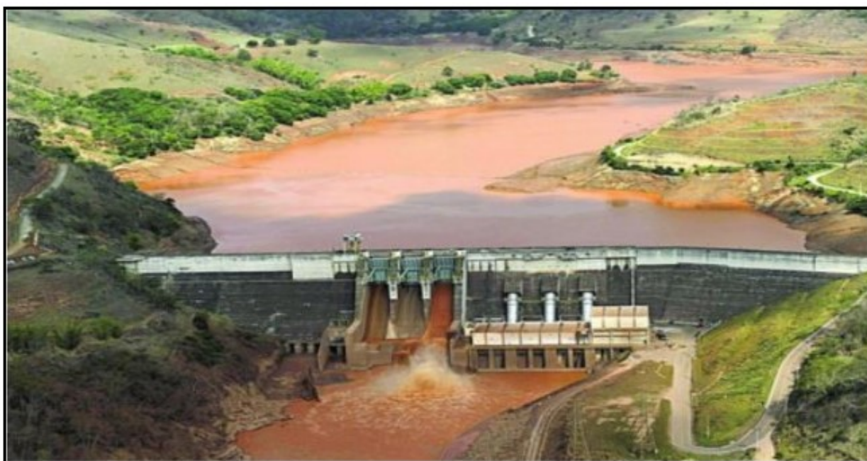
Figura 05 - UHE Risoleta Neves
