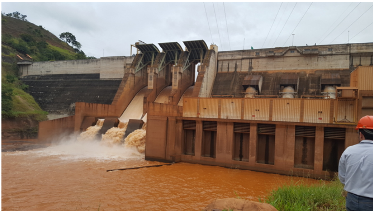
Figura 04 - Foto do canal de fuga e vertedouro
