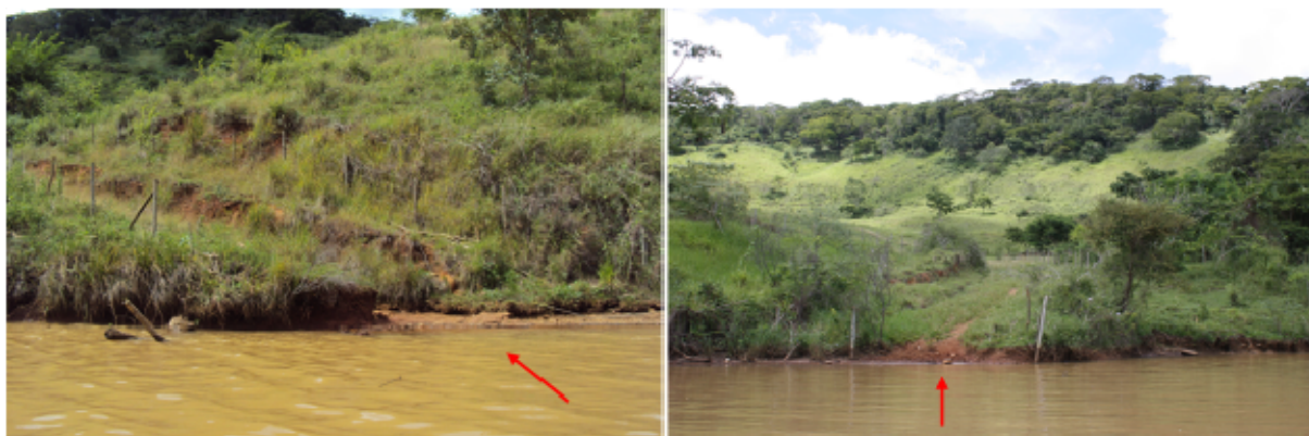
Figura 9.12 - Acessos para o gado ao reservatório da UHE Risoleta Neves.
