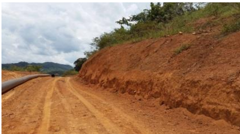
Figura 17 - Talude do ponto 38
