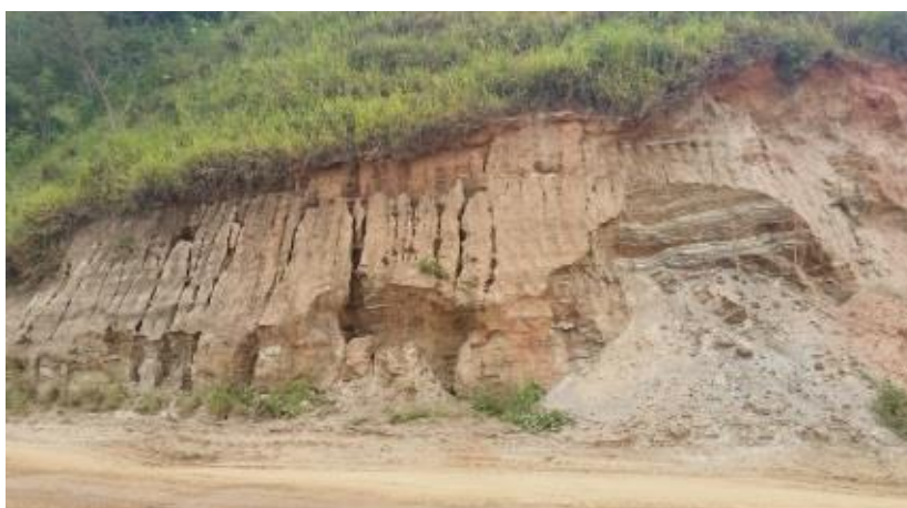
Figura 18 -Talude do ponto 42.
