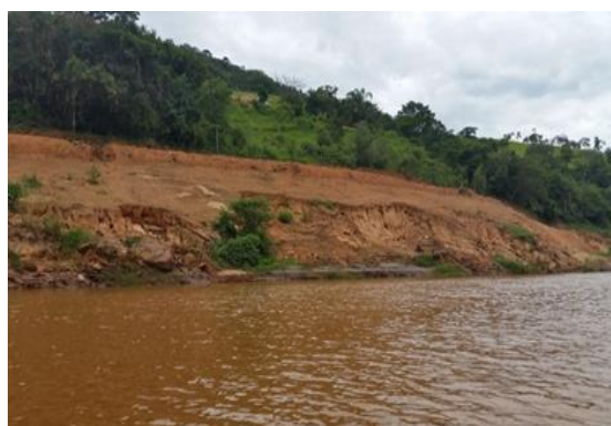
Figura 33 - Vista dos taludes dos Pontos 133, 134 e 135
