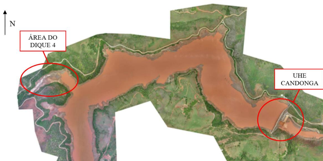
Figura 21 – Localização do Dique 04
