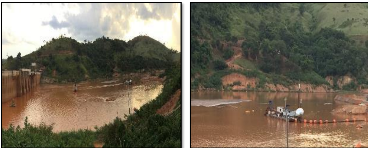
Figura 04 – Vista Superior / Lateral do Barramento B
