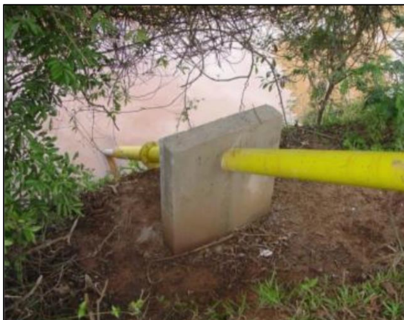
Figura 09 - Medidor fixo de turbidez e teor de sólido suspenso
