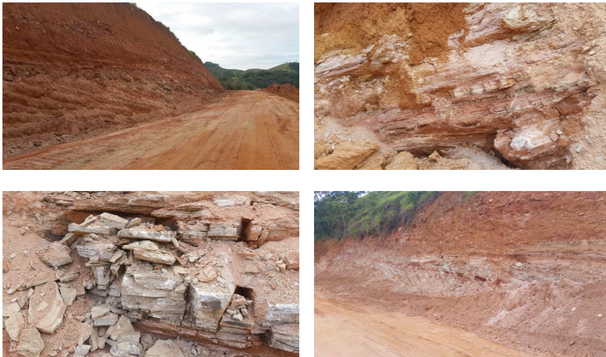
Figura 04 - Detalhes do talude cadastrado no Ponto 1
