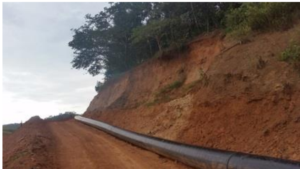
Figura 23 - Taludes: a) ponto 51, b) ponto 52 e c) ponto 53
