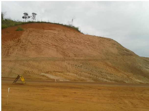
Figura 22 - Taludes: a) ponto 47, b) ponto 48 e c) ponto 49
