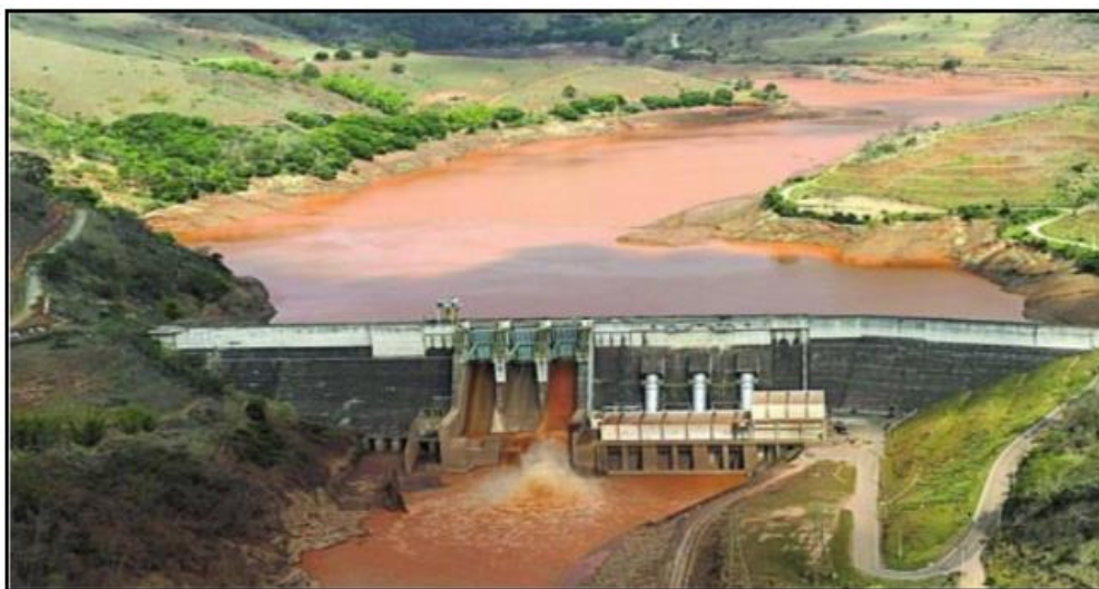
Figura 04 - UHE Risoleta Neves
