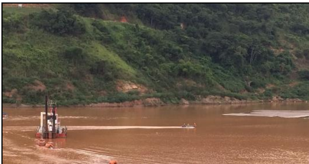
Figura 05 – Posicionamento dos Equipamentos de Dragagem
