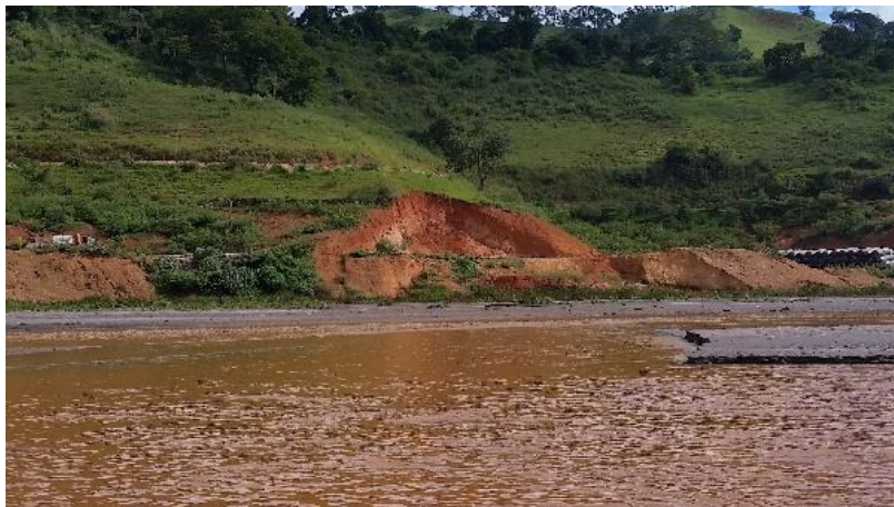
Figura 16 - Talude do ponto 37
