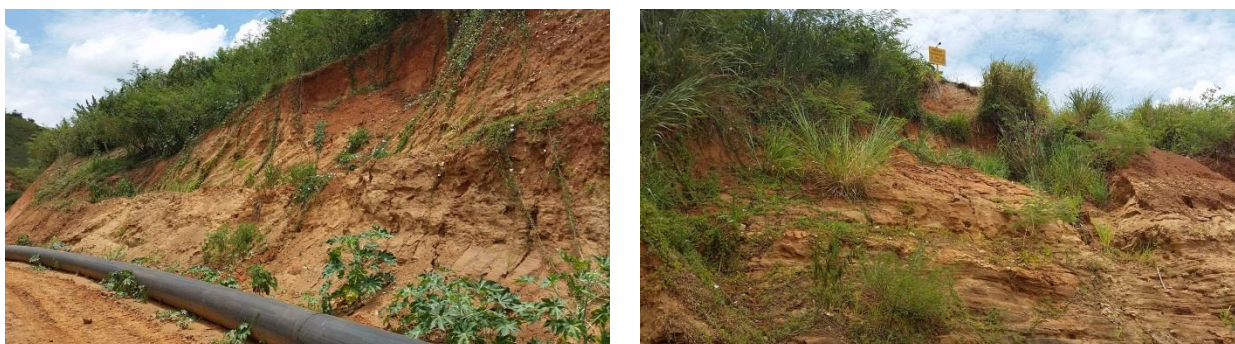
Figura 15 - Talude do ponto 36
