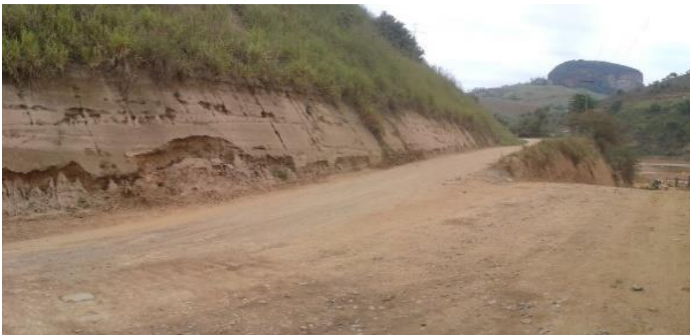
Figura 07 - Vista do talude do ponto 24.
