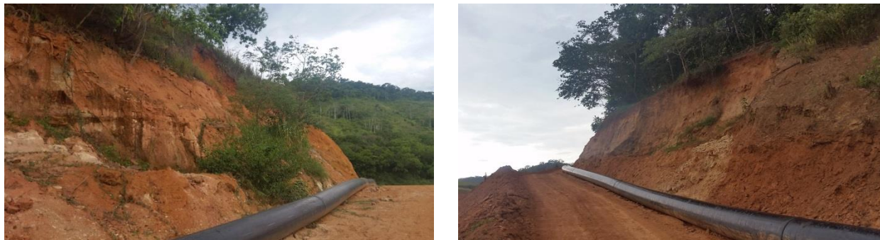
Figura 02 - Solo de alteração de anfibólitos.
