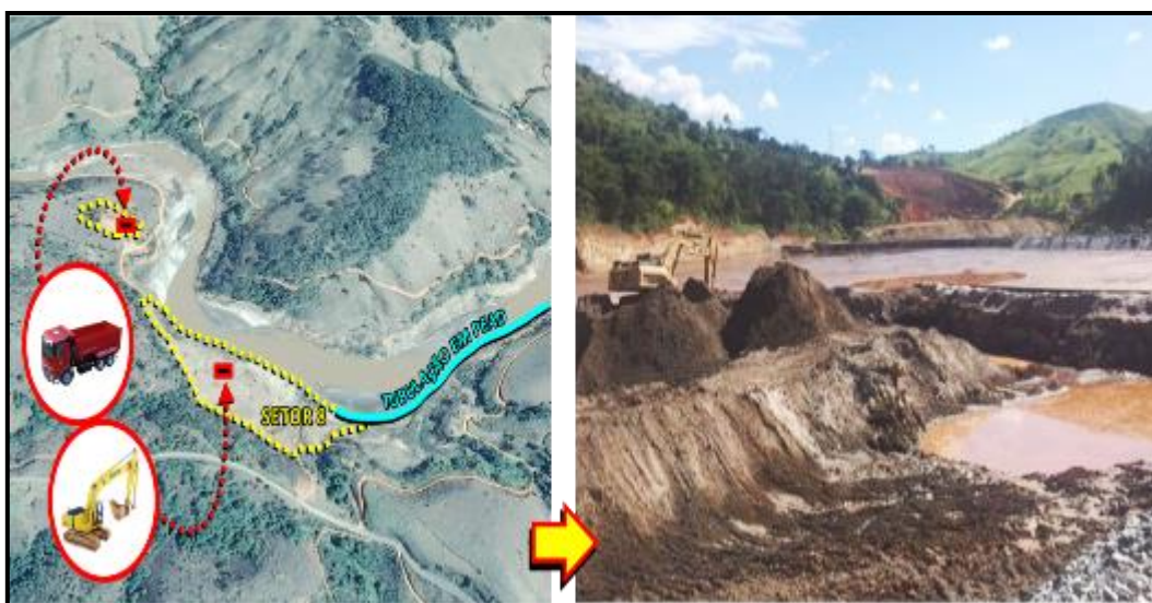
Figura 06 – Escavação Mecanizada do Setor 8
