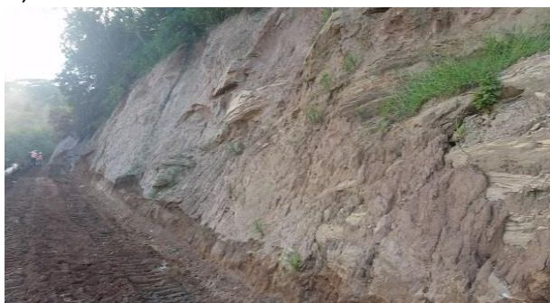
Figura 30 - Vista do talude do Ponto 116 ao Ponto 120
