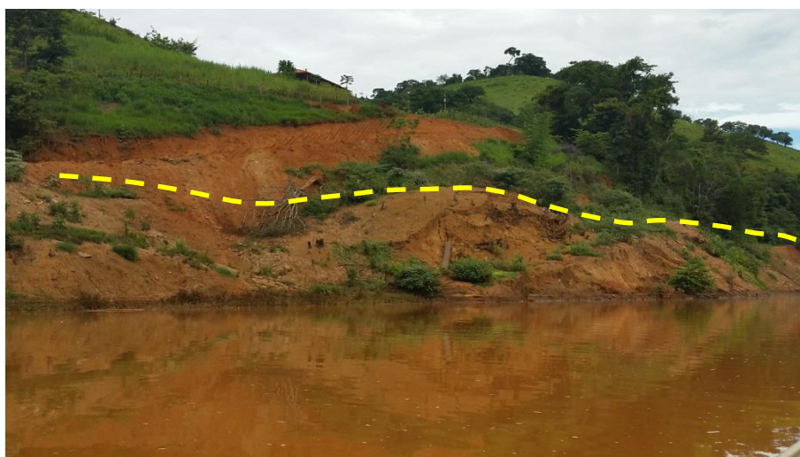
Figura 35 - Vista geral do talude do ponto 137
