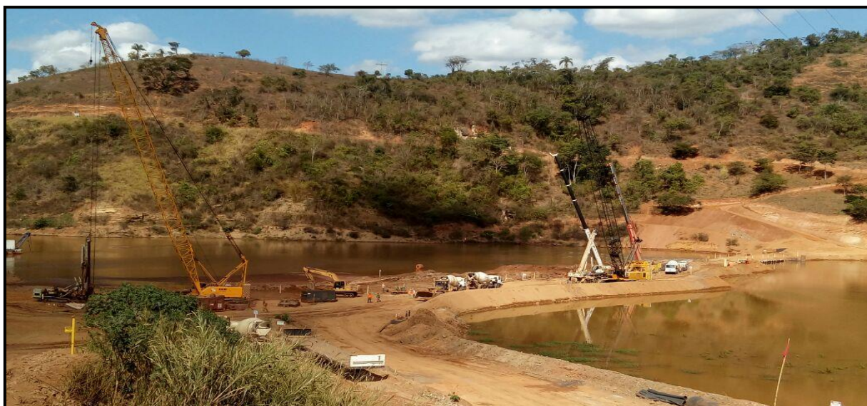
Figura 02 – Eixo/ Pipeshop do Barramento A
