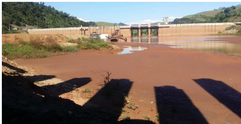
Foto 8-66. Barragem do reservatório de Candonga visto de montante, com nível d'água na cota 312 m. Ao fundo uma das duas dragas em operação e em primeiro plano, sombra do Barramento A, em implantação.
