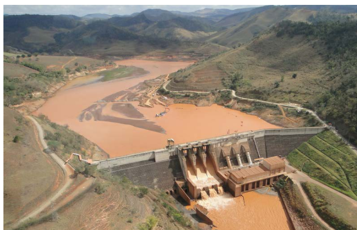
Foto 8-65. Barragem do reservatório de Candonga. Ao fundo, as operações iniciais de dragagem dos materiais depositados no evento, no setor mais próximo à barragem.
