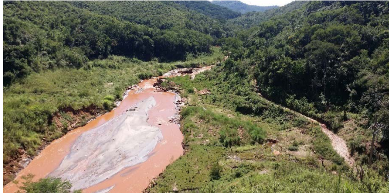
Foto 8-27. Setor do Trecho 8 a jusante da PCH Bicas, não abrangido pelas obras emergenciais, mas com recuperação importante da vegetação sobre os depósitos de encostas e de planícies por regeneração natural.
