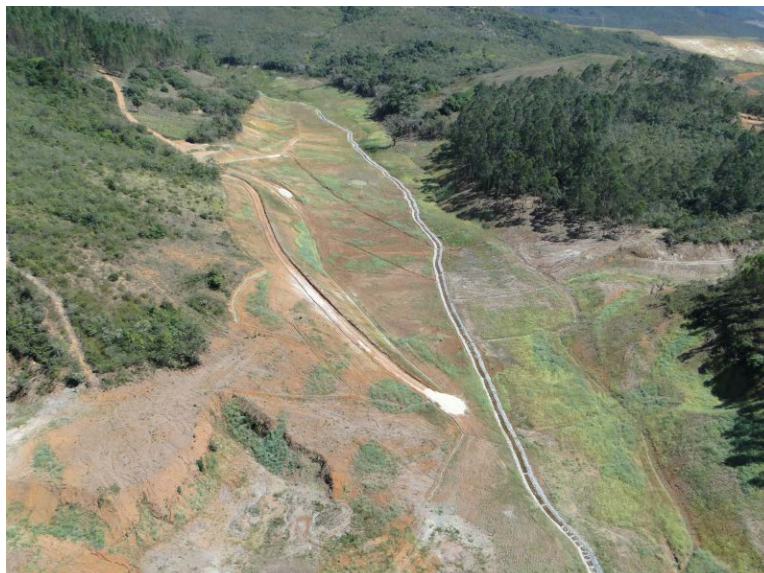
Foto 8-17. Rio Gualaxo do Norte, Trecho 6, com obras de drenagem superficial e implantação de cobertura vegetal de proteção contra a erosão, executadas no fundo de vale em pequeno tributário do rio Gualaxo do Norte, a montante da confluência do córrego Santarém.
