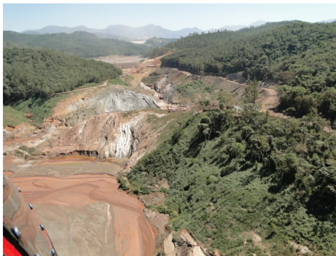
Foto 8-3. Remoção de parte do solo das encostas
