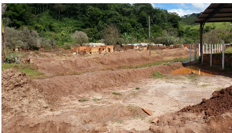
Foto 8-38. Aspecto geral do distrito de Paracatu. Ao fundo, o depósito de material detrítico chegando à altura do parapeito das janelas.
