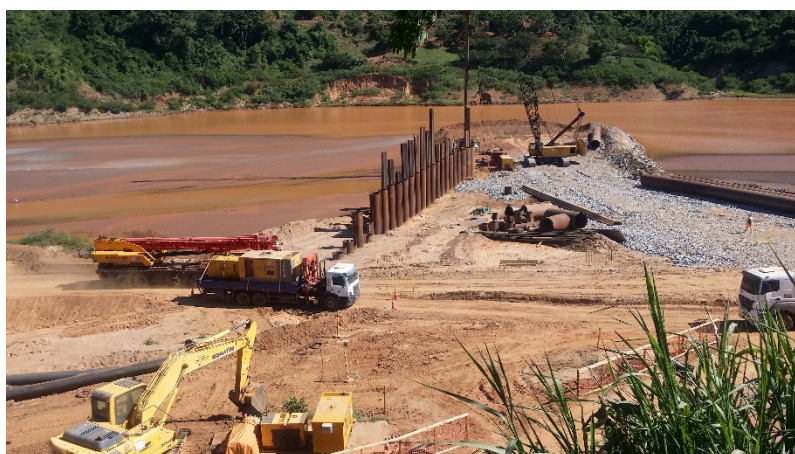
Foto 7-2. Visualização geral do avanço das obras do Barramento A em 4 abril 2017.
