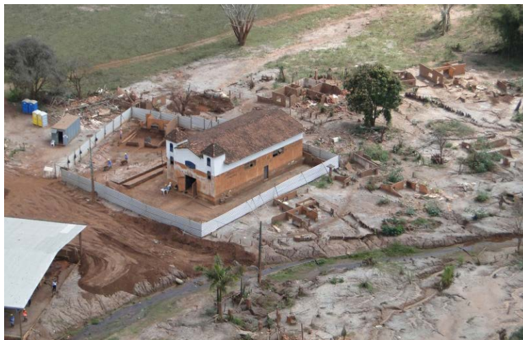
Foto 8-35. Capela de Santo Antônio, em Paracatu, evidenciando a altura de inundação, com altura em torno de 5 metros.
