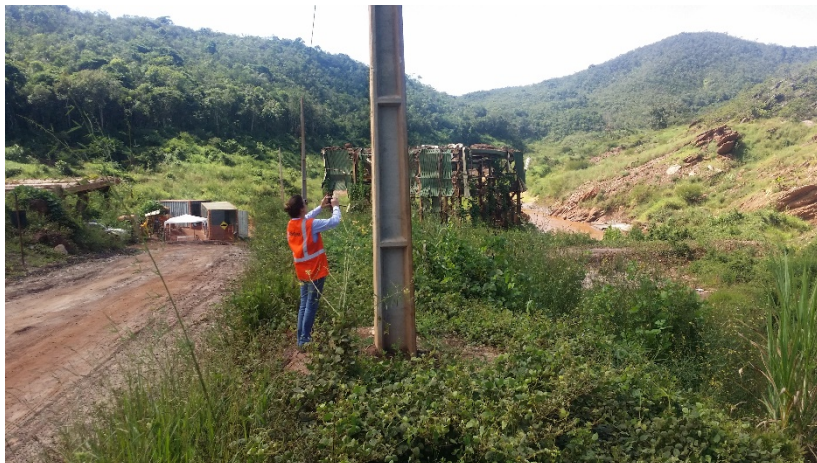
Foto 8-20. Trecho 7 do rio Gualaxo do Norte, junto à Estação de Bombeamento da Samarco. Notar o nível alcançado pelo fluxo de material detrítico e a regeneração natural da vegetação.
