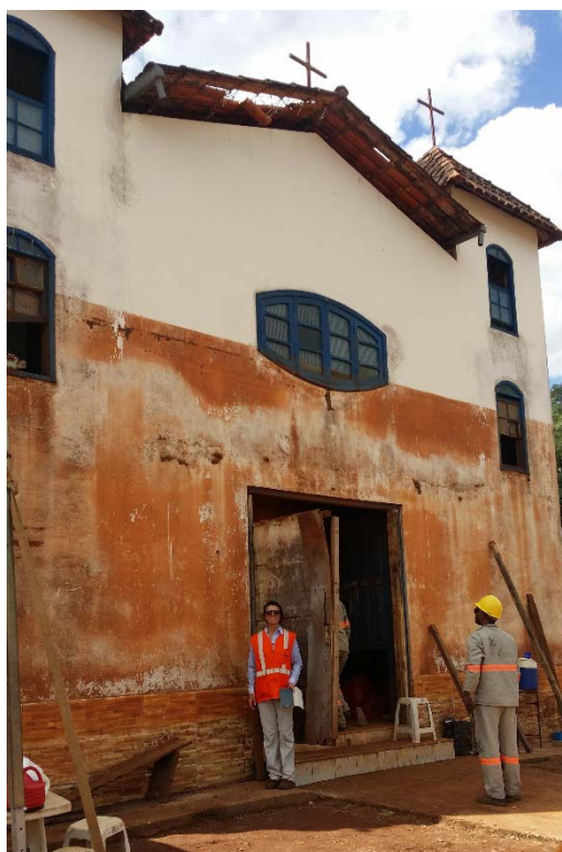
Foto 8-36. Capela de Santo Antônio, em Paracatu, em obras de restauração.
