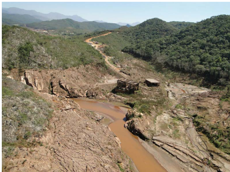
Foto 8-18. Estação de Captação e Bombeamento de água no rio Gualaxo do Norte, situada cerca de 400 m a jusante da foz do córrego Santarém. Ao fundo, a vila de Bento Rodrigues.
