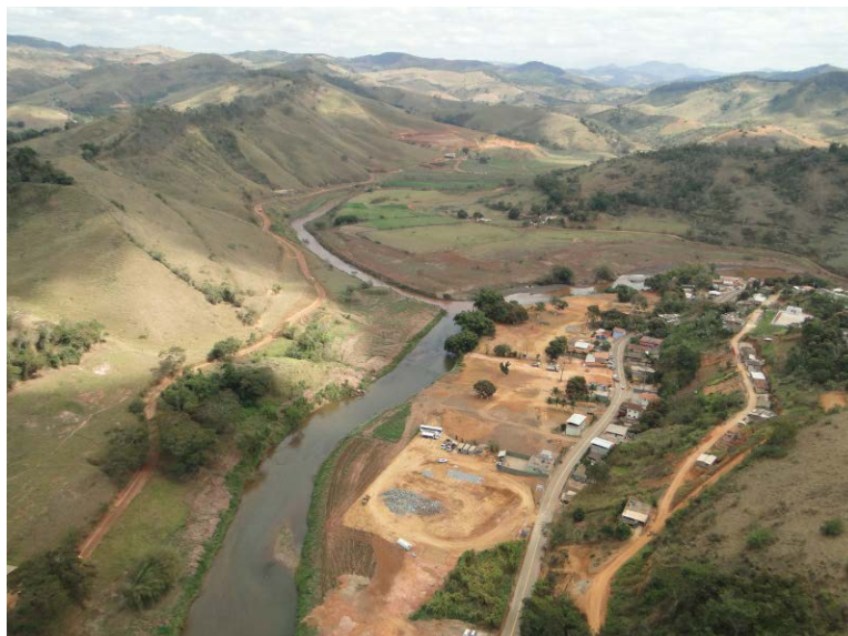
Foto 8-54. Áreas baixas da cidade de Barra Longa com deposição de material detrítico, já removidas. Ao fundo, a foz do rio Gualaxo do Norte.
