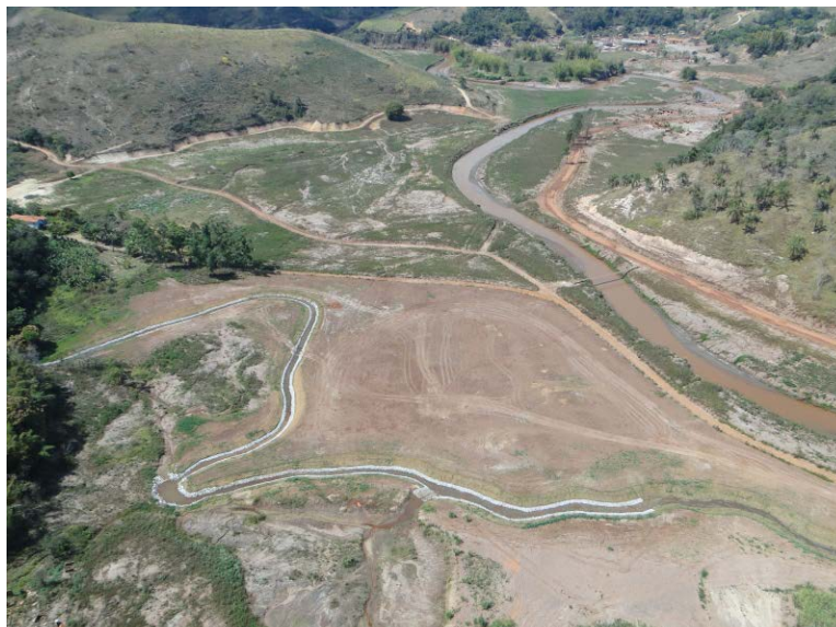
Foto 8-49. Obras de drenagem e controle de erosão em terraço aluvionar próximo a Paracatu – ao fundo.
