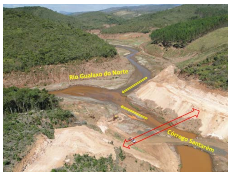
Foto 8-10. Confluência do córrego Santarém no rio Gualaxo do Norte e a localização do Dique S-4 (seta vermelha), em início de construção em agosto de 2016.
