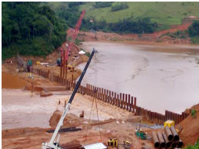
Foto 7-1. Visualização geral do avanço das obras do Barramento B.
