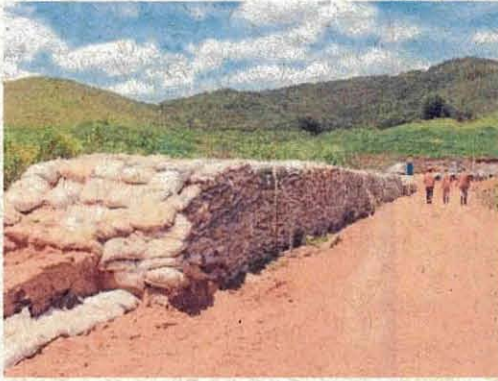
Figura 7- Vista da técnica riprap ainda exposta
