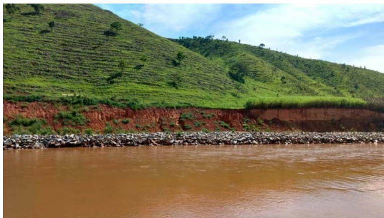
Foto 3-4. Enrocamento na margem do canal do rio Gualaxo do Norte nas proximidades de Gesteira
