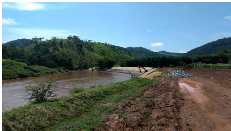
Foto 3-5. Implantação de um enrocamento em uma margem côncava do rio Gualaxo do Norte, nas proximidades de Gesteira
