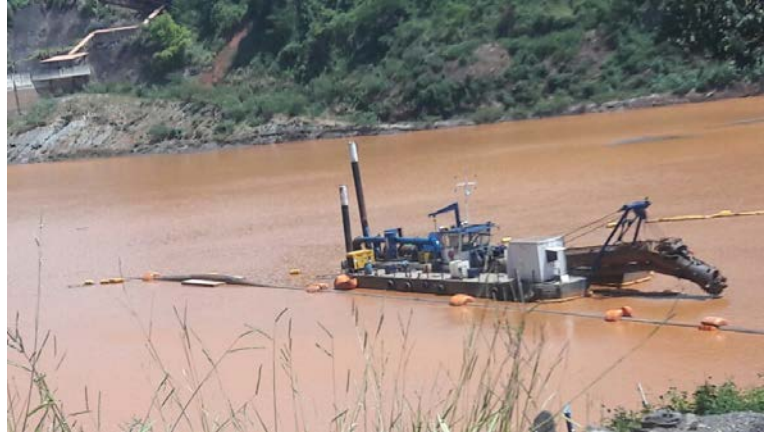
Foto 2-1. Equipamento de Dragagem de Grande Porte Utilizada para a Remoção de Sedimentos na Usina de Candonga
