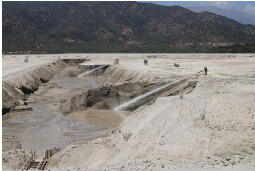
Foto 2-3. Exemplo de desmonte hidráulico
