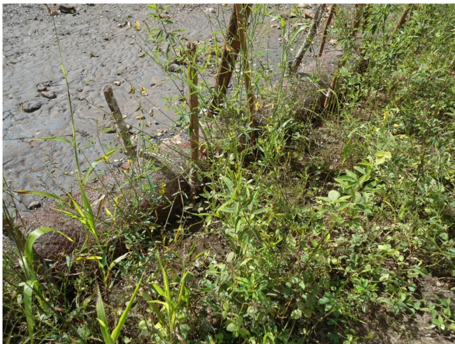
Figura 89. Detalhe do retentor de sedimento com vegetação em desenvolvimento
