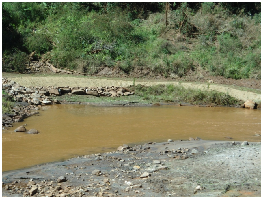
Figura 111. Vista geral da solução de bioengenharia para estabilizar os rejeitos
