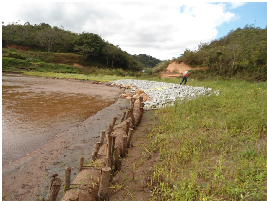
Figura 101. Enrocamento em excelente estado na Área 2
