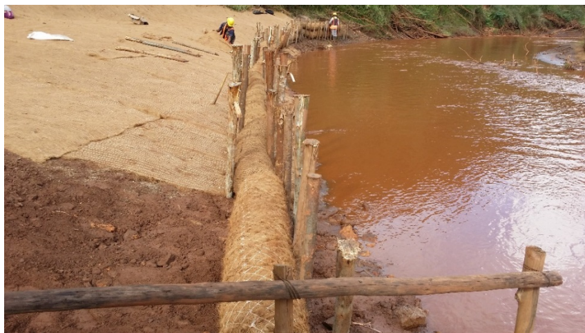
Figura 23. Aplicação de Biomanta com sementeira de gramíneas e retentores duplos de sedimentos (“bermalonga”) na margem do rio Gualaxo do Norte, Trecho 7
