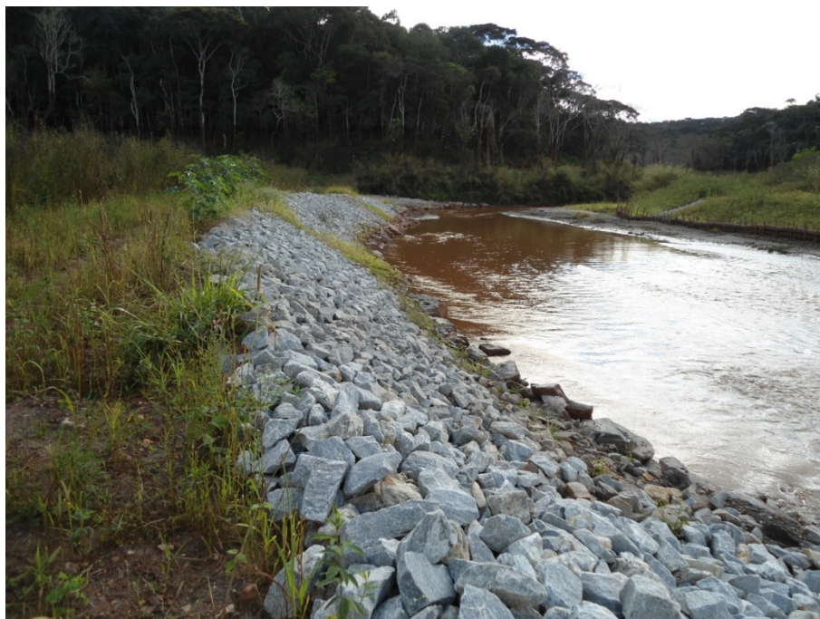
Figura 92. Enrocamento executado na Área 1
