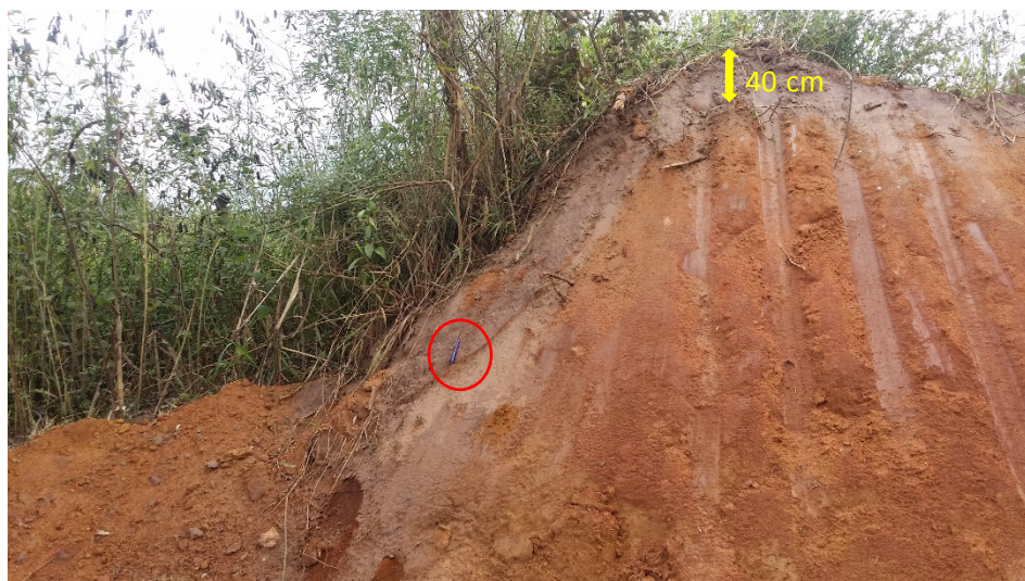
Figura 15. Pequena elevação junto à planície aluvionar do rio Gualaxo do Norte no Trecho 6, a montante da confluência do córrego Santarém. Observar a camada de rejeito que recobre uniformemente a elevação, desde o topo até a sua base, com uma espessura em torno de 40 cm (notar a caneta azul ao centro da foto)
