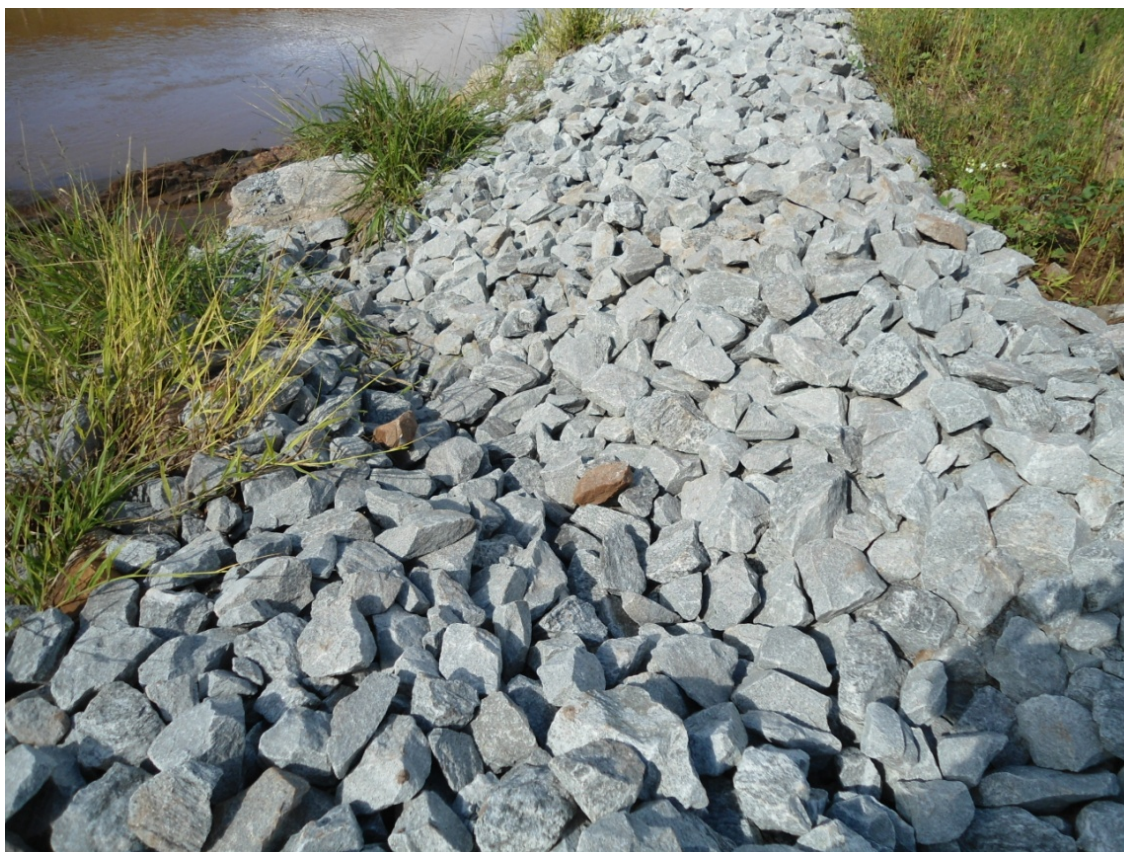
Figura 84. Exemplo de enrocamento implantado em um talude da margem do rio Gualaxo do Norte
