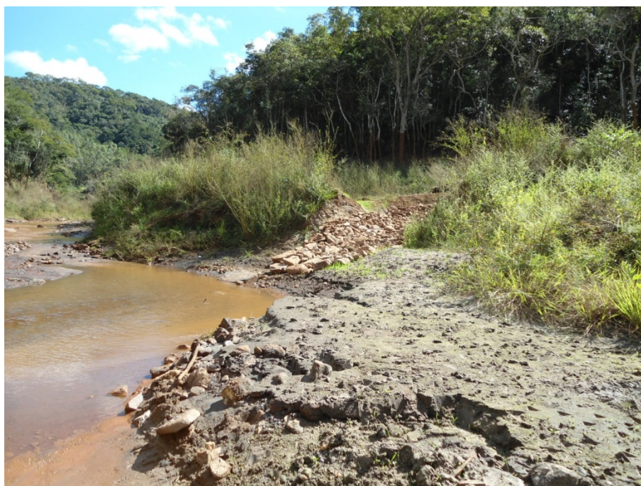
Figura 106. Detalhe do enrocamento para direcionar a drenagem pluvial para o rio
