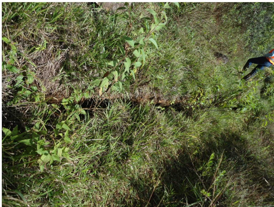
Figura 103. Vista parcial da trinca no acesso
