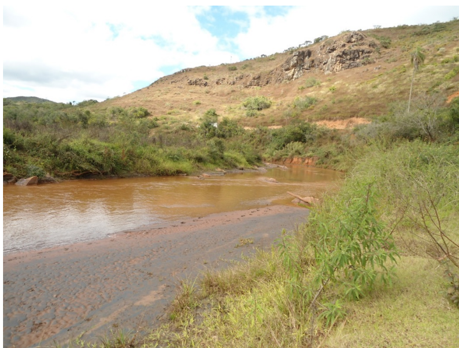
Figura 105. Ponto do rio onde é necessário reforçar com enrocamento
