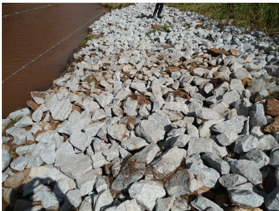
Figura 114. Vista geral do enrocamento implantado na Área 5
