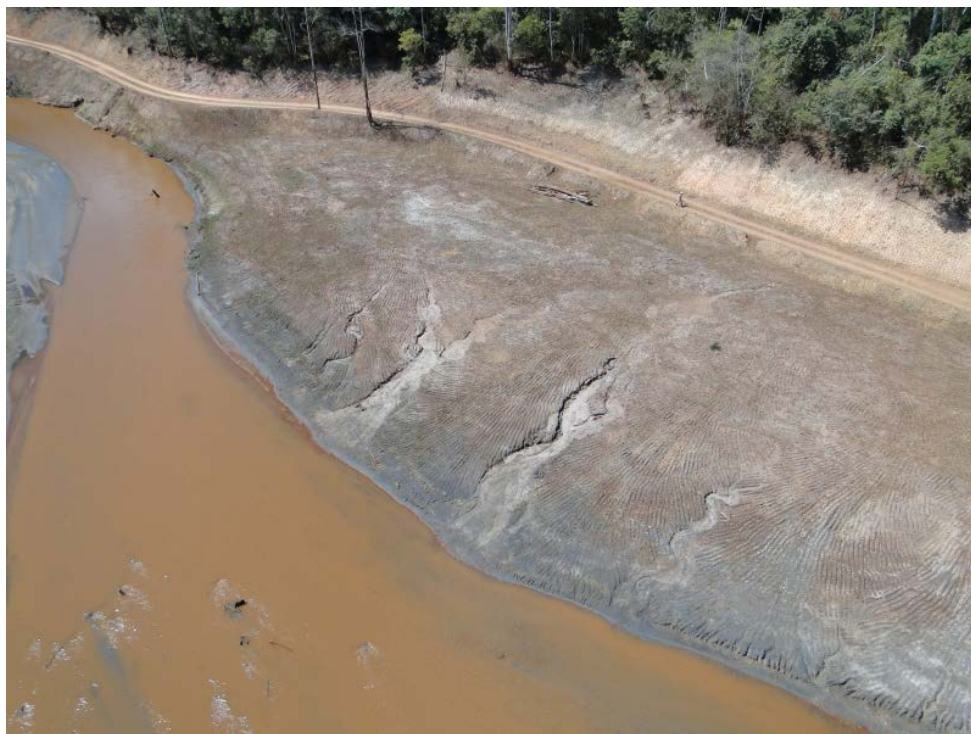
Figura 21. Planície aluvionar preparada para o plantio, com desenvolvimento de erosão em sulcos pela concentração do escoamento superficial. Trecho 9, próximo à travessia do gasoduto
