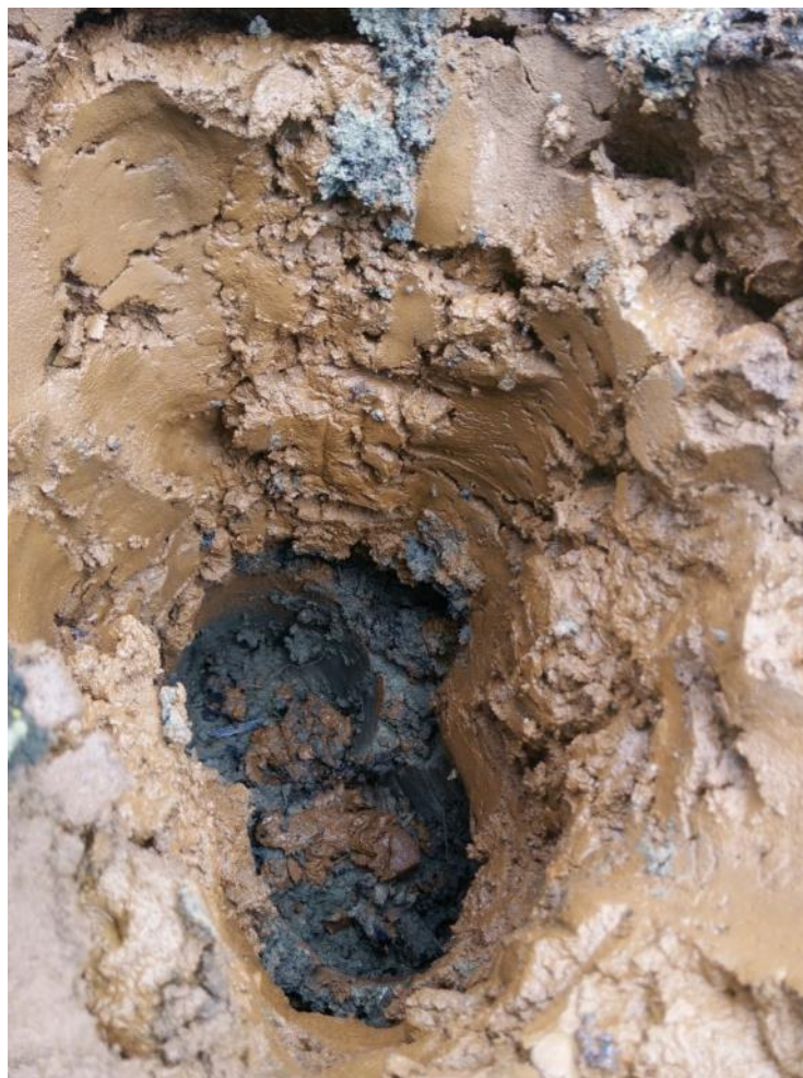
Foto 13: Exemplo do rejeito de colocação marrom avermelhado e solo natural (argila cinza) ao fundo da sondagem extracalha
