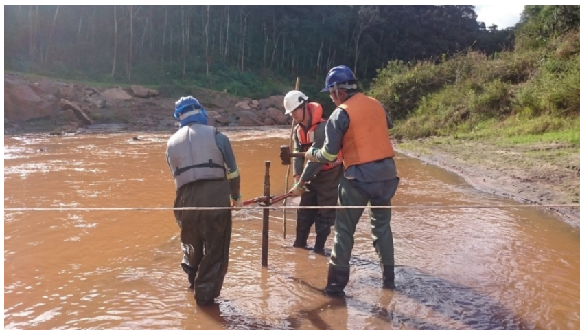
Foto 3: Atividade de sondagem na calha do rio.
