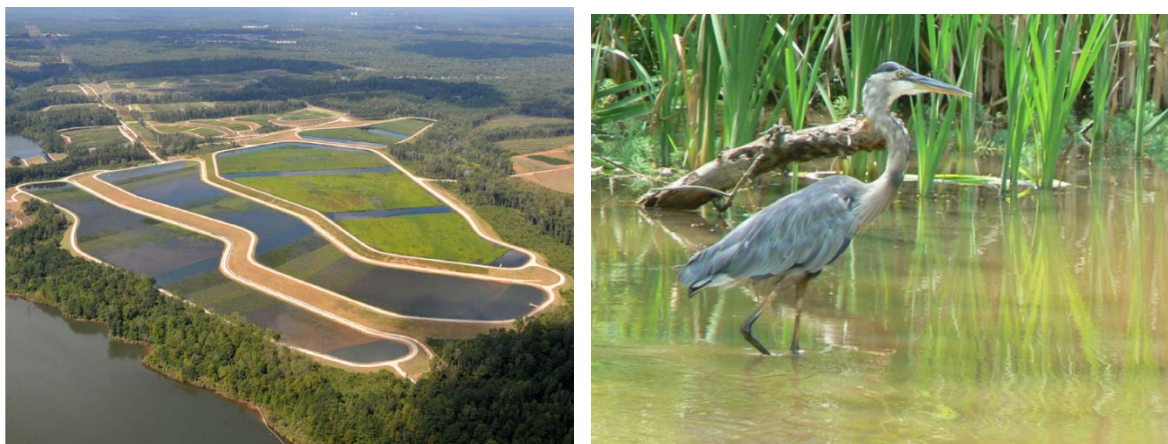
Figura 6: Wetlands Construídos Huie apresentam tratamento primário e secundário
