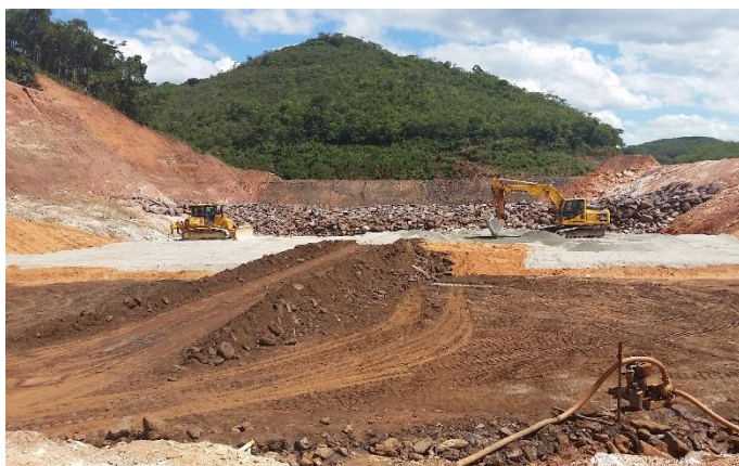
Visão geral do lançamento de brita 0 para a construção do tapete drenante central.
