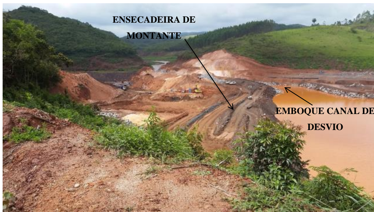
Figura 5.2 – Fotos da Ensecadeira de Montante pós implantação– Sistema de Desvio do Dique S4.
