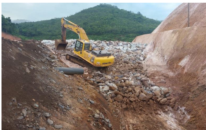
Vista do talude de montante – Maciço Dique S4 – Aterro Blocos Limpos.
