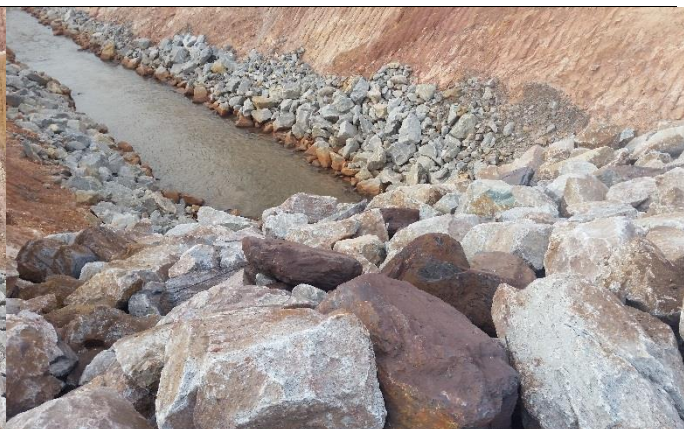
Vista do talude de montante do Dique S4 na região do Canal de Desvio.
