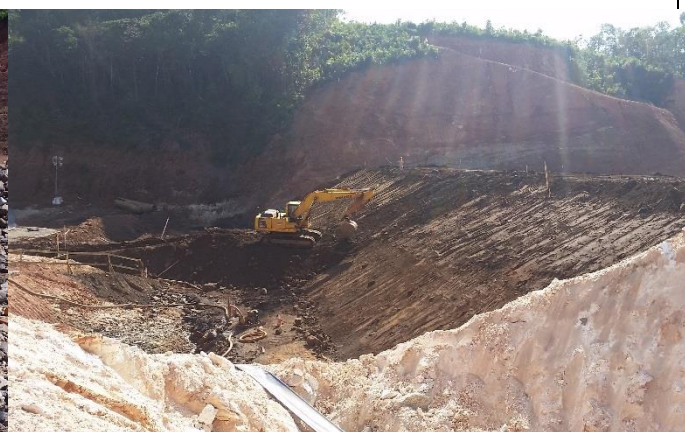
Vista do talude de montante do aterro em bloco com finos.
