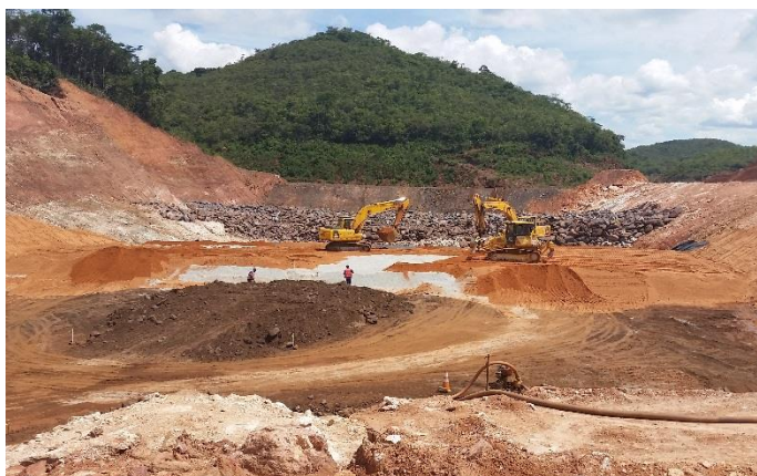
Visão geral das obras de lançamento da camada de transição em areia.
