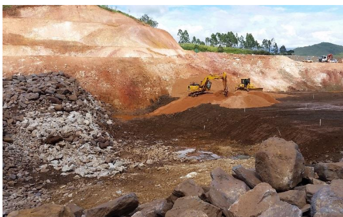
Obras de lançamento da areia para a construção da primeira camada de transição do tapete drenante central e tapetes de ombreira (dia 20/12/16).
