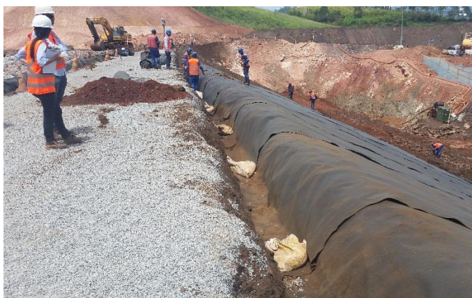
Vista da ancoragem do geotêxtil não tecido aplicado na face de montante na crista do aterro em bloco com finos.
