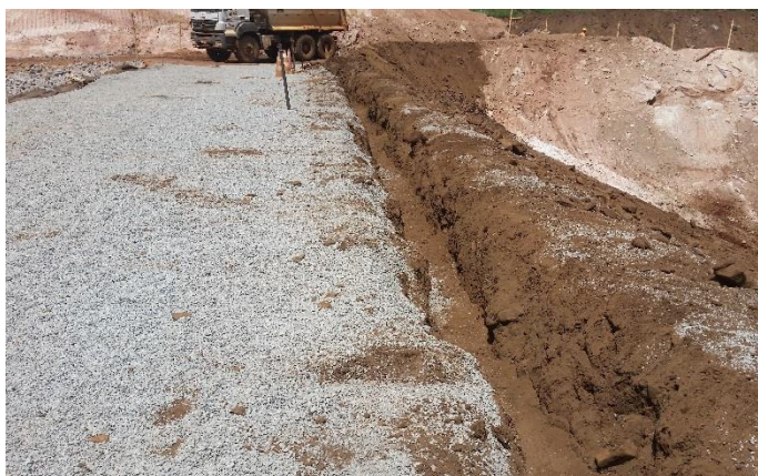
Trincheira de ancoragem na crista do aterro em bloco com finos em contato com o talude de montante.
