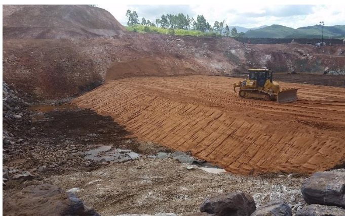
Visão geral do lançamento da areia para a construção do tapete drenante do Dique S4.
