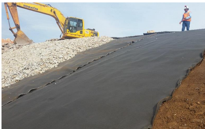
Detalhe da instalação do geotêxtil não tecido na face de jusante do aterro em bloco com finos.
