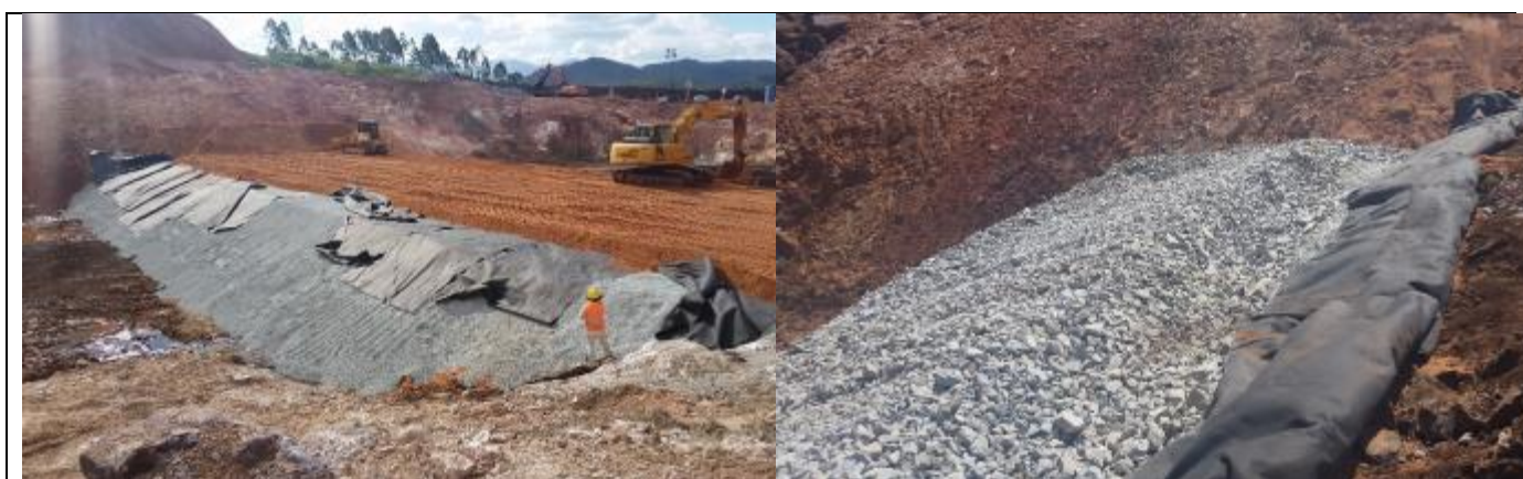
Figura 5.8 – Ancoragem geotêxtil da face de jusante do aterro em bloco com finos.
