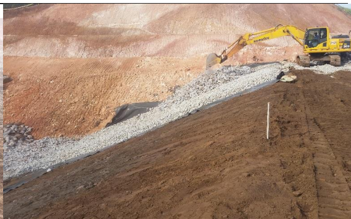
Implantação das transições geotécnicas em geotêxtil não tecido e brita 3 sobre o talude de jusante do aterro em bloco com finos.
