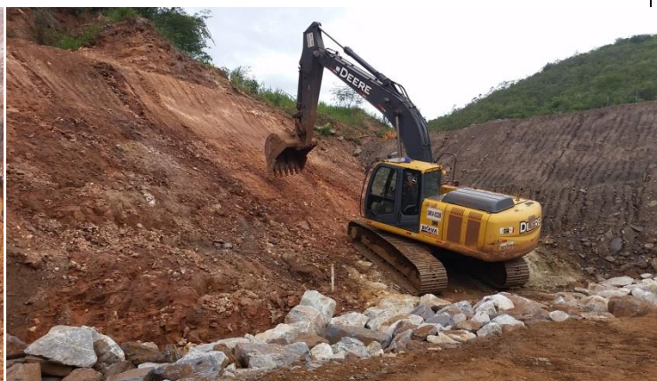
Escavação talude natural da ombreira Esquerda do Dique S4 na região da bacia de dissipação.
