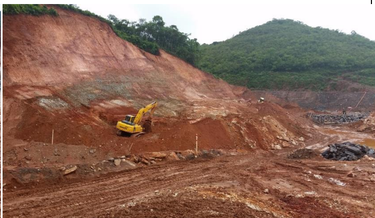
Visão das obras de escavação na região da ombreira esquerda do Dique S4..
