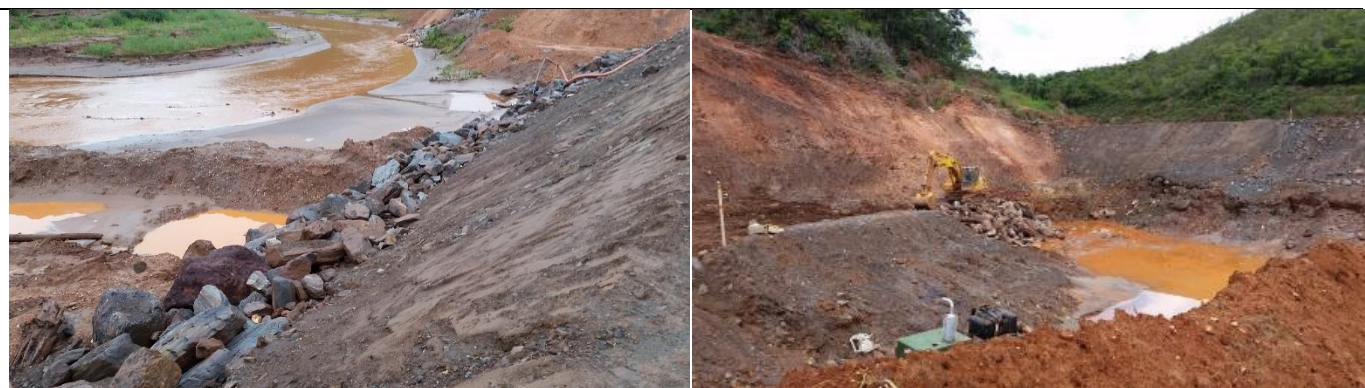
a)- Vista talude de jusante e proteção em blocos b)- Vista do talude de montante e região de limpeza de fundação do Dique S4.
