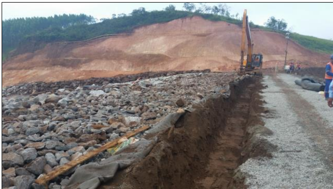
Figura 5.11 – Trincheira de ancoragem para a geotêxtil não tecido. Vista do talude de jusante.
