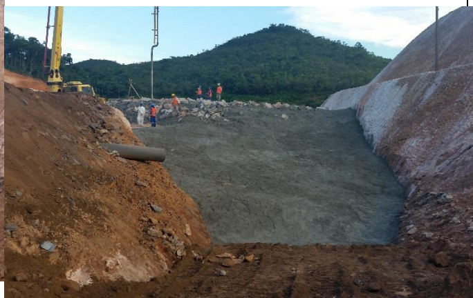
Impermeabilização da face com concreto.
