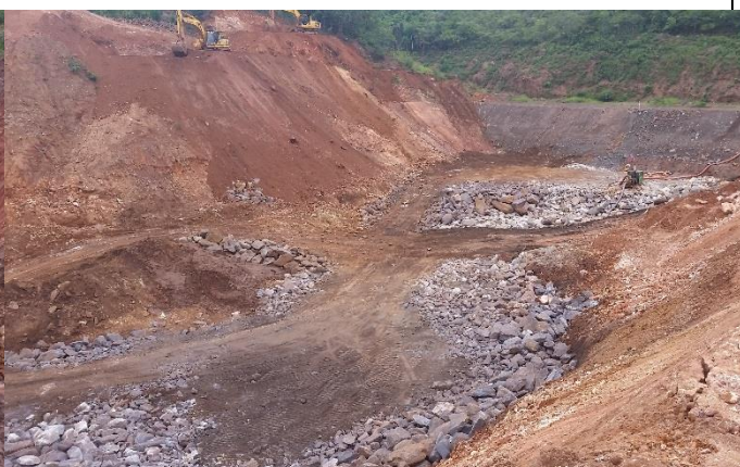
Vista geral das atividades de preenchimento das escavações realizadas no fundo do talvegue do córrego Santarém com blocos limpos.
