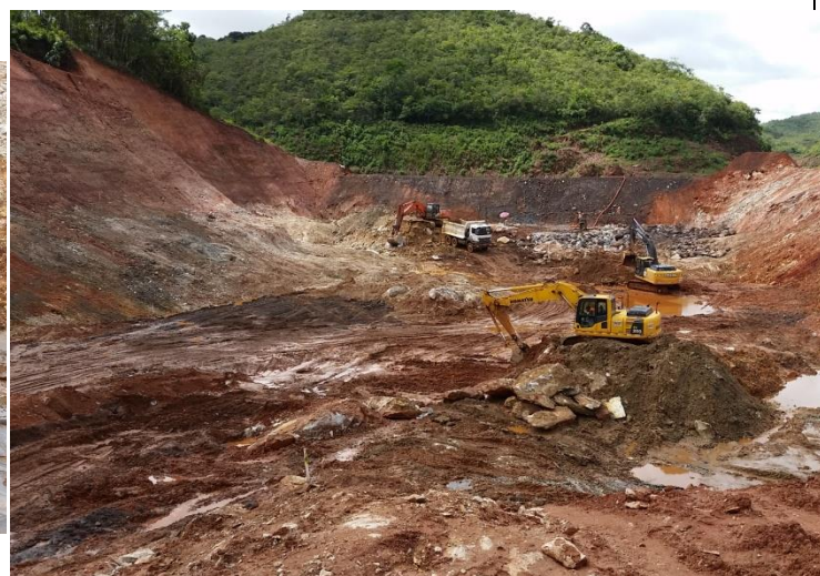
Visão geral da região de limpeza de fundação ao término das atividades em 10/12/16. Ao fundo observa-se a enscadeira de jusante já executada.
