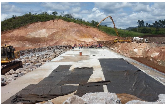
Vista final da laje da soleira vertente do Dique S4, após as obras de concretagem.
