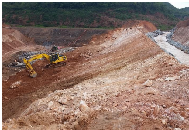
Visão das obras de escavação na região da ombreira direita do Dique S4
