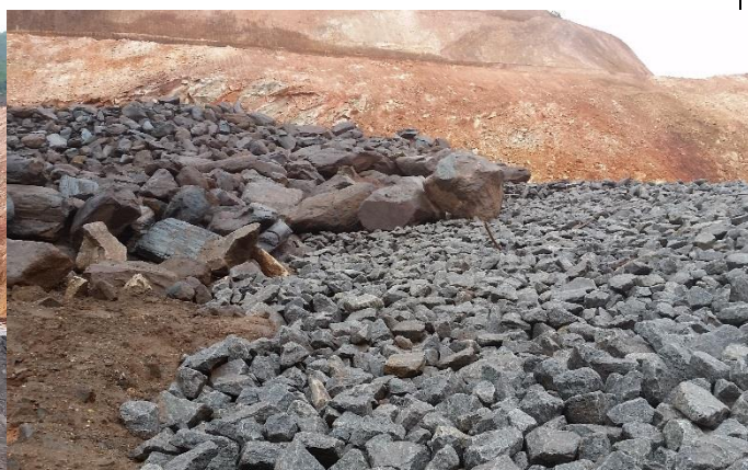
Visão do contato entre o aterro em blocos limpos e pedra de mão.
