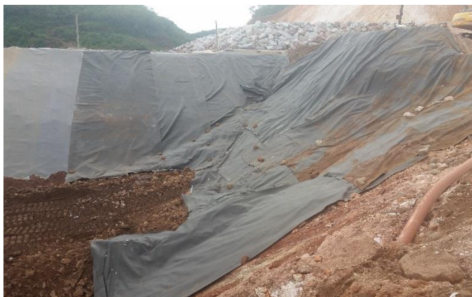
Instalação do geotêxtil para a construção do aterro complementar na porção entre a escavação e o talude de montante do dique na ombreira direita de forma a aumentar o caminho de percolação.
