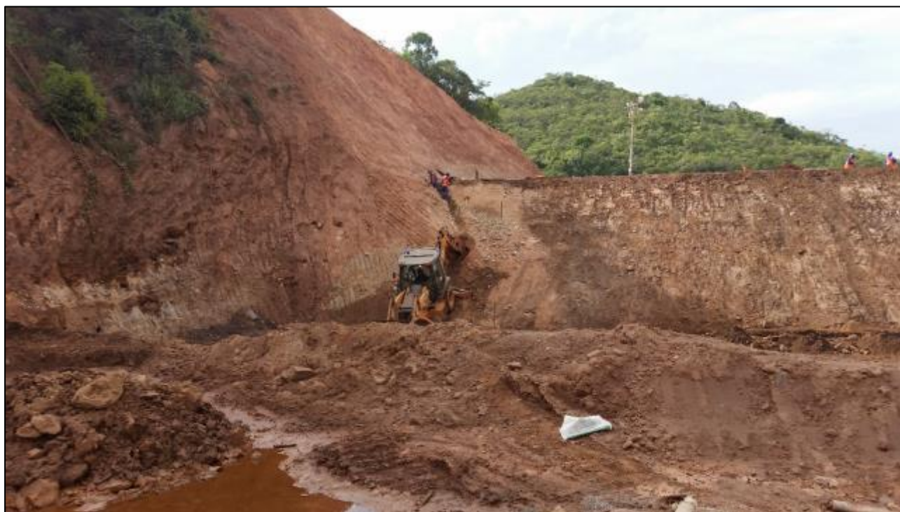
Figura 5.12 – Implantação da ancoragem na região entre o contato do aterro em blocos com finos e a ombreira esquerda, na face de montante do talude.
