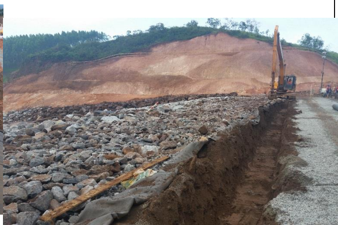
Execução da trincheira de ancoragem para a região do talude de jusante do aterro em bloco com finos.
