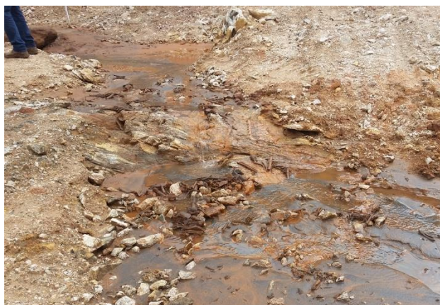
Região de percolação pela fundação e presença de rochas fraturadas na região das surgências observadas na região do Dique S4.
