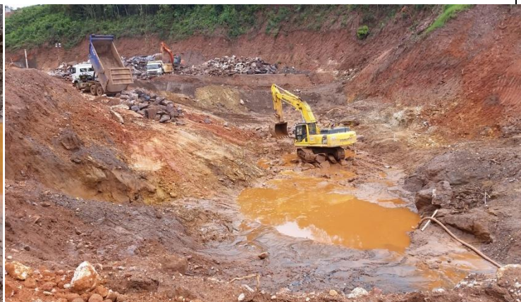
Obras de escavação na porção central do maciço do Dique S4.
