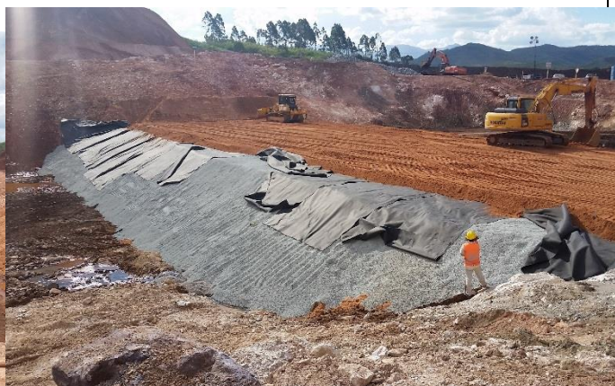
Operação de ancoragem do geotêxtil não tecido com gramatura #500g/m² para a transição entre o aterro em bloco com finos e a brita 0.
