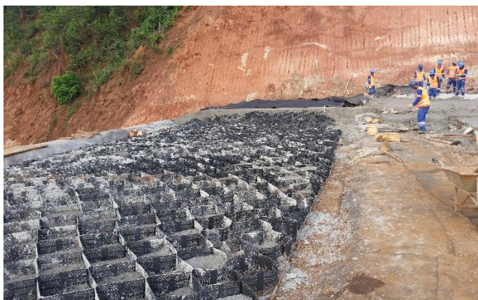
Execução do preenchimento da geocélula e aplicação do concreto ciclópico.
