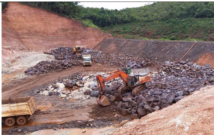
Início das obras de construção da bacia de dissipação com blocos limpos.
