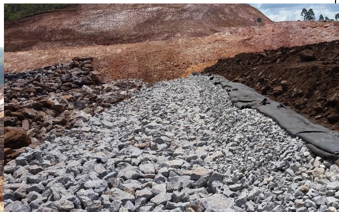
Vista da região a jusante ao aterro em bloco com finos com as camadas de transição e geotêxtil e brita 3 e os materiais do zoneamento e pedra de mão e blocos limpos de 1.200,00 mm.
