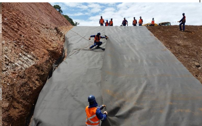
Início da atividade de instalação geotêxtil não tecido no talude de montante do Dique S4 (10/01/17).
