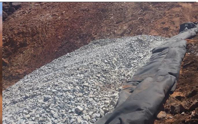
Lançamento da camada de brita 3 como transição do talude de jusante do aterro em bloco com finos.
