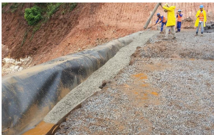
Preenchimento parcial da trincheira de ancoragem com concreto (talude de montante)..
