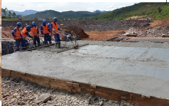
Regularização e adensamento do concreto.
