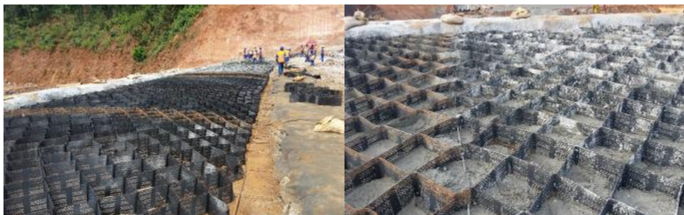
Figura 5.14 – Alteração no sistema de ancoragem da geocélula de PEAD utilizadas para a proteção da crista do aterro em bloco com finos.
