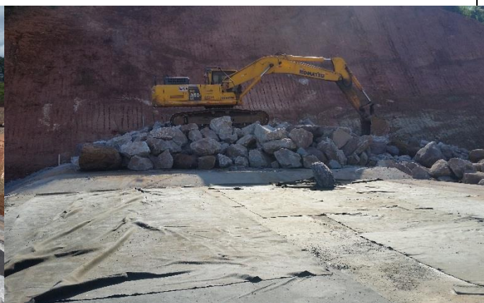
Lançamento dos blocos para a conformação final da crista do Dique S4.
