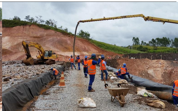
Vista geral da crista do aterro em bloco com finos com as trincheiras de ancoragem.
