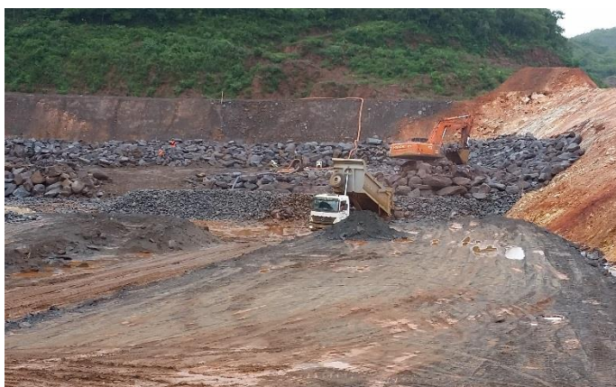
Conformação inicial da bacia de dissipação com blocos limpos.
