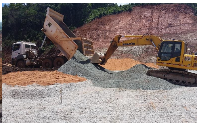
Início do lançamento da camada do núcleo drenante do tapete central em brita 0 no dia 21/12/16.
