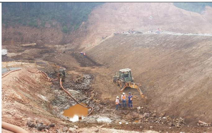
Obras para a trincheira de ancoragem no pé do talude de montante do conjunto geotêxtil / geomembrana.
