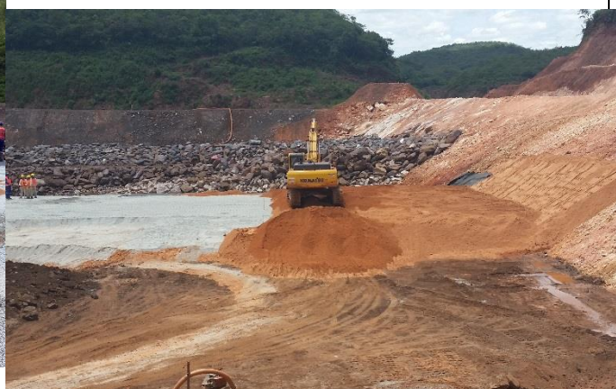
Implantação da camada de transição na região próxima a ombreira direita.
