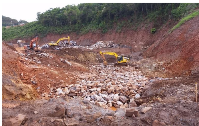
Atividades de preenchimento das escavações abaixo da EL. 687,00 m com blocos limpos.
