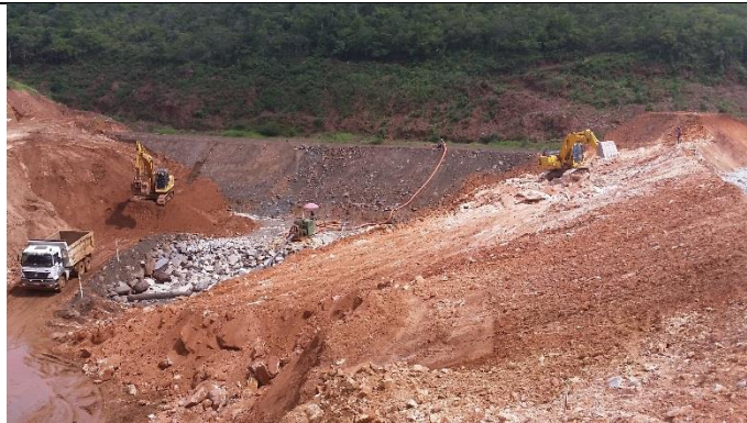
Tratamento de fundação na região da bacia de dissipação.
