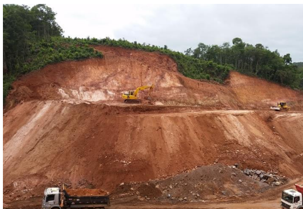
Visão das obras de escavação na região da ombreira esquerda do Dique S4.
