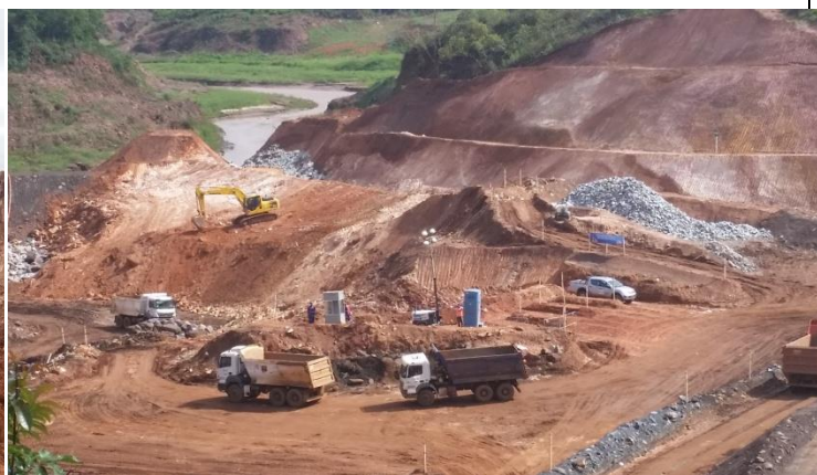
Visão das obras de escavação na região da ombreira
