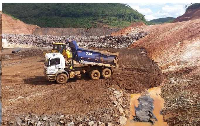
Fechamento do dreno auxiliar (“Charuto”) e complemento do aterro em bloco com finos para o início das obras de construção da drenagem interna.
