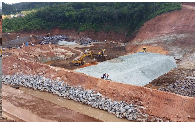
Visão Geral da drenagem interna do aterro em bloco com finos.
