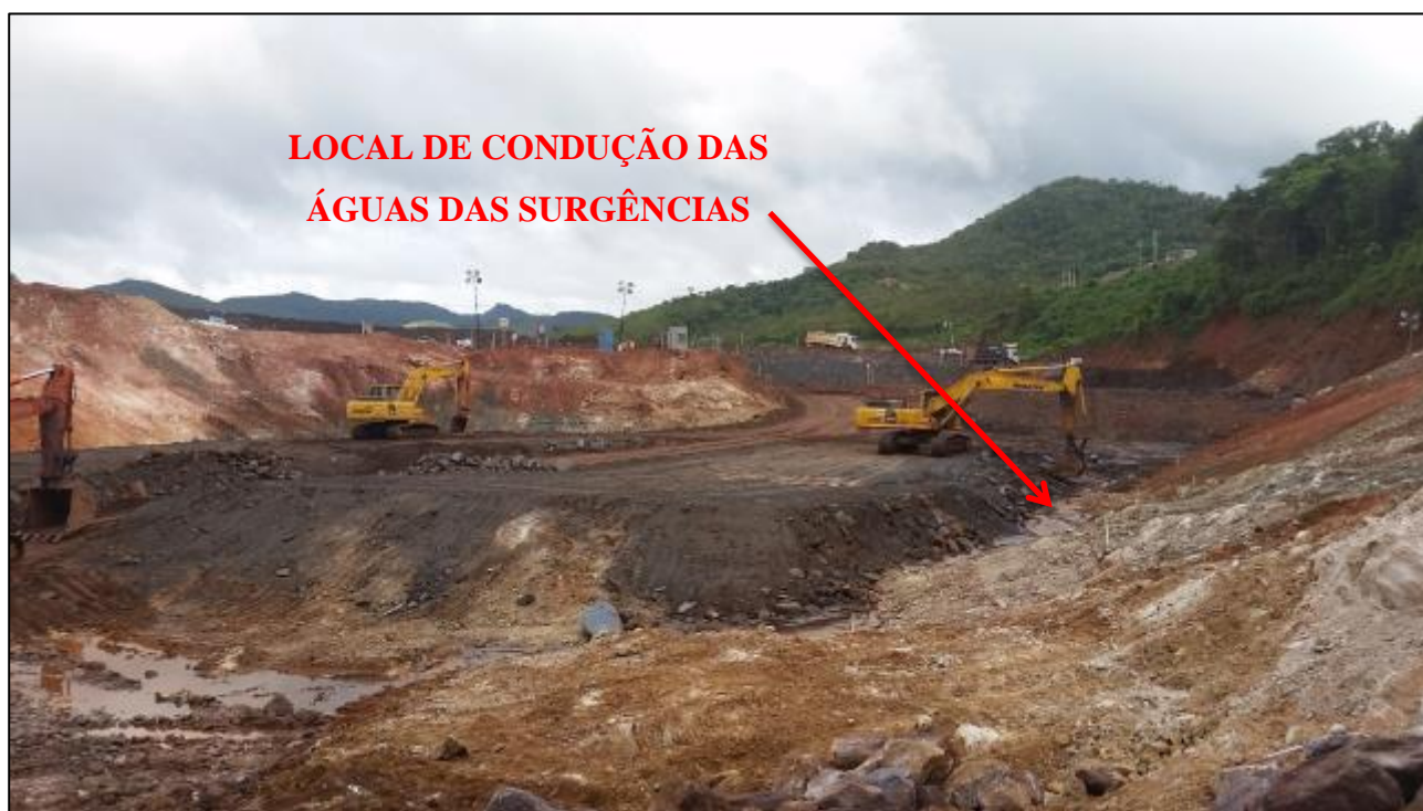
Figura 5.6 – Aterro de regularização em Bloco com Finos e área não preenchida para a coleta e direcionamento das surgências existentes na área de construção do Dique S4.
