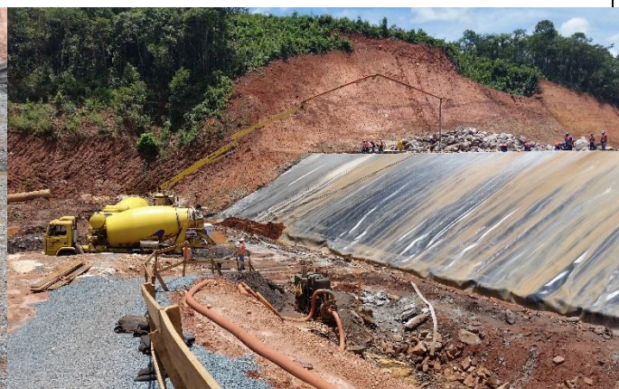
Vista geral do talude de montante após aplicação da geomembrana.
