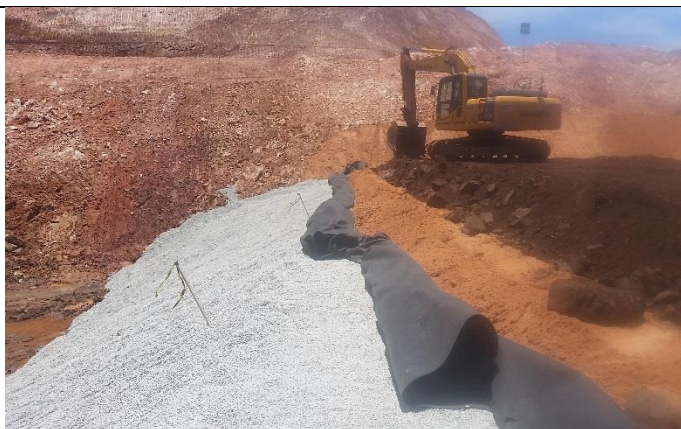
Obras de construção do aterro em bloco com finos sobre o tapete drenante central.
