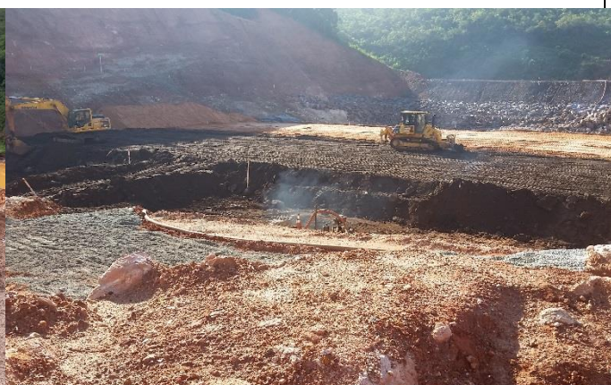
Complemento do aterro em bloco com finos na porção a montante do tapete drenante central.
