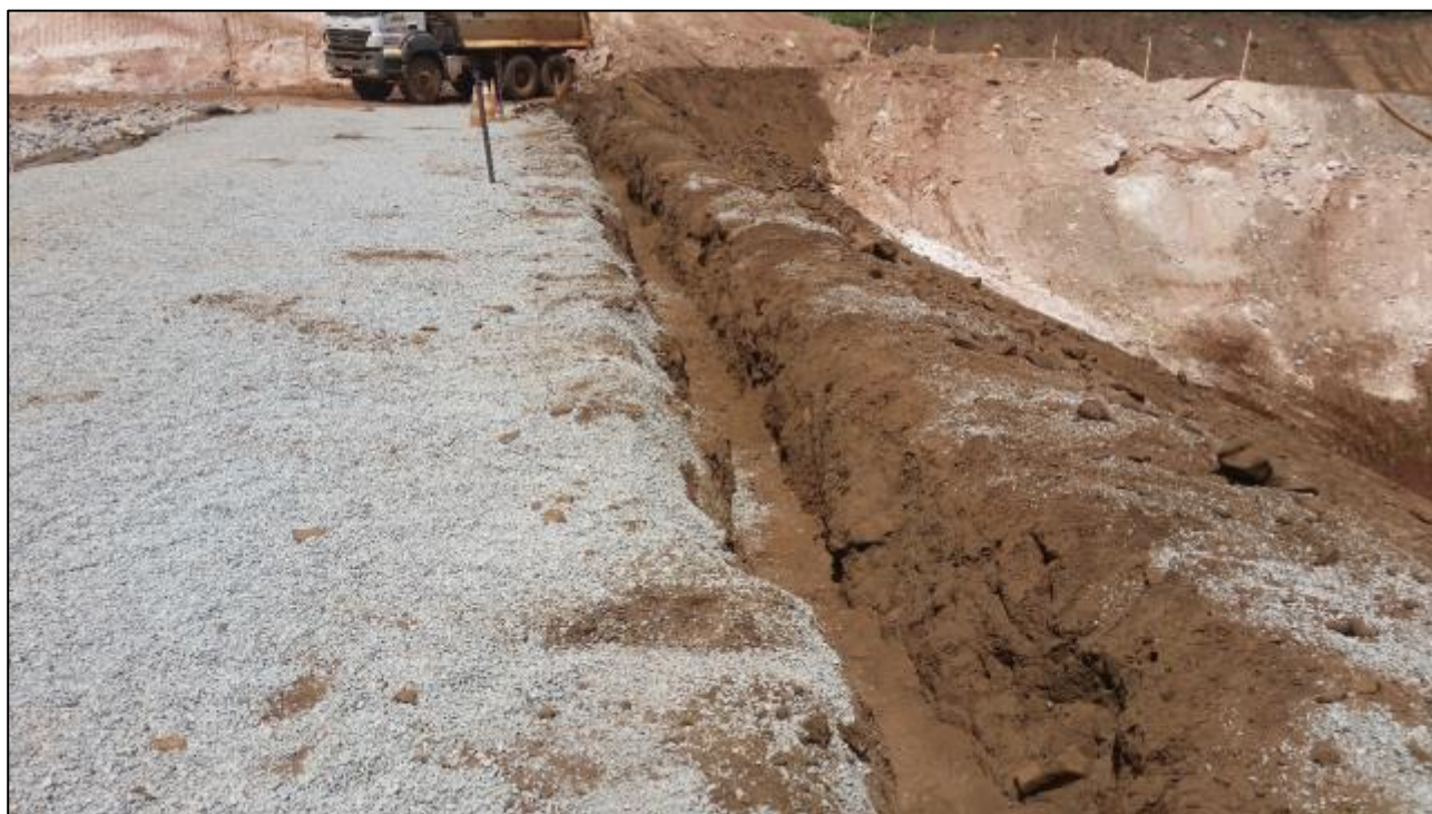
Figura 5.10 – Configuração final da crista do aterro em bloco com finos, após o rebaixamento do aterro, com a trincheira de ancoragem implantada. Vista do talude de montante.
