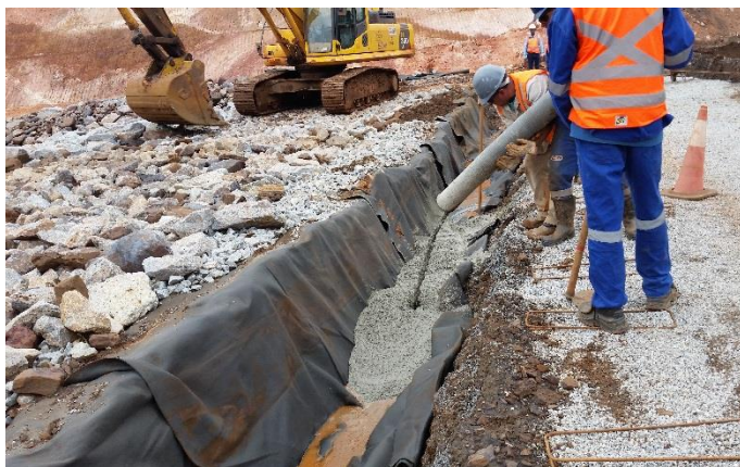
Preenchimento parcial da trincheira de ancoragem com concreto (talude de jusante).
