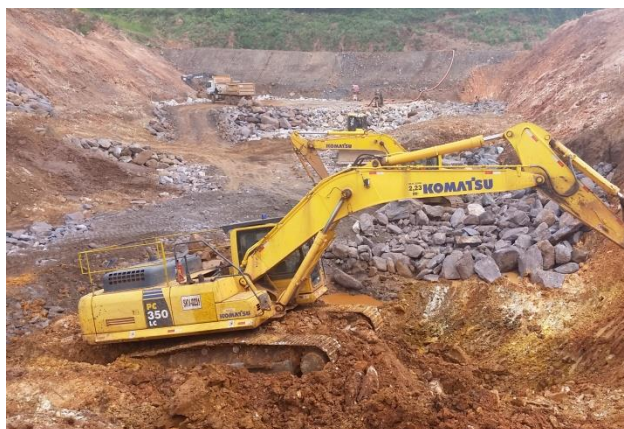
Escavação talude natural na ombreira Direita do Dique S4.
