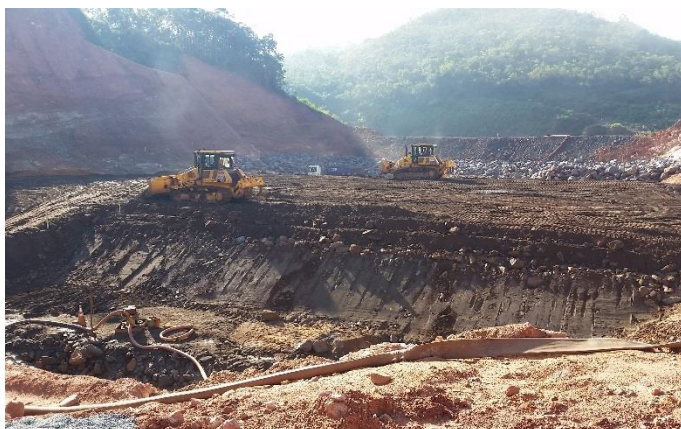
Desenvolvimento do aterro em bloco com finos na porção de montante do Dique S4.
