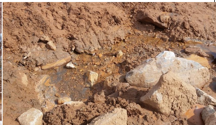
Surgências identificadas na fundação do Dique S4.
