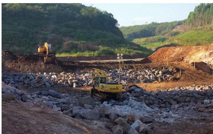
Obras de remoção da encadeia de jusante.
