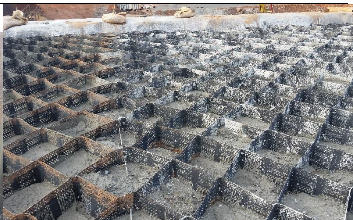
Vista do preenchimento em concreto e detalhe do tendão de ancoragem em aço CA-50 de 5,00 mm.
