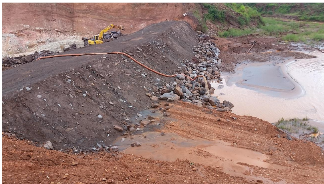
c)- Ensecadeira de Jusante – vista do talude de jusante, a partir da ombreira direita. Observa-se o fluxo do Rio Gualaxo do Norte mais a direita e a água bombeada da fundação do dique sendo descarregada imediatamente a jusante da ensecadeira.
