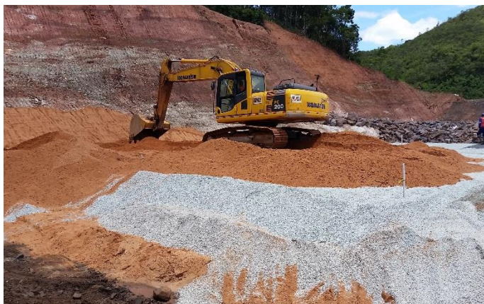
Início das atividades de lançamento da areia para a transição geotécnica no tapete drenante central (22/12/16).
