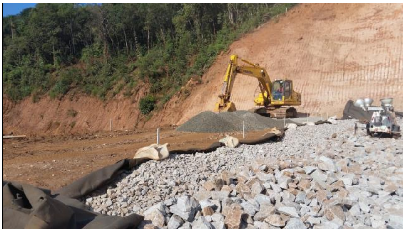
Figura 5.9 – Aterro de complementar da crista do zoneamento do Dique S4 em bloco com finos com brita 0.
