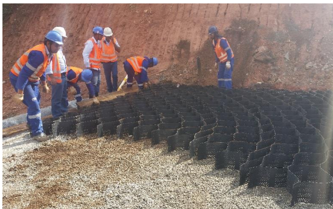
Instalação da geocélula.
