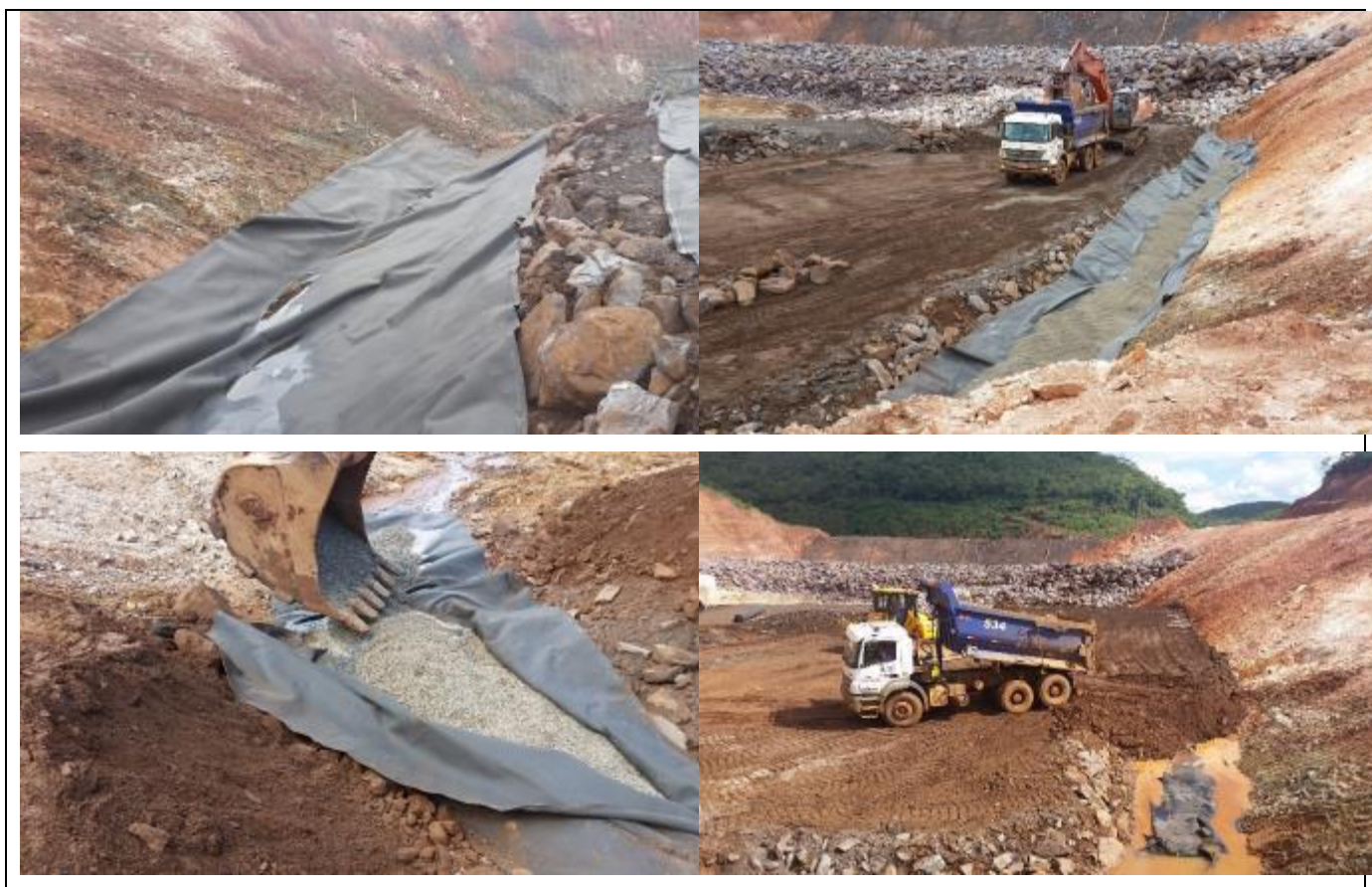
Figura 5.7 – Construção dos drenos auxiliares para a coleta e direcionamento das surgências existentes na região para a construção da drenagem interna do aterro em blocos com finos.
