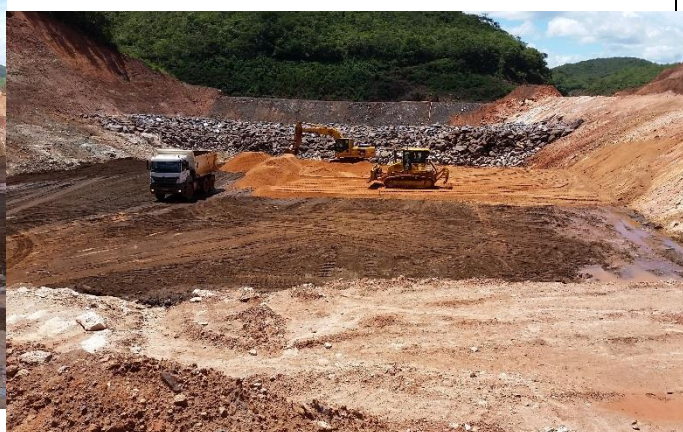
Espalhamento da camada de areia na região do aterro de regularização.
