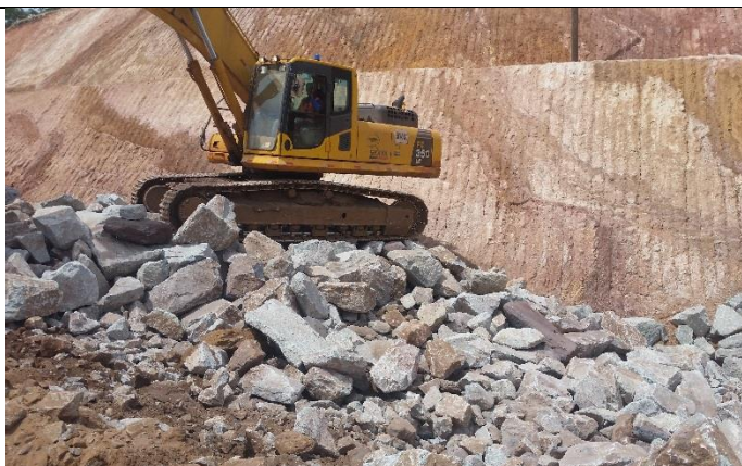
Aterro em Blocos limpos na região do Canal de Desvio.
