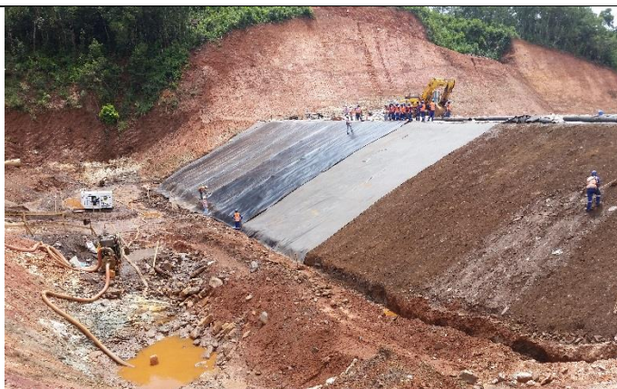
Aplicação da geomembrana na região do talude de montante do Dique S4.
