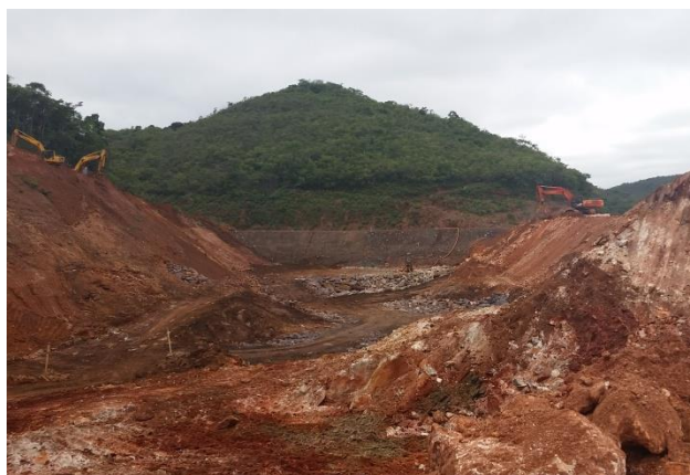
Visão Geral da limpeza da fundação do Dique
