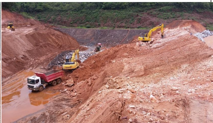
Visão das obras de escavação na região da ombreira direita do Dique S4.
