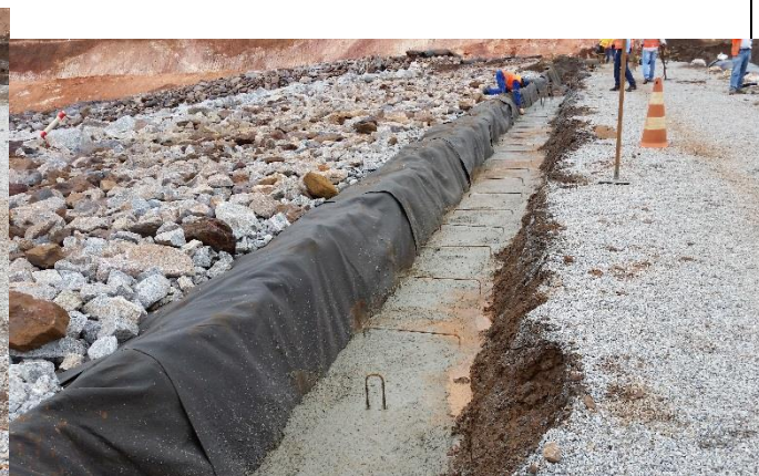
Vista geral da crista do aterro em bloco com finos com as trincheiras de ancoragem.
