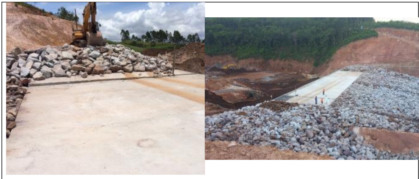
Figura 5.13 – Alteração da seção do extravasor do Dique S4 com o rebaixamento da crista na região da ombreira direita.
