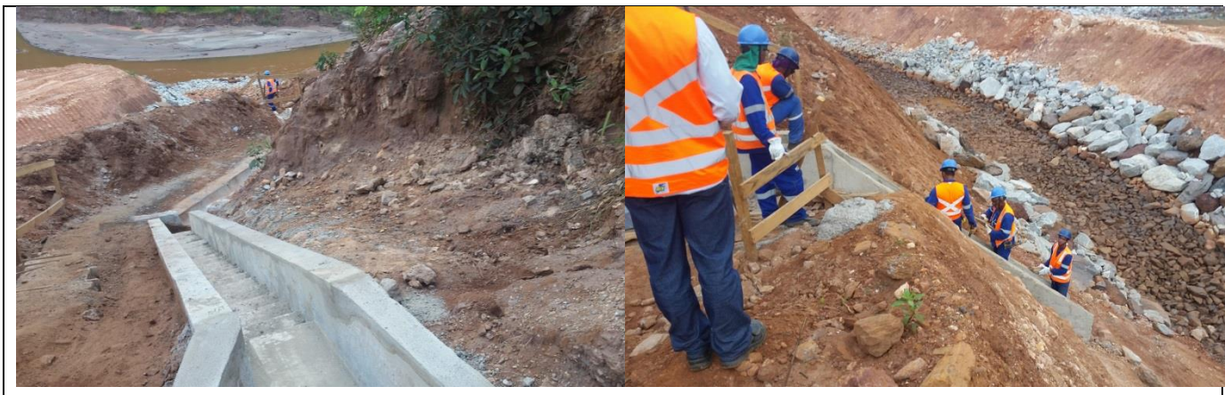
Figura 9.1 – Obras de implantação dos dispositivos de drenagem superficial na região da ombreira direita (porção do canal de desvio).
