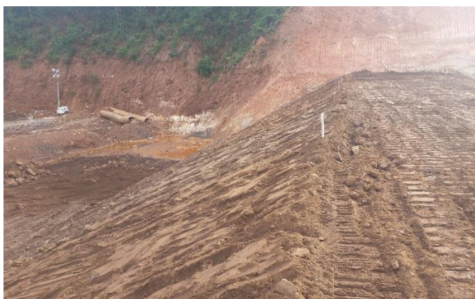
Vista do talude de montante em bloco com finos finalizado.
