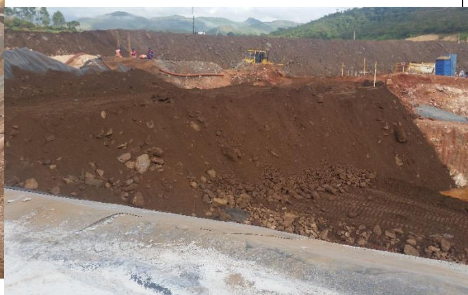
Construção do aterro em bloco com finos com a função de aumentar o caminho de percolação no sentido do canal de desvio.
