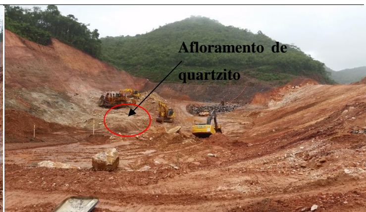
Visão geral das obras de escavação para a limpeza da fundação e taludes de ombreira.
