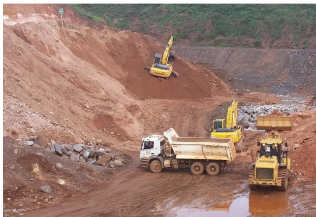
Visão das obras de escavação na região da ombreira esquerda do Dique S4.
