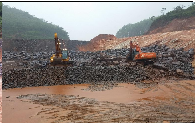
Lançamento de blocos limpos e pedra de mão na porção do talude de jusante do Dique S4.
