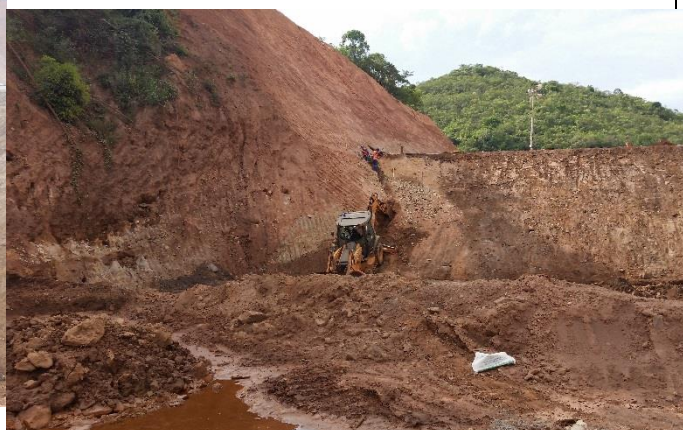
Execução da trincheira de ancoragem na ombreira esquerda.
