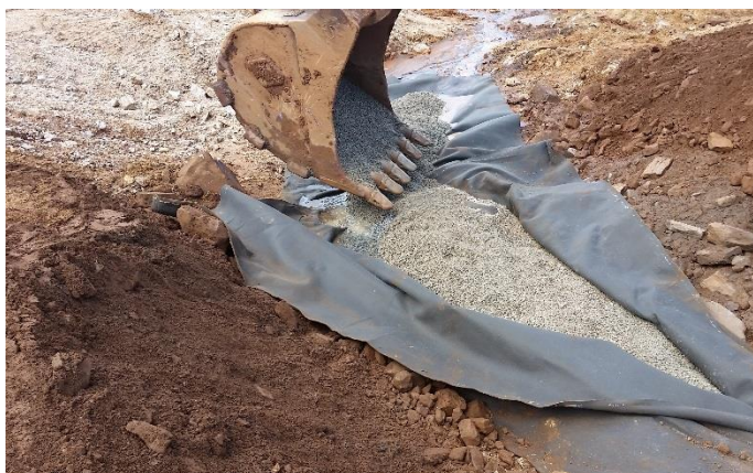
Dobra do geotêxtil para a formação do “Charuto” para a condução das surgências.
