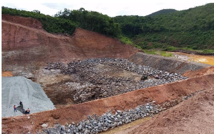
Conformação da bacia de dissipação com blocos limpos.
