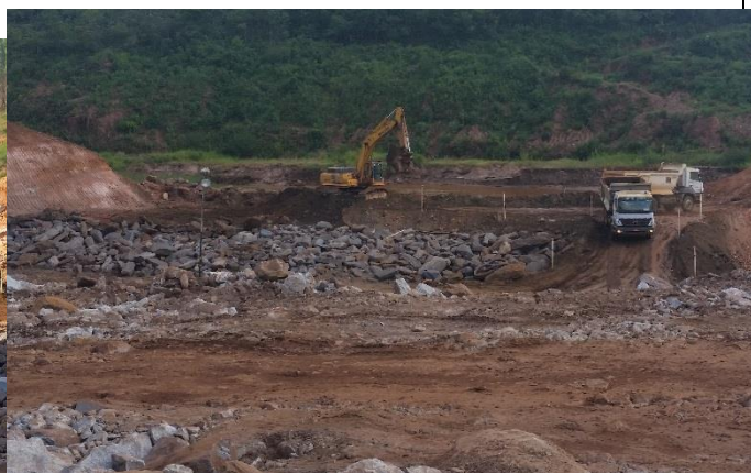
Termino das atividade de remoção da encadeia de jusante (06/01/17).
