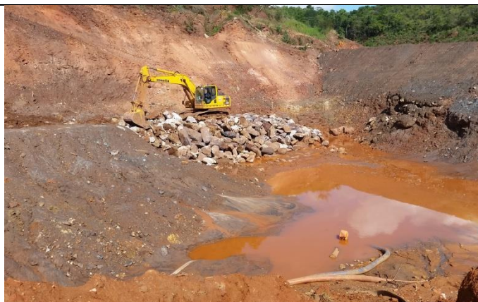
Início das obras de tratamento de fundação com blocos limpos na região da bacia de dissipação do Dique S4.
