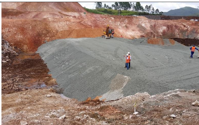
Visão geral do lançamento do núcleo drenante em Brita 0.
