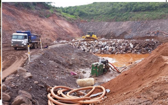
Aplicação dos blocos limpos na região da bacia de dissipação do Dique S4.
