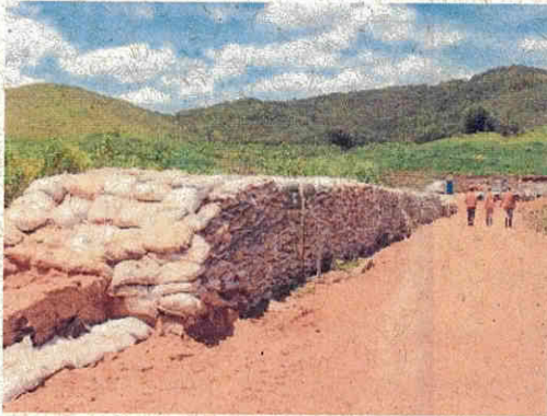
Figura 7- Vista da técnica riprap ainda exposta
