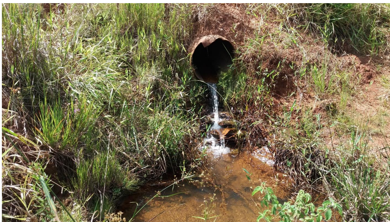
Figura 13: Vista de jusante do bueiro do tributário ITS05. Notar pequena queda d'água e poço formados na saída.
