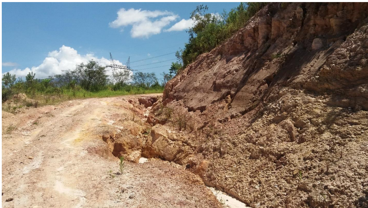
Figura 8: Processo erosivo no acesso ao ponto ITS03.
