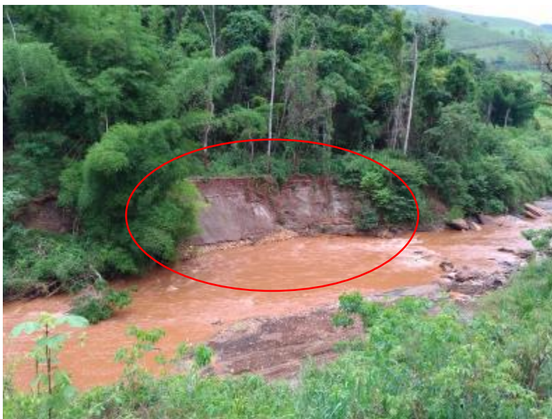
Figura 128 – Talude com problema de estabilidade devido à erosão em seu pé
