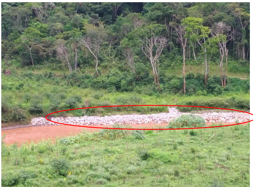
Figura 103 – Vista geral de um enrocamento com descida de água implantado na Área Não Prioritária
