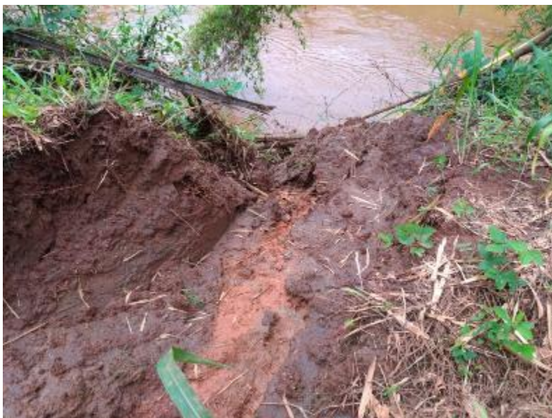
Figura 126 – Erosão por falta de drenagem adequada na pista
