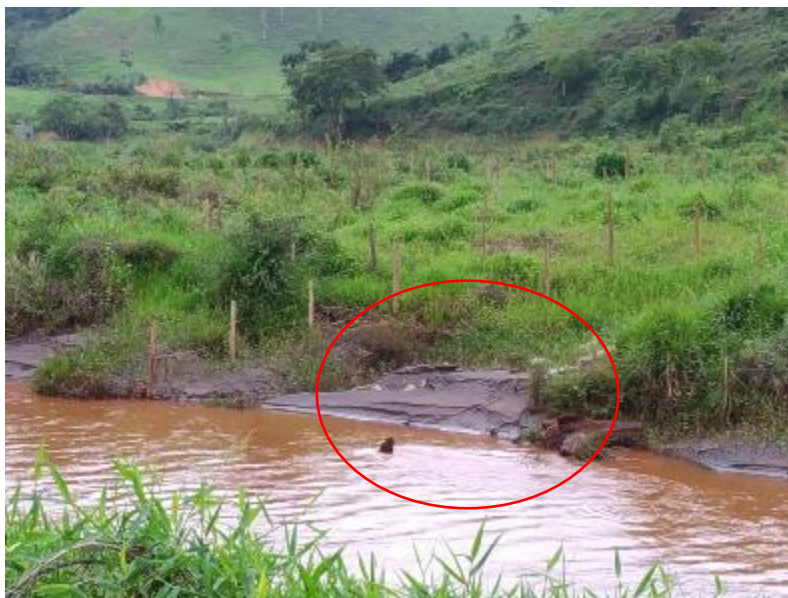
Figura 76 – Vista frontal do desemboque do TG30B com falha na cobertura vegetal
