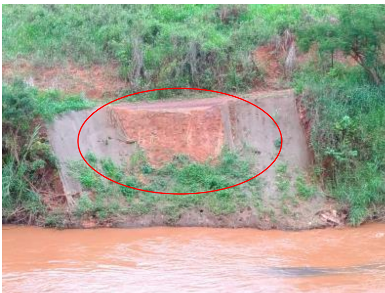
Figura 127 – Manta de proteção superficial do talude com necessidade de reparo
