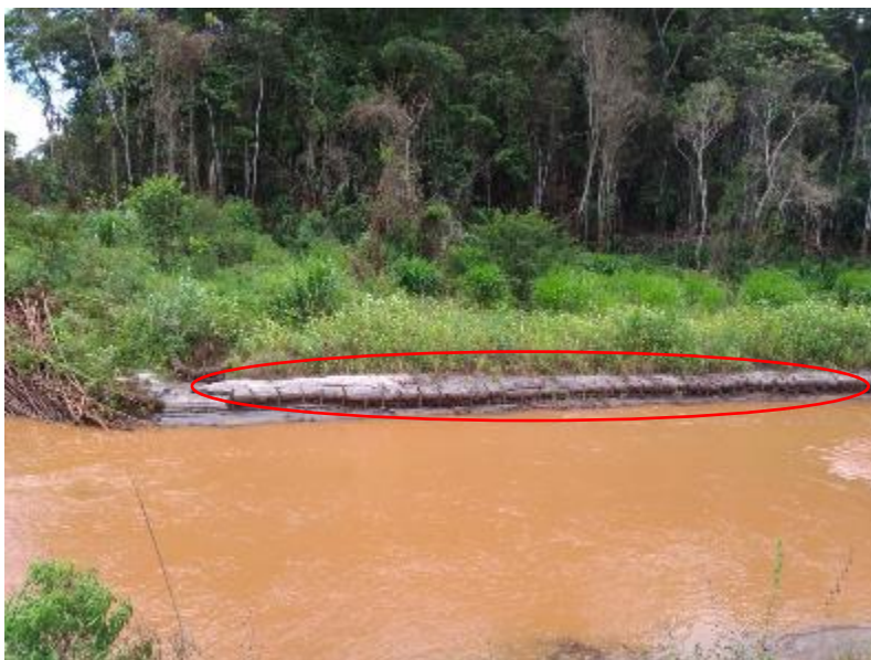
Figura 93 – Retentores de sedimento preenchidos por rejeitos
