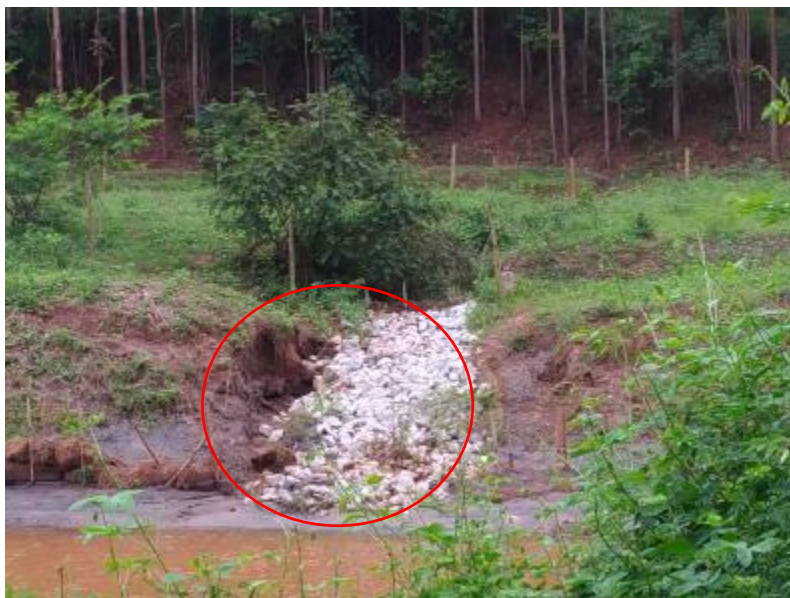
Figura 45 – Erosão em obra de correção na margem direita em frente ao TG17B
