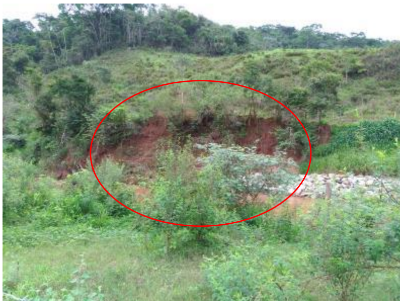
Figura 58 – Talude rompido por erosão no pé, próximo ao TG23
