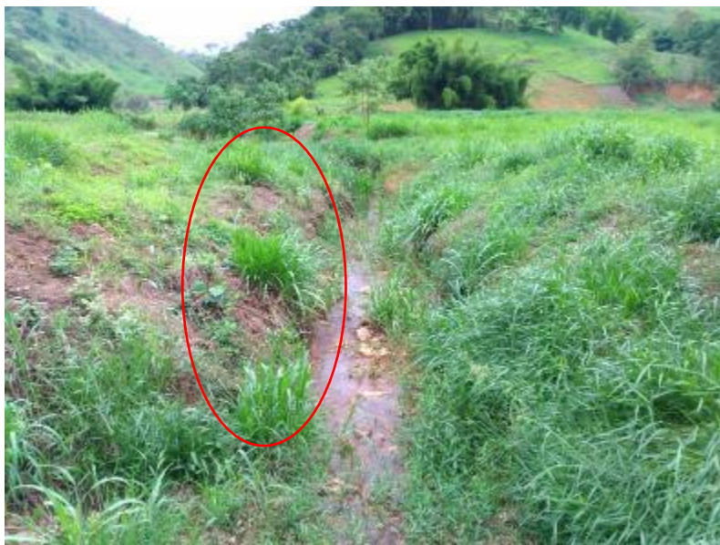
Figura 123 – Tributário TG49F com pontos de falha na proteção de margem
