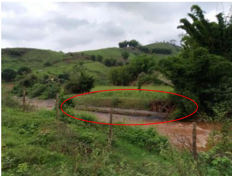
Figura 110 – Retentores de sedimento assoreados
