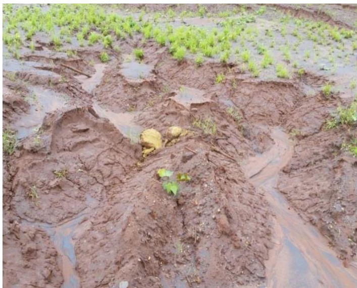
Figura 22 – Cobertura vegetal ainda precoce com desenvolvimento de erosão pela concentração do escoamento superficial
