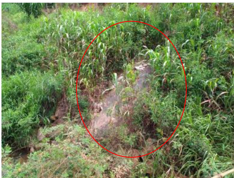
Figura 95 – Descida de água com enrocamento carregado
