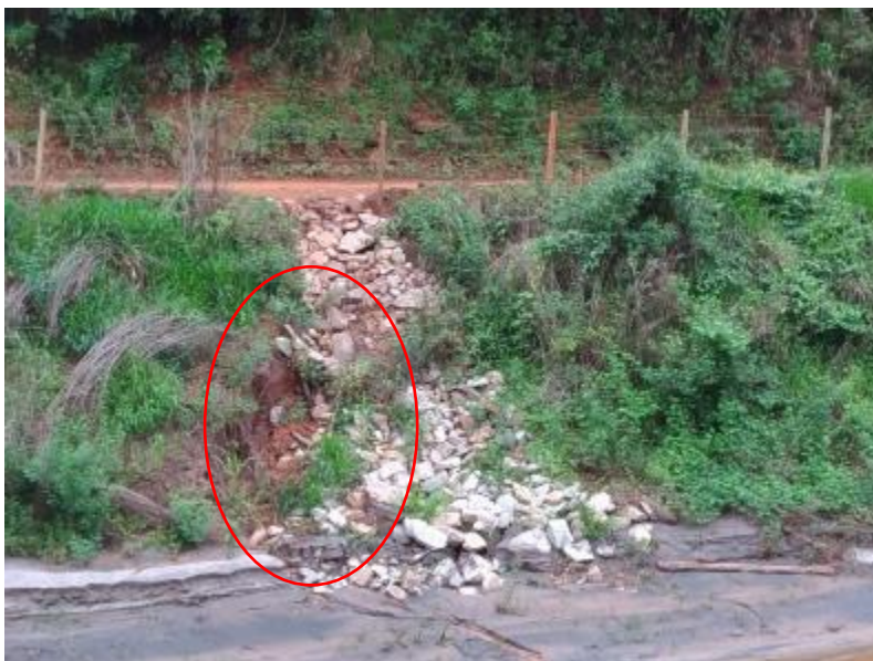
Figura 62 – Erosão de pequeno porte na lateral da descida de água
