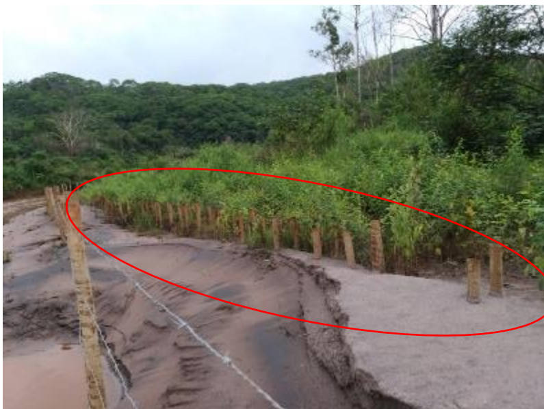
Figura 37 – Retentor de sedimento evitando danos na área tratada.
