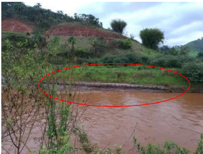
Figura 69 – Retentores de rejeito preenchidos por rejeitos transportados
