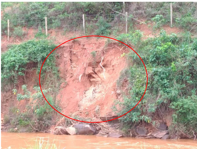
Figura 105 – Talude rompido sem cobertura vegetal que precisa se ajustar
