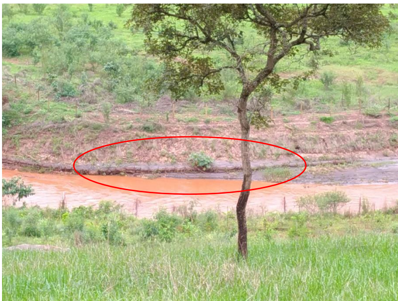
Figura 102 – Retentores de sedimento preenchidos por rejeito
