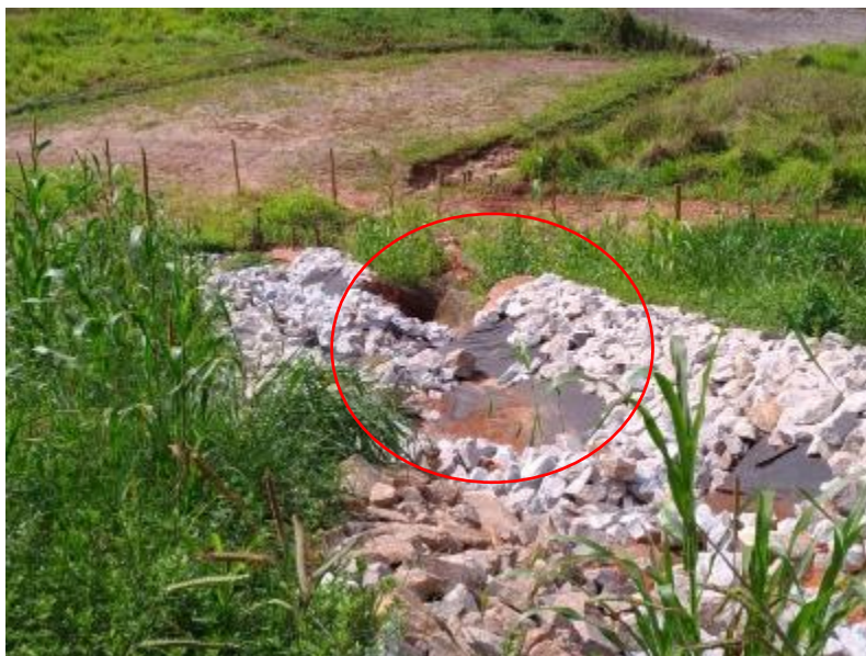
Figura 96 – Descida de água com erosão na margem direita
