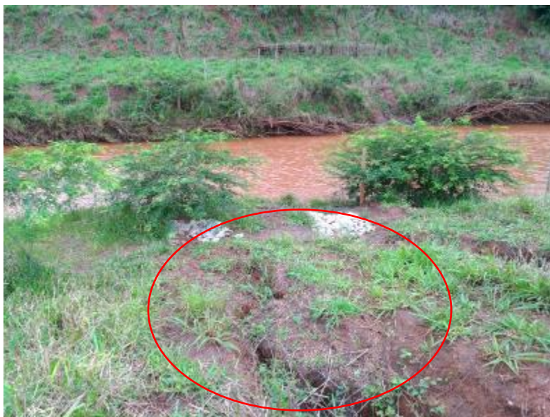
Figura 68 – Região com falha no tratamento da drenagem superficial
