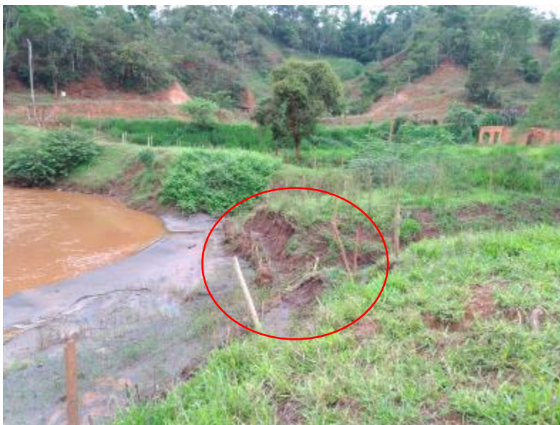
Figura 67 – Região da margem junto ao TG28 que precisa de tratamento
