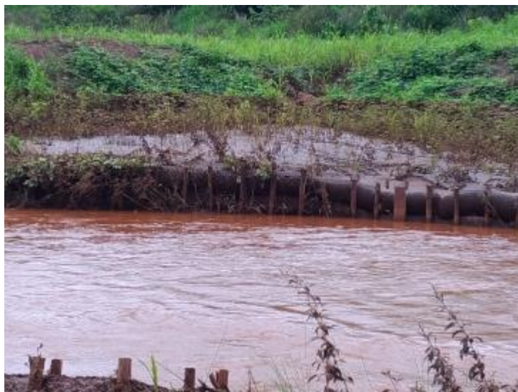
Figura 65 – Margem oposta com falência do sistema superficial de drenagem
