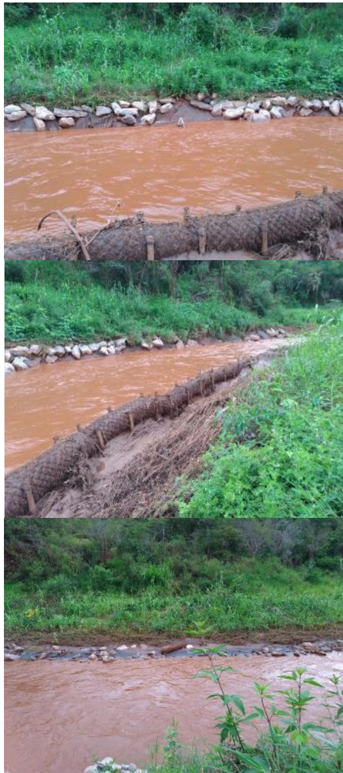
Figura 27 – Enrocamento danificado com exposição de manta sintética
