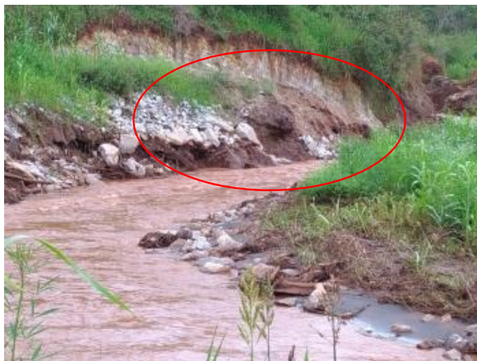
Figura 32 – Talude com erosão no pé com necessidade de tratamento
