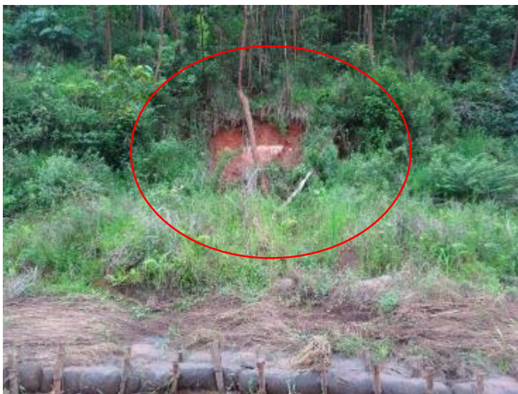
Figura 64 – Instabilidade local de talude
