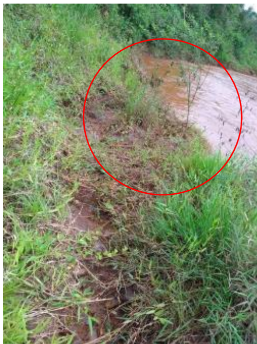
Figura 26 – Ponto com necessidade de remediação com recomendação de enrocamento
