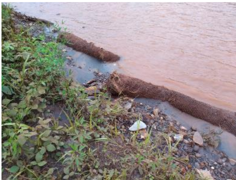
Figura 55 – Retentores transportados para outros pontos do rio
