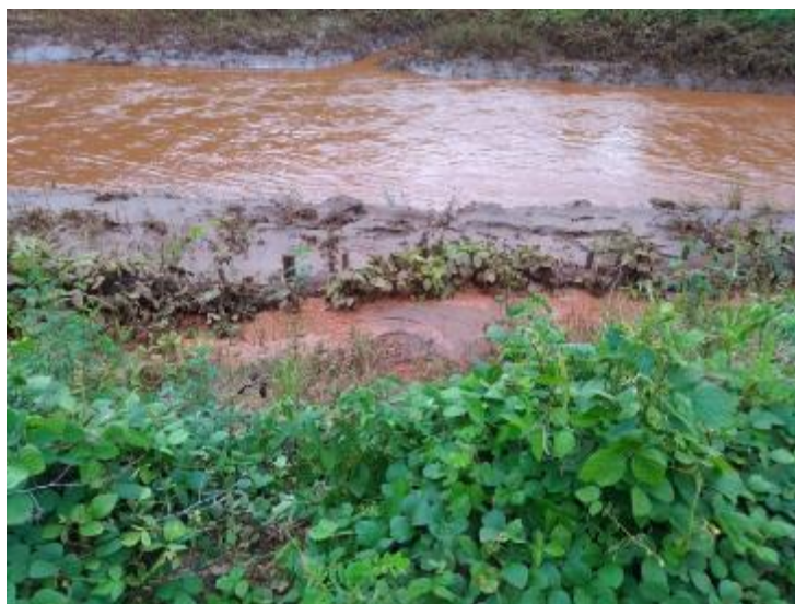
Figura 70 – Retentores preenchidos com sedimento da erosão
