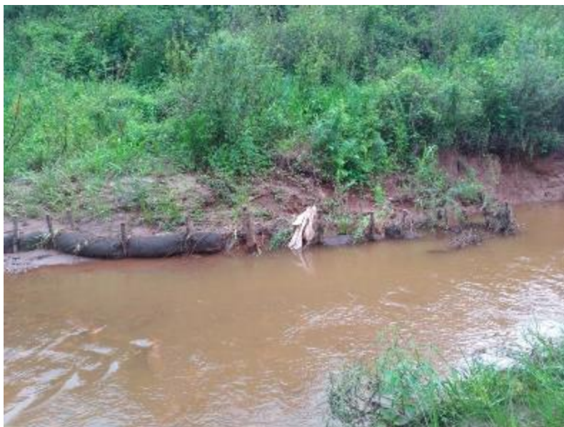
Figura 52 – Retentores de sedimento danificados e princípio de erosão
