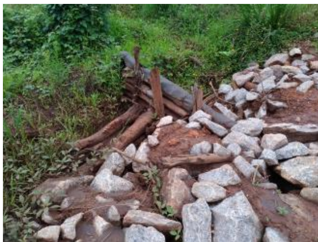
Figura 15 – Enrocamento em bom estado, parcialmente coberto por sedimentos, e barreira sintética em bom estado.
