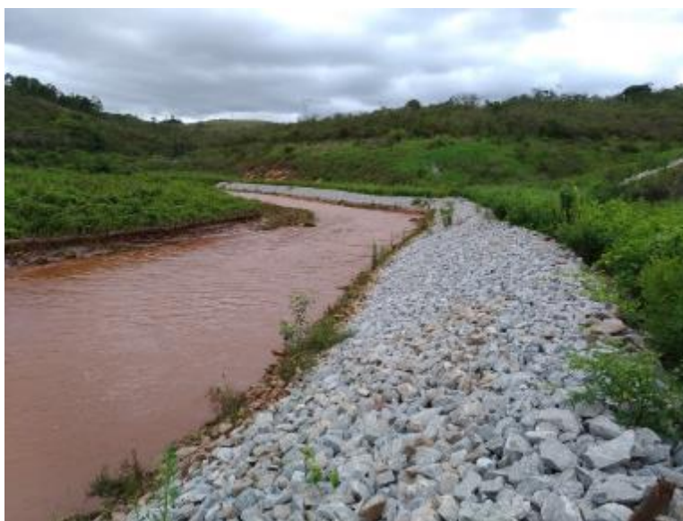
Figura 39 – Enrocamento implantado no leito do rio em excelente estado
