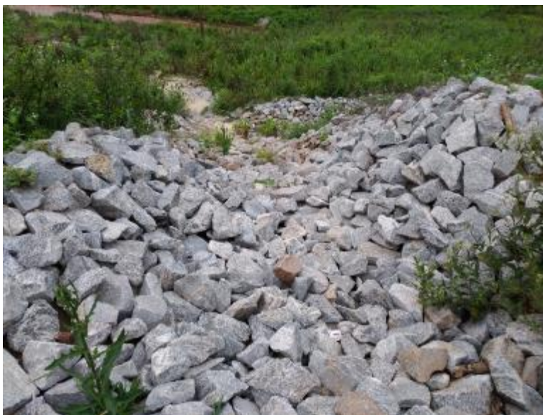
Figura 38 – Enrocamento de drenagem com de areia carregada em seu pé
