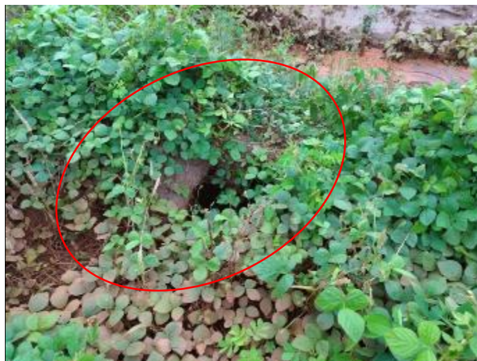
Figura 69 – Falha da drenagem superficial que necessita de remediação
