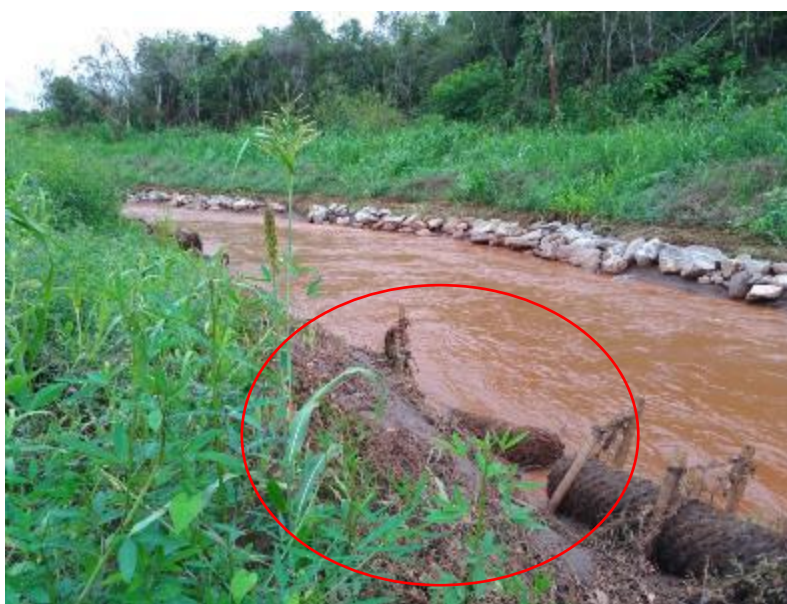
Figura 28 – Região com retentor danificado pela força da água
