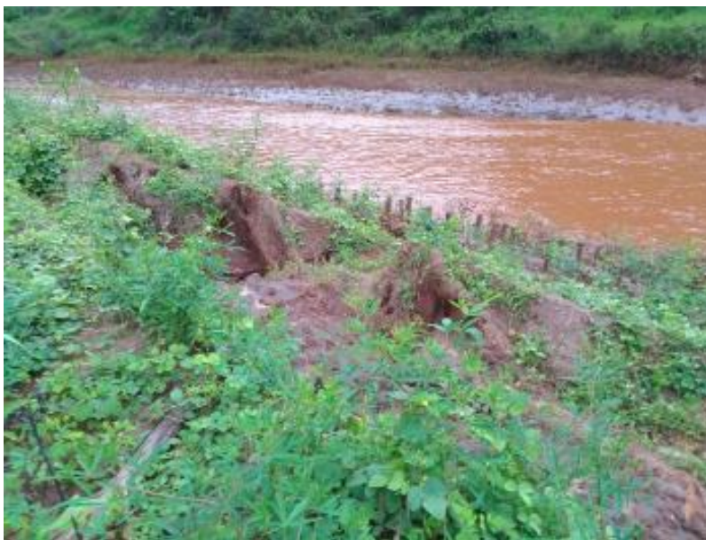
Figura 73 – Erosão com fuga de material
