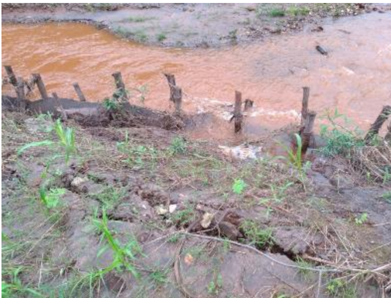
Figura 57 – Retentor de sedimento danificado com movimentação da margem
