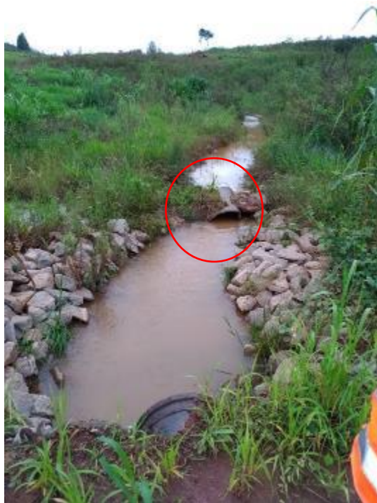
Figura 36 – Local com o tubo danificado
