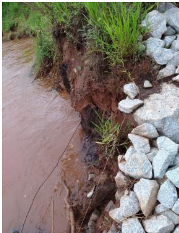
Figura 17 – Detalhe da erosão junto ao enrocamento de proteção – margem esquerda
