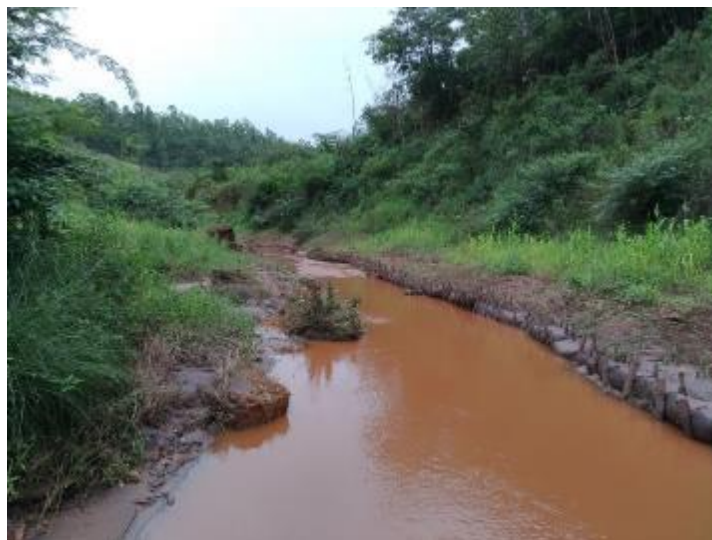
Figura 60 – Linha de retentores assoreados
