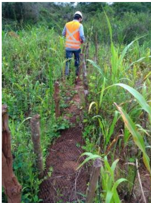
Figura 23 – Linha de retentores de sedimentos incorporada pela vegetação
