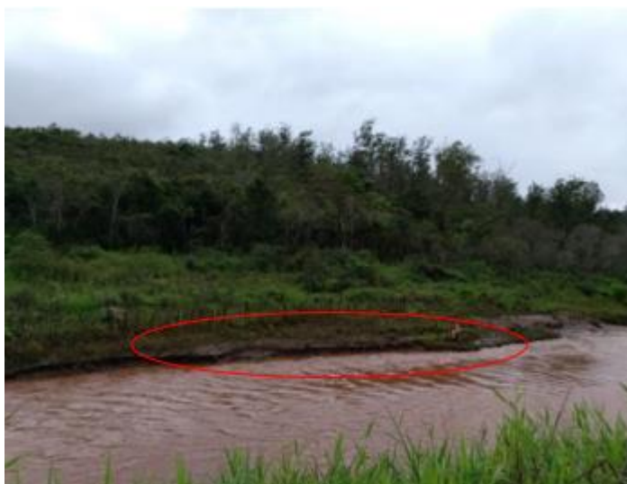
Figura 18 – Região com início de erosão no contato do rejeito com o leito do rio – margem direita
