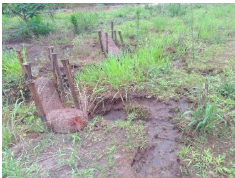
Figura 43 – Retentor de sedimentos danificado e ineficiente
