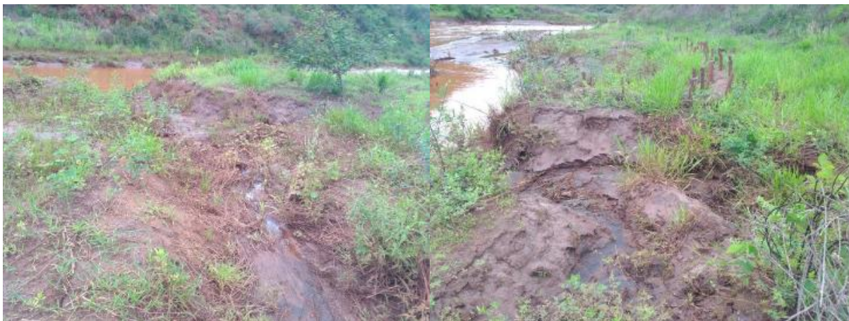
Figura 42 – Drenagem superficial com danos
