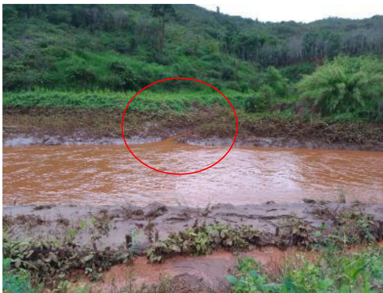
Figura 79 – Necessidade de proteção em seu desemboque do TG07
