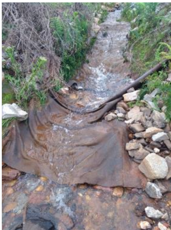
Figura 47 – Manta sintética exposta no tributário TG05
