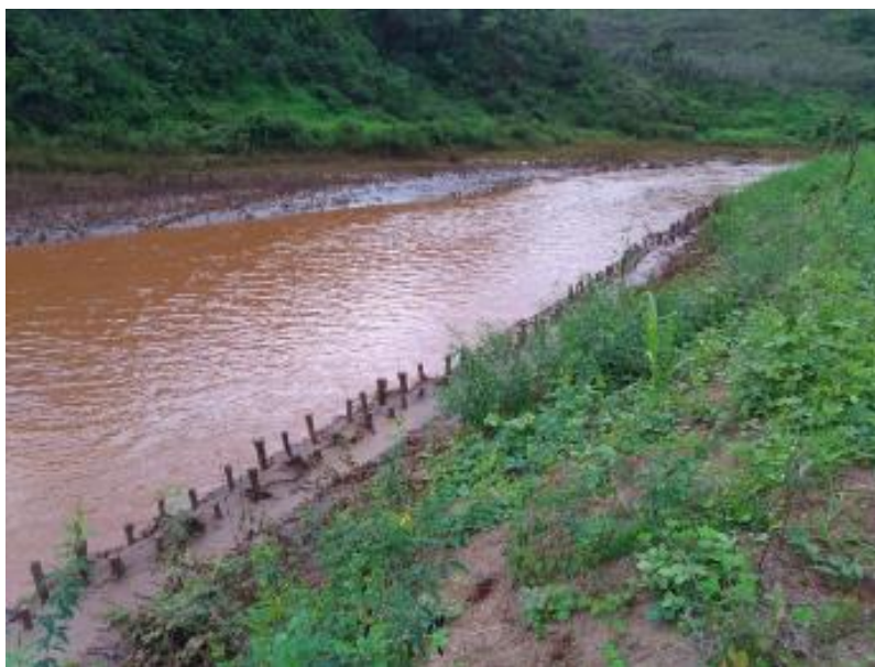
Figura 74 – Linha de retentores preenchidos com rejeitos dos pontos de erosão
