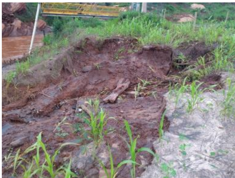
Figura 76 – Erosão de grande porte próxima ao antigo sistema de captação
