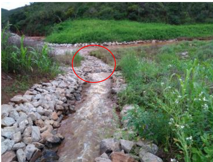
Figura 35 – Blocos deslocados no canal do TG02
