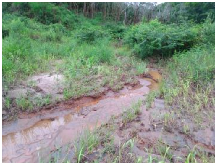
Figura 51 – Canal de drenagem sem proteção gerando carregamento de rejeitos
