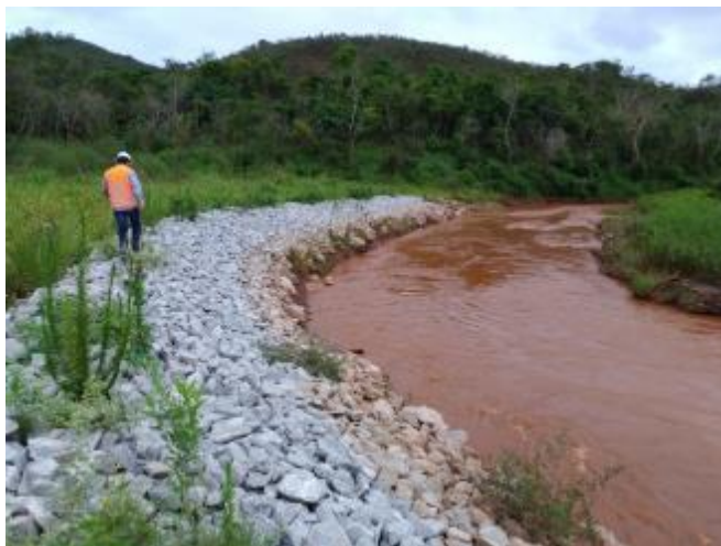
Figura 24 – Enrocamento com demanda de reparo pontual em sua base
