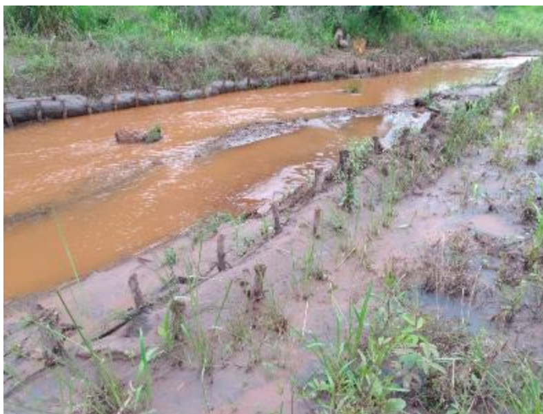
Figura 59 – Linha de retentores danificada com carregamento de rejeitos
