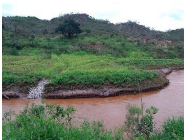
Figura 66 – Drenagem superficial danificada próxima à saída em enrocamento
