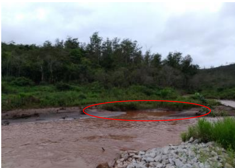
Figura 19 – Erosão sem proteção de enrocamento – margem direita
