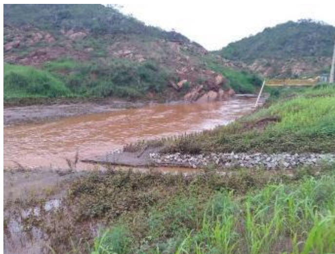
Figura 78 – Enrocamento falho no desemboque do TG06
