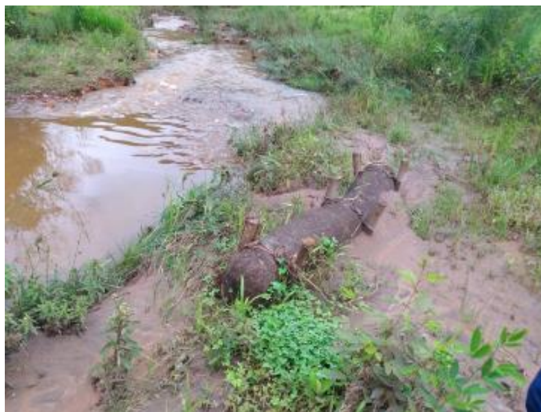
Figura 50 – Retentor no limite de operação com fuga lateral de rejeitos
