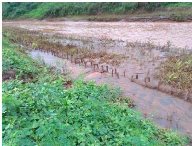
Figura 68 – Retentores de sedimento encobertos pelo rejeito proveniente da erosão
