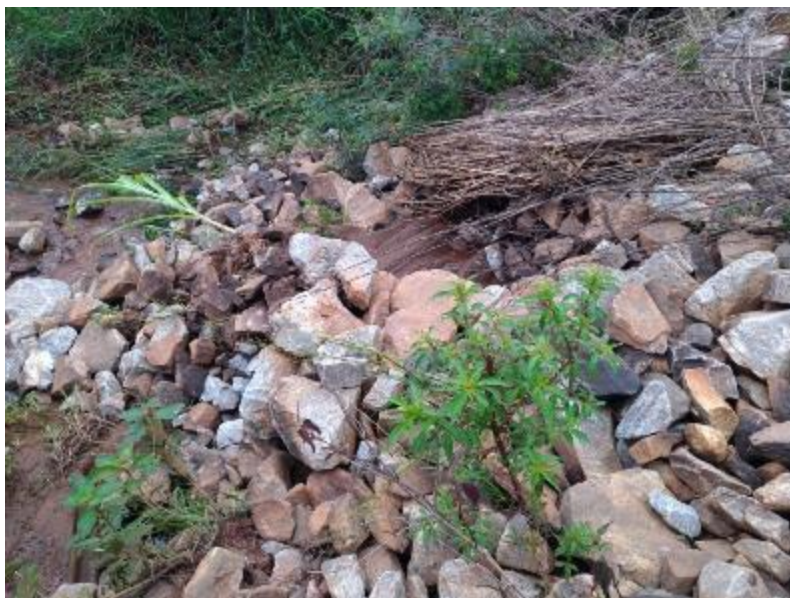
Figura 46 – Enrocamento deslocado no tributário TG05
