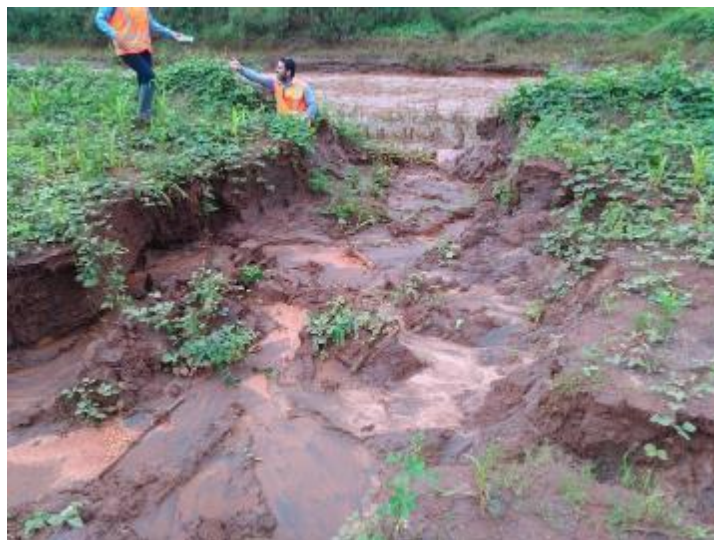
Figura 67 –Erosão de grande porte no sistema de drenagem superficial
