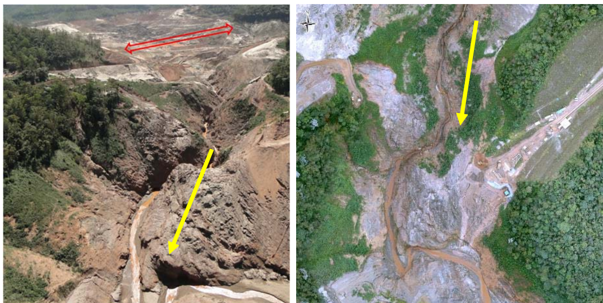
Figura 21 – Ponto do Trecho 1 que apresenta o Córrego Santarém
