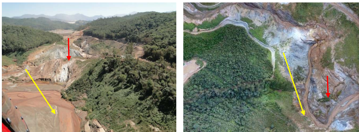
Figura 23 – Remoção de parte do solo das encostas
