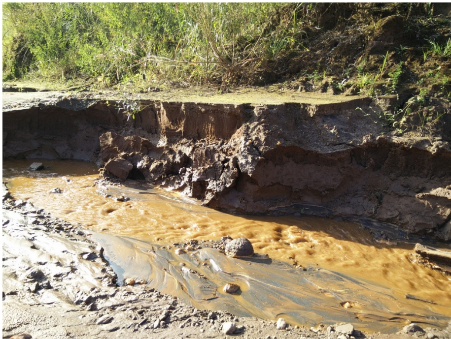
Foto 15: Detalhe do rejeito inconsolidado encontrado na margem da calha do PV-04, local onde na data da visita era objeto de obras de controle de erosão
