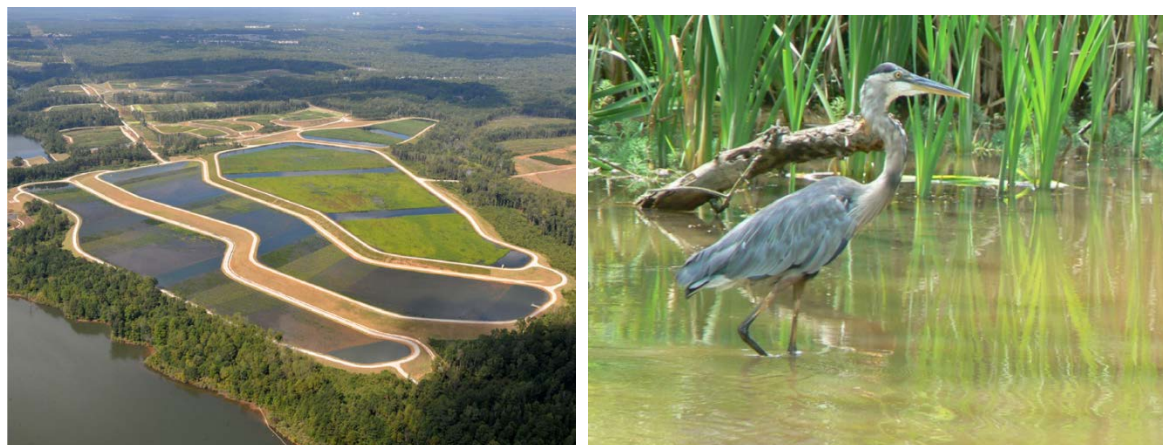
Figura ApA 6: Wetlands Construídos Huie apresentam tratamento primário e secundário
