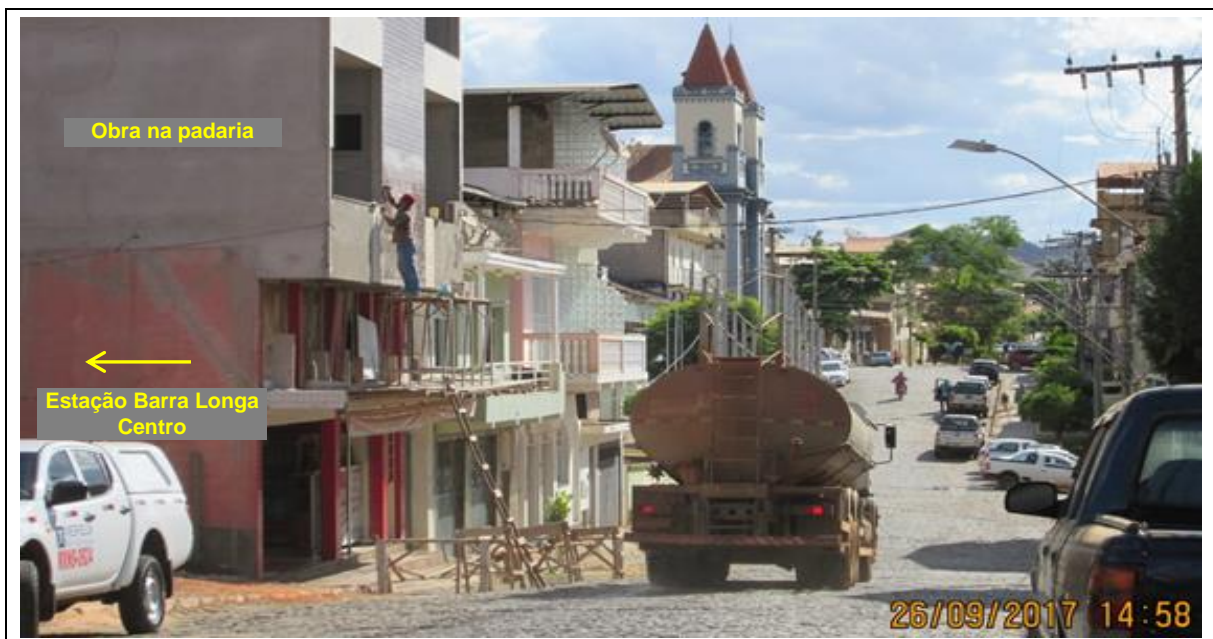
Figura 5.2 - Registros da Obra na Padaria ao Lado da Estação Barra Longa Centro – 26/09/2017
