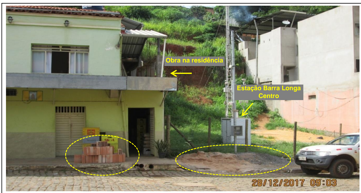
Figura 5.6 - Registro da Obra na Residência ao Lado da Estação Barra Longa Centro – 28/12/2017
