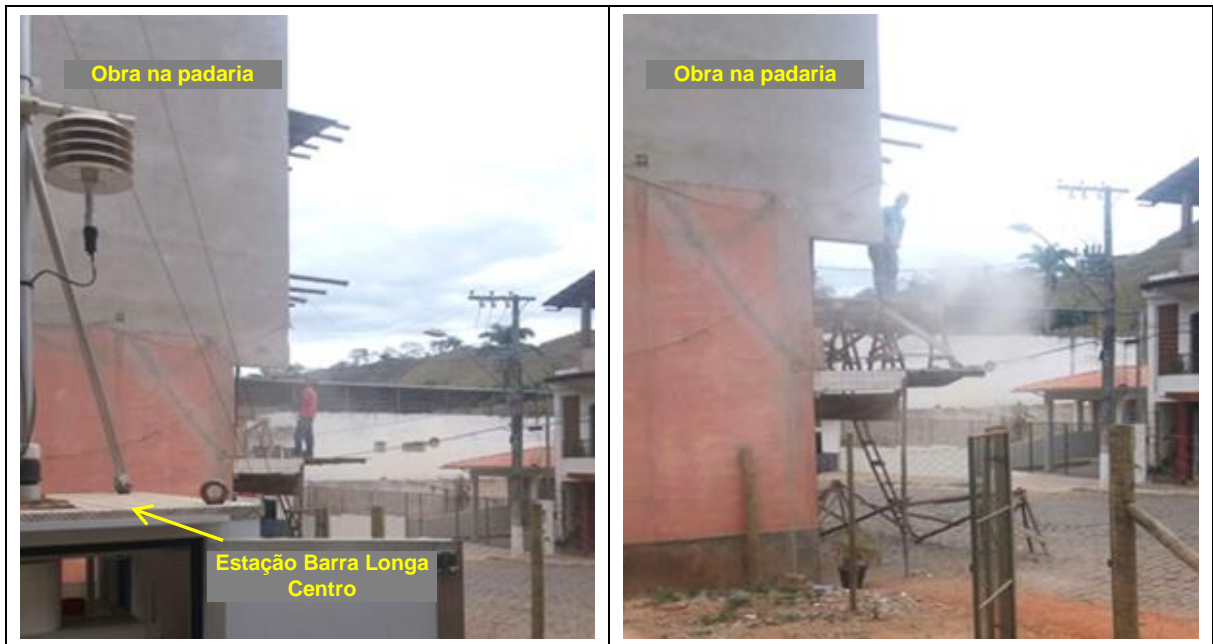
Figura 5.1 - Registros da Obra na Padaria ao Lado da Estação Barra Longa Centro – 23/08/2017
