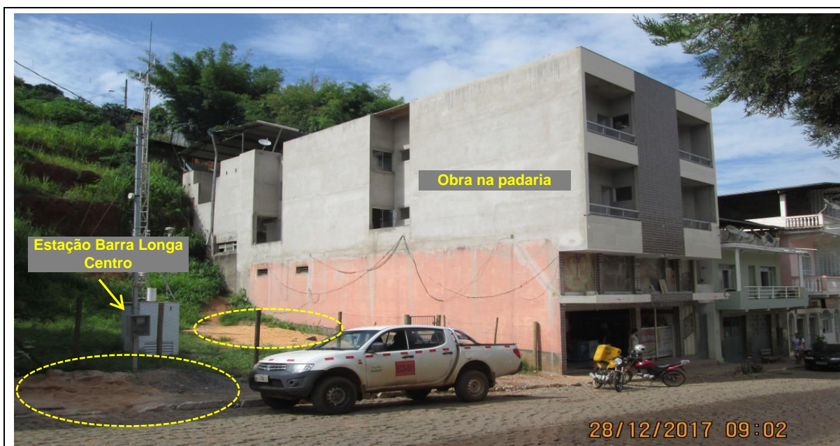
Figura 5.4 - Registros da Obra na Padaria ao Lado da Estação Barra Longa Centro – 28/12/2017
