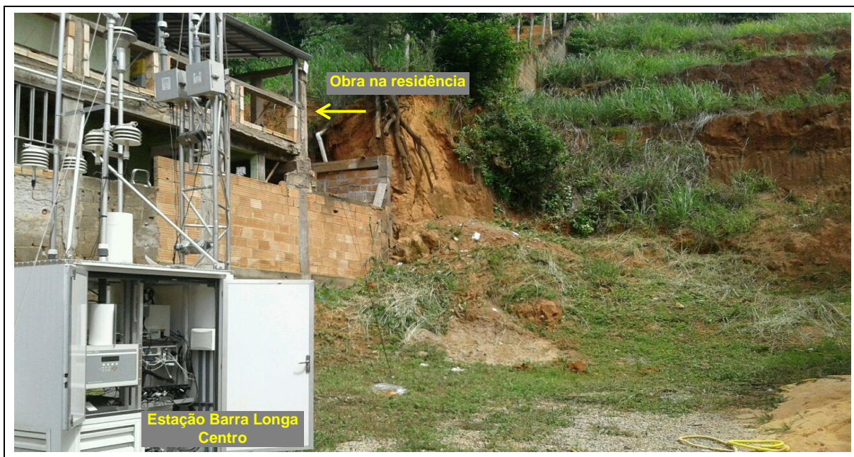
Figura 5.5 - Registro da Obra na Residência ao Lado da Estação Barra Longa Centro – 27/11/2017
