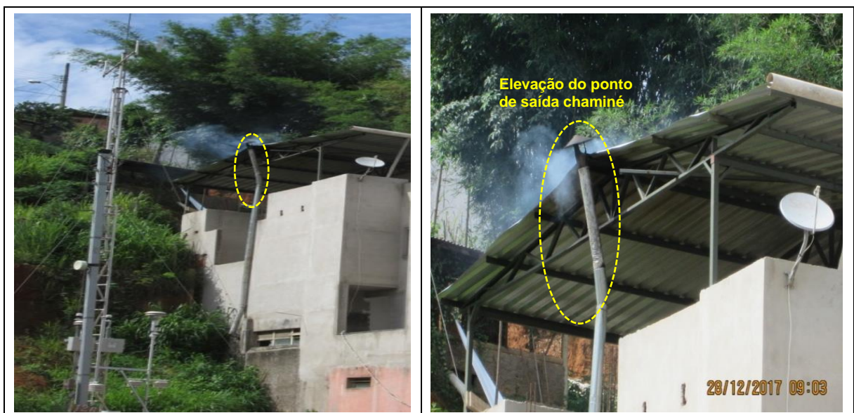
Figura 5.12 - Registro da Chaminé da Padaria Após Nova Alteração da Altura
