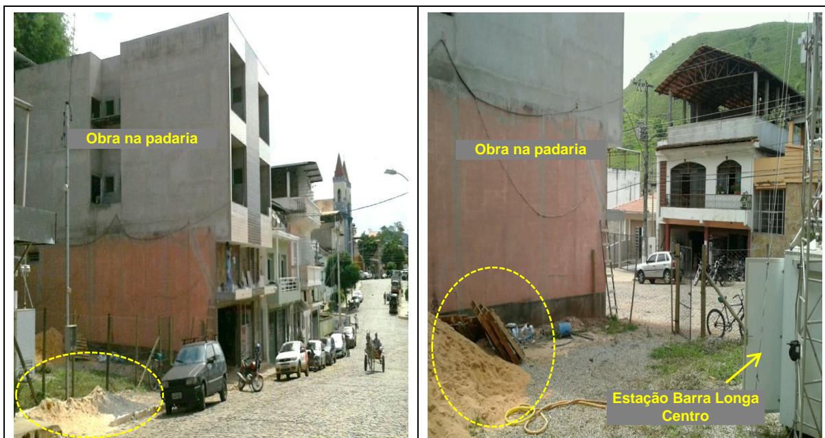
Figura 5.3 - Registros da Obra na Padaria ao Lado da Estação Barra Longa Centro – 27/11/2017
