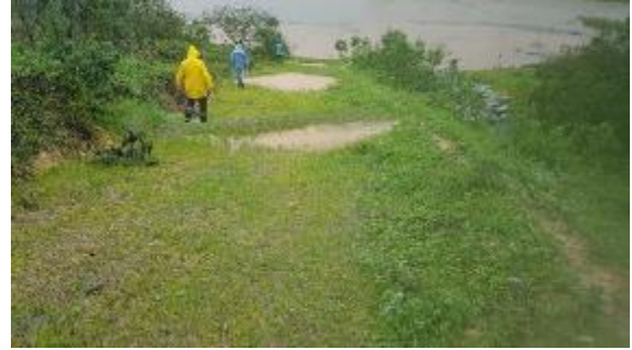
Acesso revegetado até o ponto de desague com leiras/bacias de contenção.
