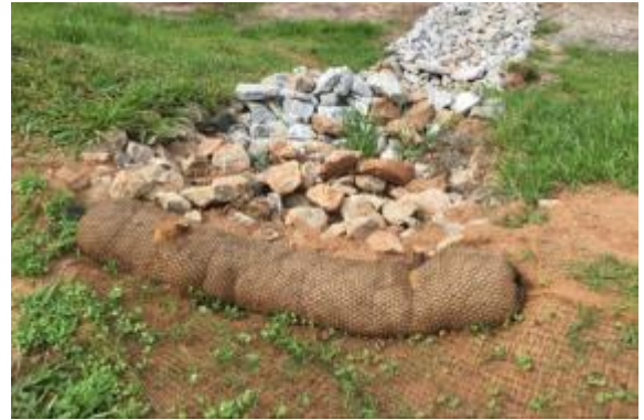
Manutenção de canaletas de drenagem com enrocamento e instalação de biorretentores
