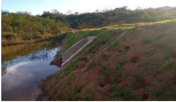
Visão de montante do bueiro concluído.
