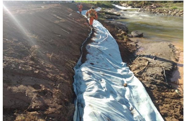
Aplicação de geotêxtil
