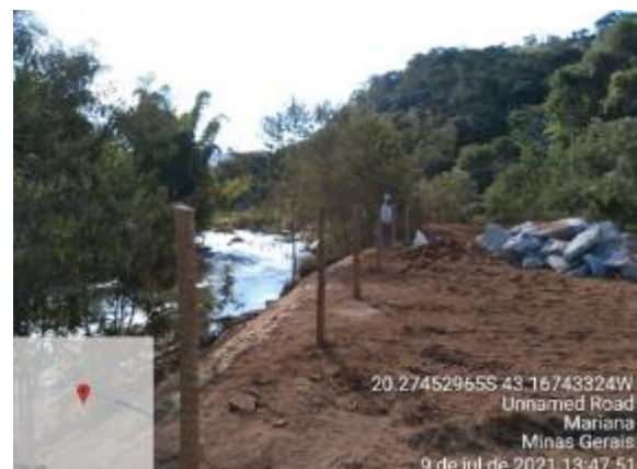
Proteção de talude com instalação de biomanta
