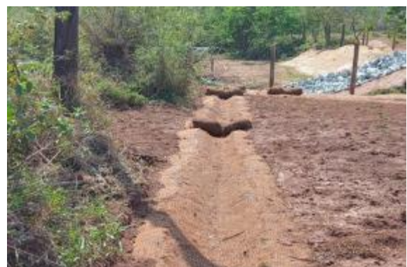
Proteção de canaleta e revestimento com biomanta
