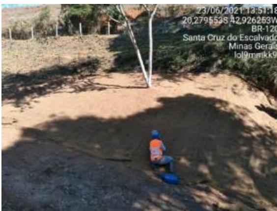
Instalação de biomantas
