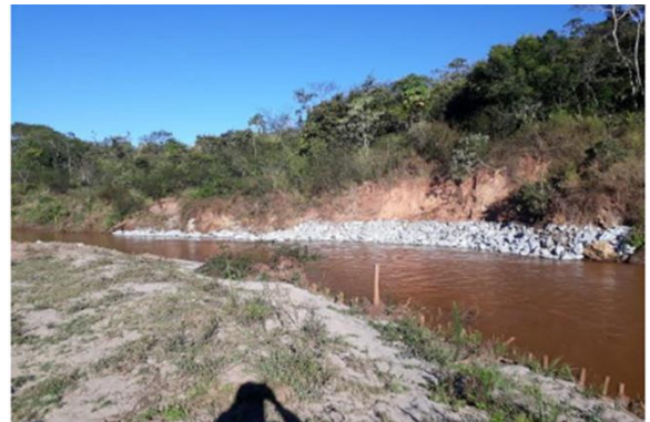
Revestimento com enrocamento
