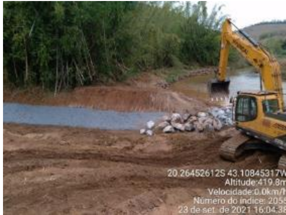
Proteção de talude com enrocamento
