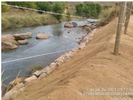
Proteção de talude com enrocamento e biomanta
