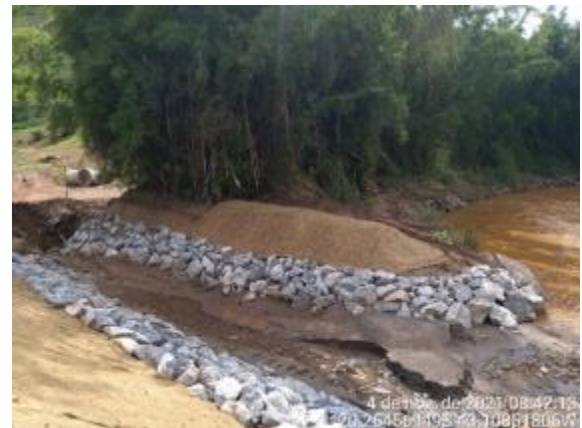
Proteção de talude com enrocamento
