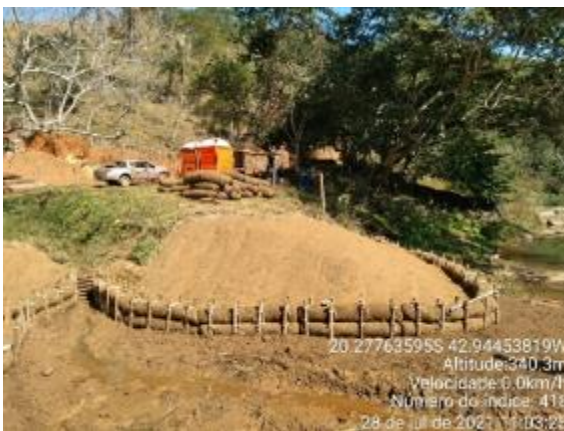
Instalação de biorretentores na margem
