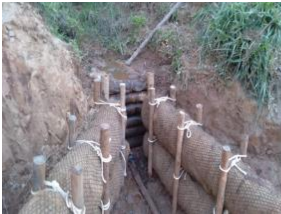
Instalação de biorretentores e paliçadas
