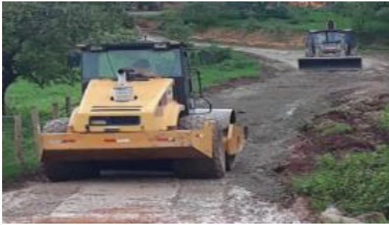
Recuperação de processo erosivo em acesso
