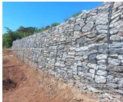
Implantação de muro de gabião
