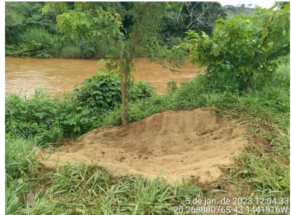
Manutenção de descida d'água em canaleta verde.
