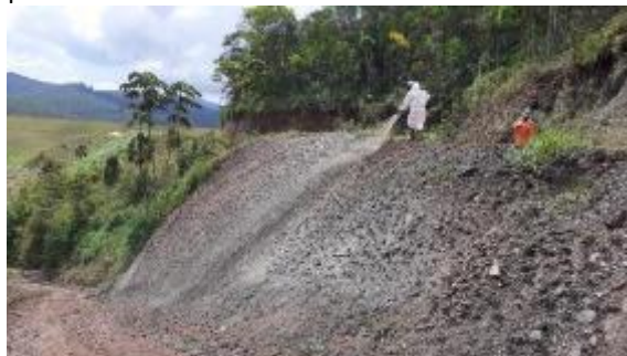
Aplicação de hidrossemeadura nos taludes.
