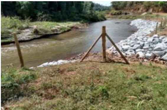
Reconformação de talude de margem com base em enrocamento
