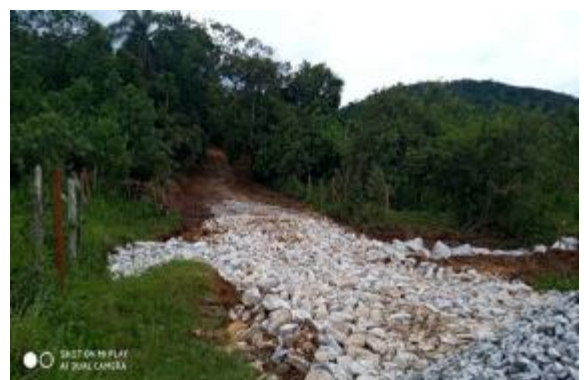
Recuperação de processo erosivo em acesso
