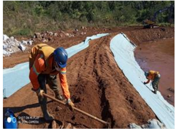
Fornecimento e aplicação de geotêxtil
