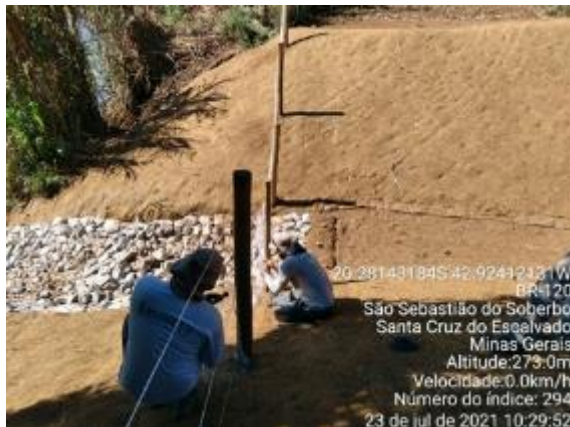
Revestimento de canaleta de drenagem com pedra de mão
