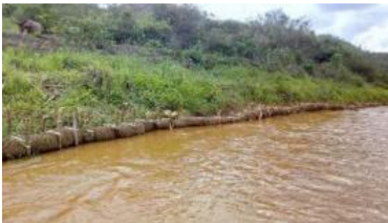
Instalação de biorretentores nas margens
