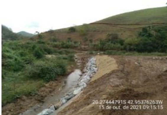
Proteção de talude com enrocamento e biomanta
