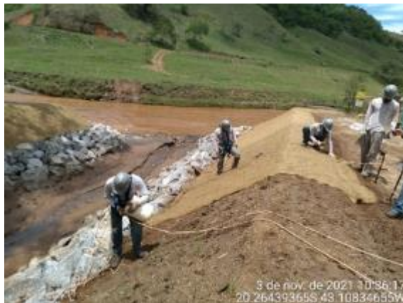
Instalação de biomantas em taludes
