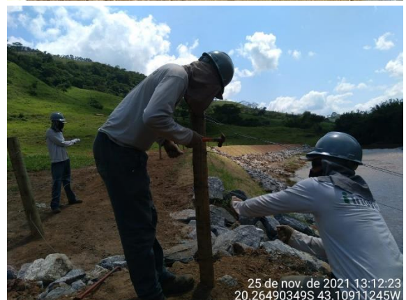
Retaludamento, enrocamento, instalação de cerca, adubação, semente e cobertura com biomanta.
