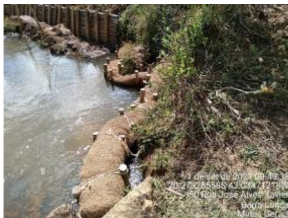
Instalação de biorretentores nas margens
