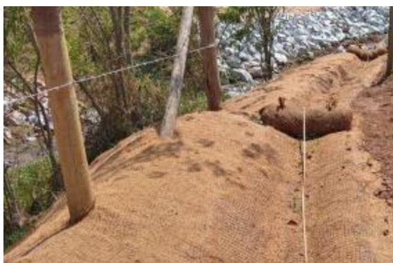
Proteção de canaleta e revestimento com biomanta
