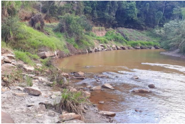
Revestimento com enrocamento
