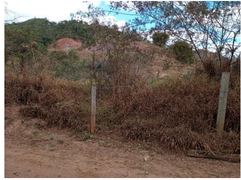
Drenagem do acesso
