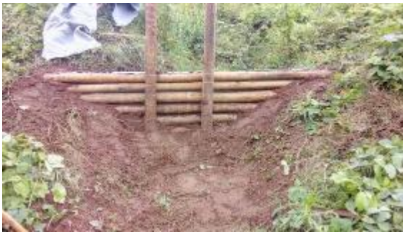
Instalação de paliçadas de madeira
