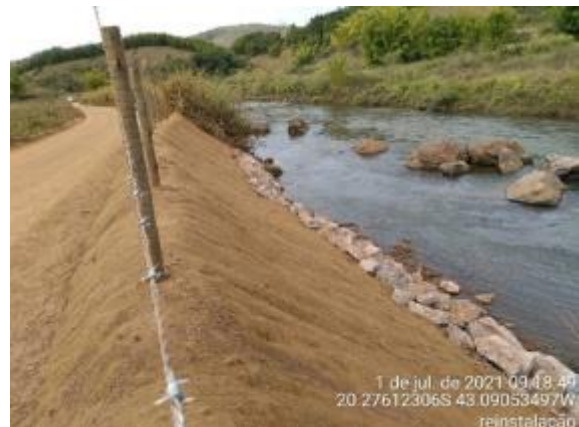
Proteção de talude com enrocamento e biomanta
