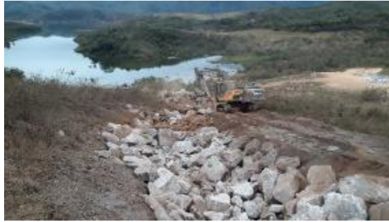
Revestimento com enrocamento
