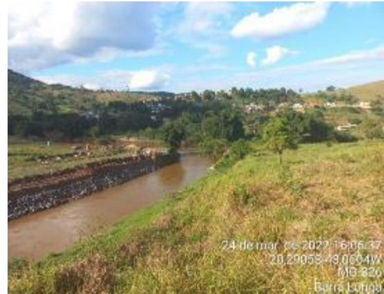
Proteção de talude com enrocamento e biomanta
