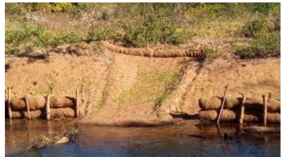
Proteção de talude com biomanta e implantação de biorretentores
