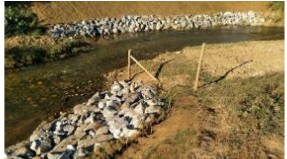
Proteção de talude com enrocamento
