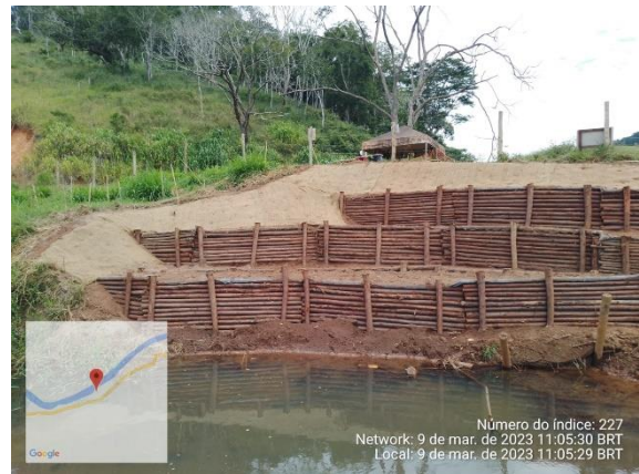
Instalação de paliçadas
