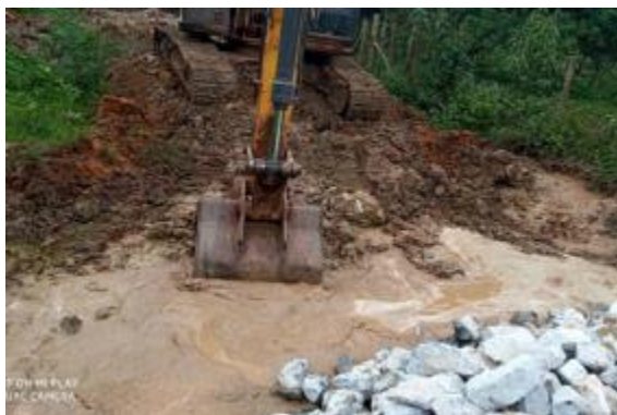
Recuperação de processo erosivo em acesso
