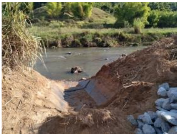
Manutenção de descida d'água
