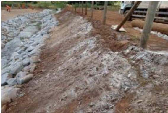
Reconformação de taludes de tributário com proteção com enrocamento
