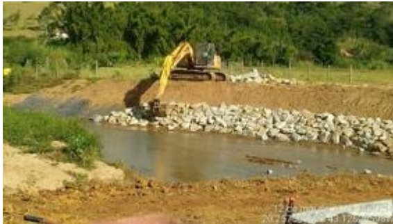
Proteção de talude com enrocamento
