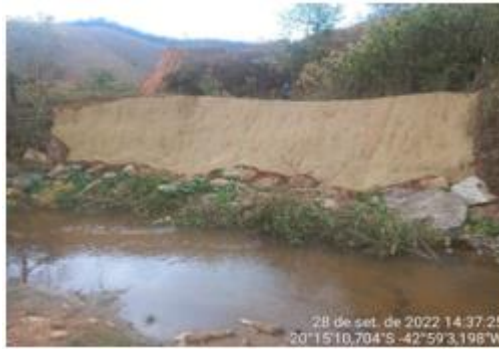
Instalação de biomantas
