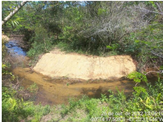
Retaludamento, adubação, semeio e cobertura com biomanta
