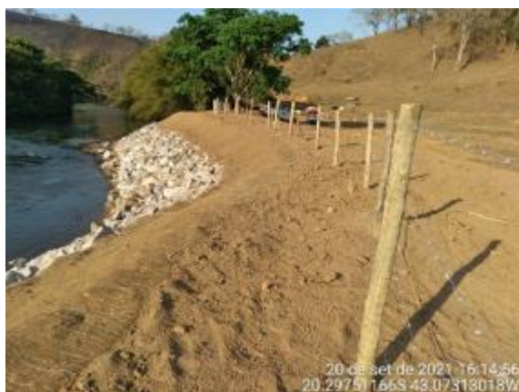
Reconformação de talude de margem com base em enrocamento
