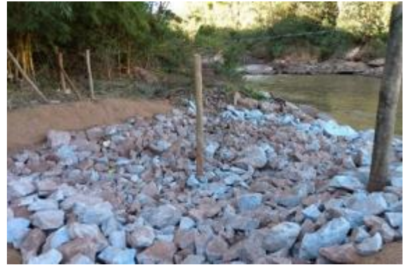
Drenagem revestida com pedra de mão
