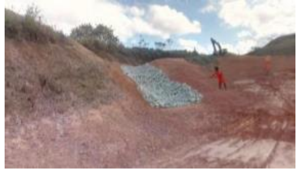
Reconformação e revestimento de canaleta com enrocamento.
