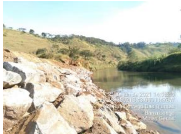
Proteção de talude com enrocamento
