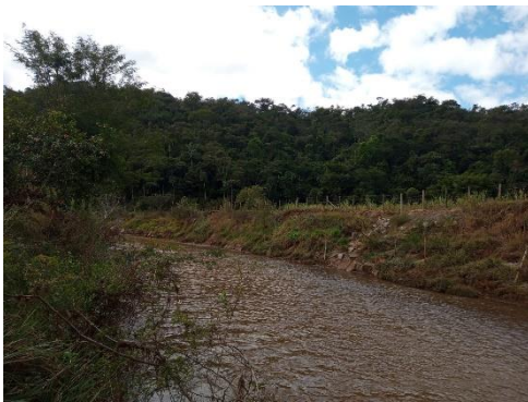
Revestimento com enrocamento
