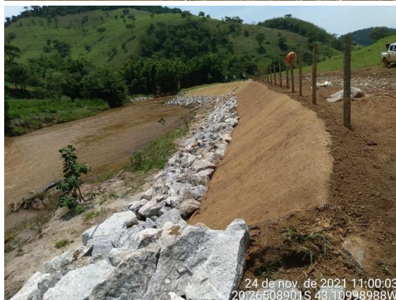
Retaludamento, enrocamento, instalação de cerca, adubação, semente e cobertura com biomanta.
