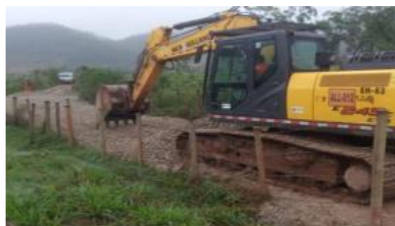
Recuperação de processo erosivo em acesso
