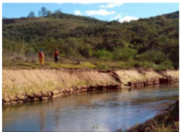
Proteção de talude com biomanta
