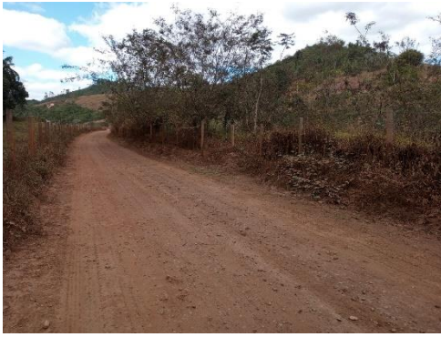
Drenagem do acesso
