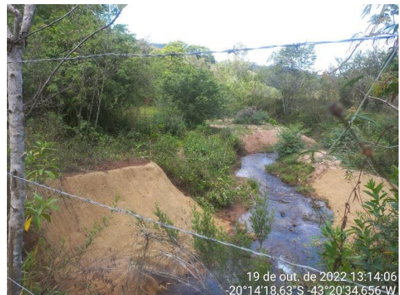
Retaludamento, adubação, semeio e cobertura com biomanta
