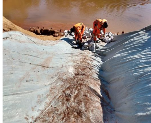
Instalação de descida d'água enrocada
