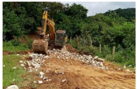
Recuperação de processo erosivo em acesso
