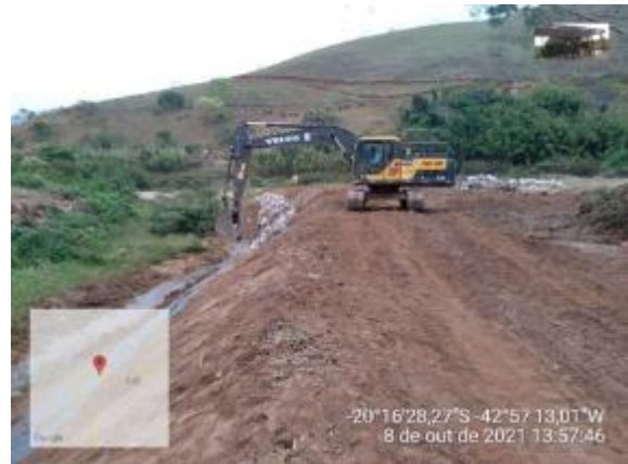
Proteção de talude com enrocamento
