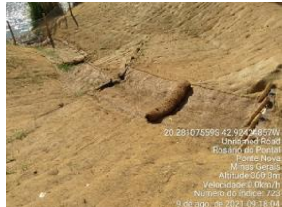
Revestimento de canaleta de drenagem em planície com biomantas
