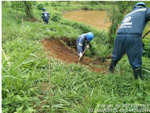
Manutenção de descida d'água em canaleta verde.
