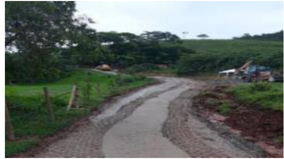
Recuperação de processo erosivo em acesso
