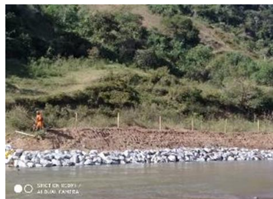
Revestimento com enrocamento
