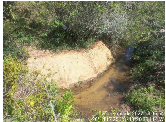
Retaludamento, adubação, semeio e cobertura com biomanta
