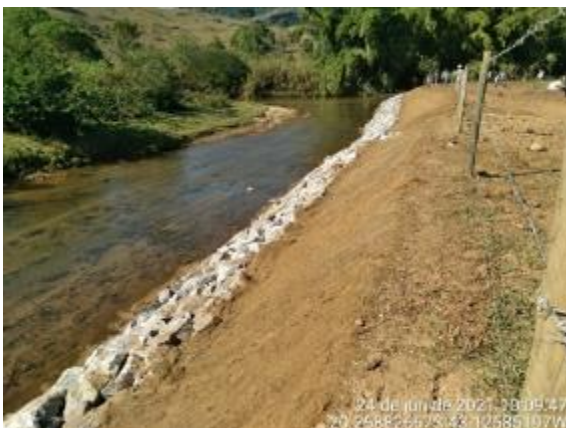
Proteção de talude com enrocamento e biomanta
