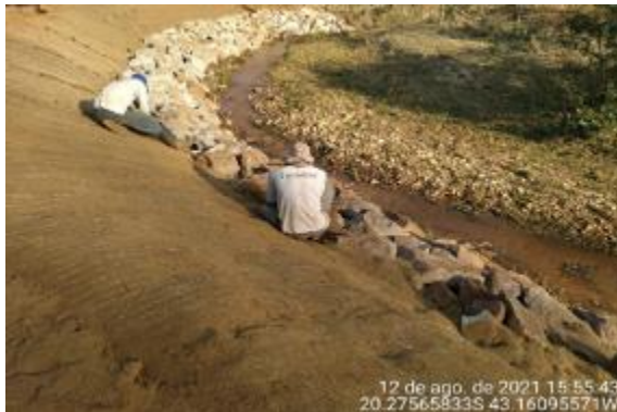
Aplicação de biomanta na face do talude
