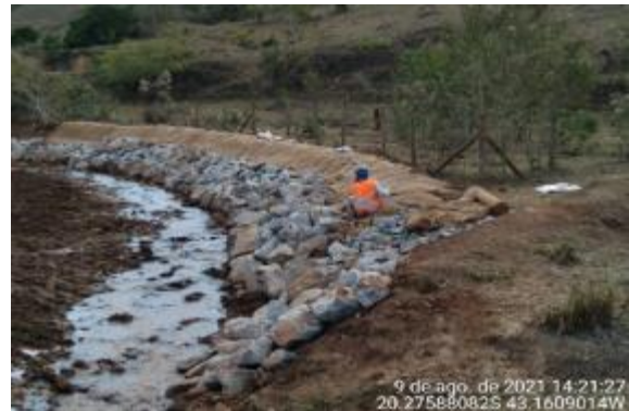
Aplicação de biomanta na face do talude
