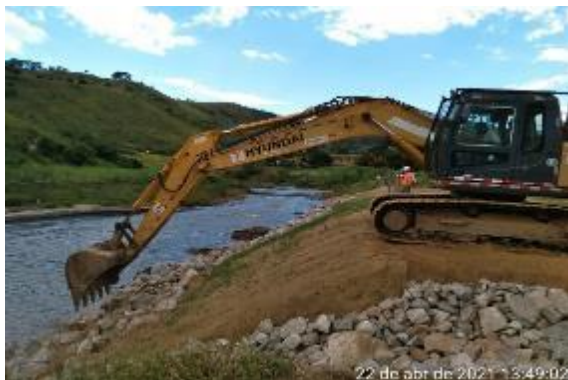
Proteção de talude com enrocamento
