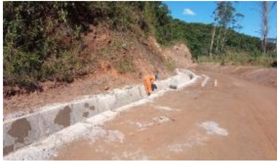
Construção de canaleta revestida em concreto
