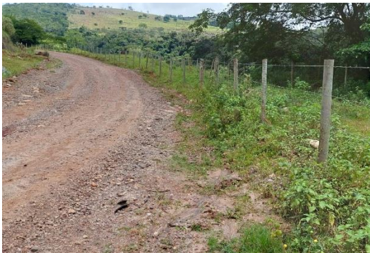
Reestabelecimento de drenagem da via
