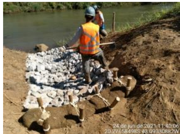
Descida d'água enrocada com pedra de mão e biorretentores
