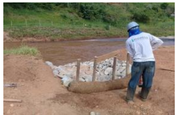
Reconformação de canaleta de drenagem com pedra de mão e biorretentores
