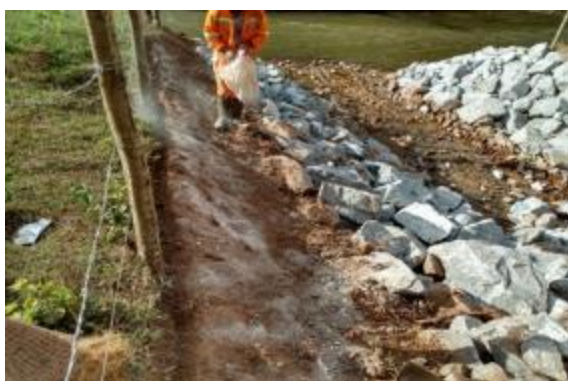
Revestimento de drenagem com pedra de mão
