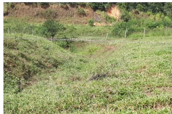
Execução de canal de drenagem e proteção da área com plantio de mix de sementes
