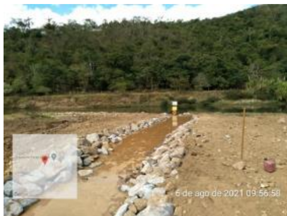
Proteção de talude com enrocamento
