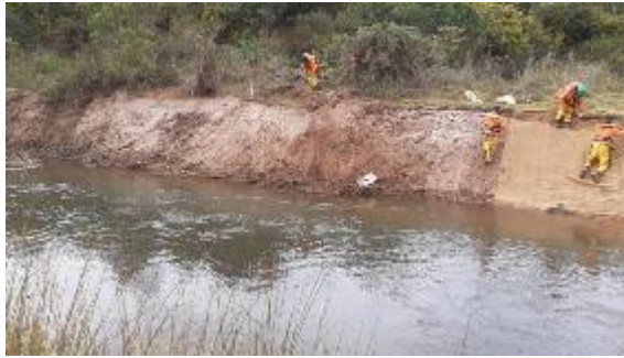
Reconformação de talude
