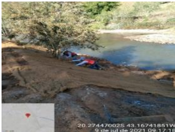
Proteção de talude com instalação de biomanta
