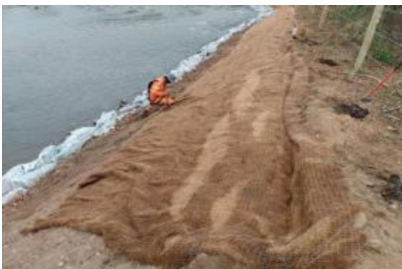
Apliação de biomanta na face do talude
