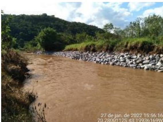
Proteção de talude com enrocamento
