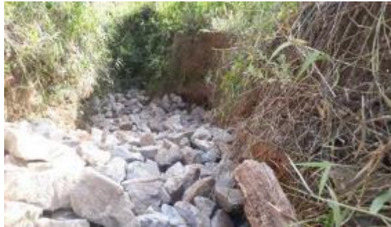
Revestimento do talvegue com camada dupla de pedras de mão.
