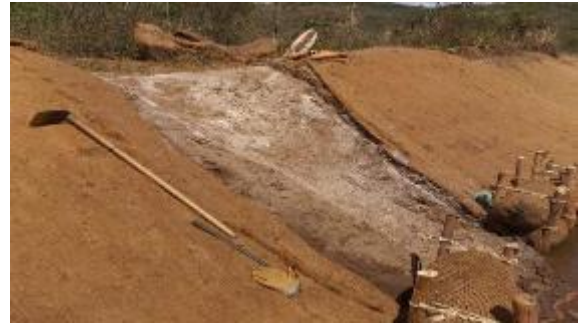
Proteção de talude com biomanta
