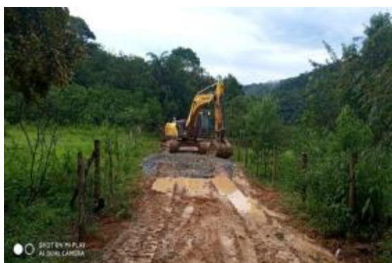
Recuperação de processo erosivo em acesso
