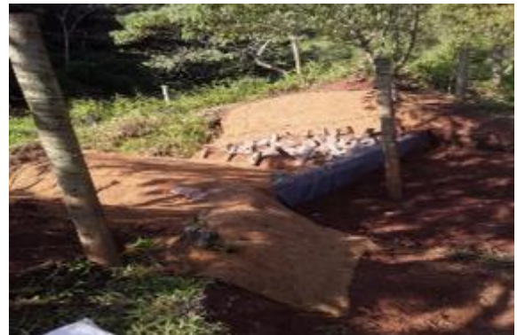
Revestimento de canaletas de drenagem com biomantas
