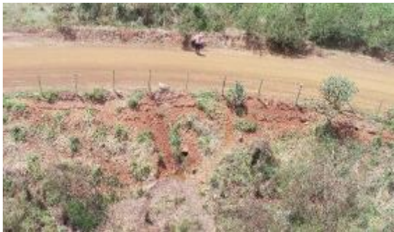
Visão do ITS-05 antes da construção do bueiro. Fonte: GOLDER
