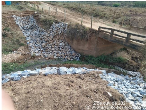
Manutenção de descidas d'água com pedra de mão.
