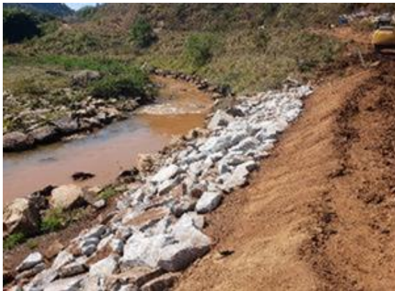
Aplicação de enrocamento
