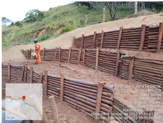
Instalação de paliçadas
