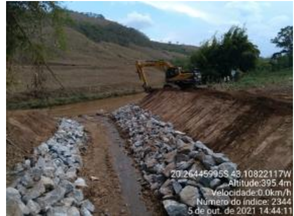
Proteção de talude com enrocamento
