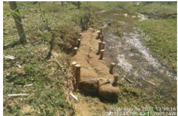
Instalação de biorretentores em margem
