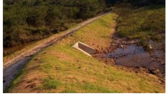
Visão de jusante do bueiro concluído e revegetação executada nos taludes e área marginal.
