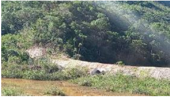
Visão de montante do bueiro concluído.
