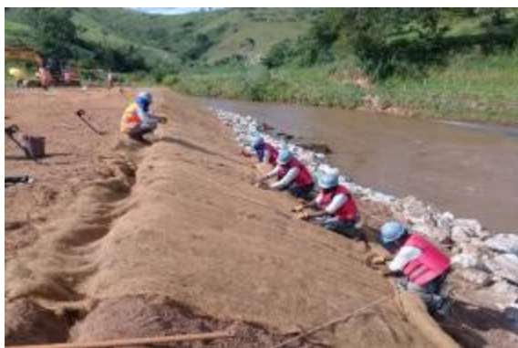
Aplicação de biomanta na face do talude
