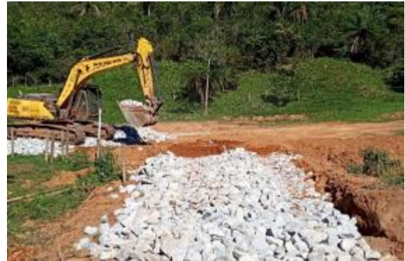
Recuperação de processo erosivo em acesso
