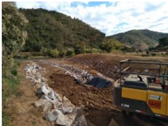
Proteção de talude com enrocamento
