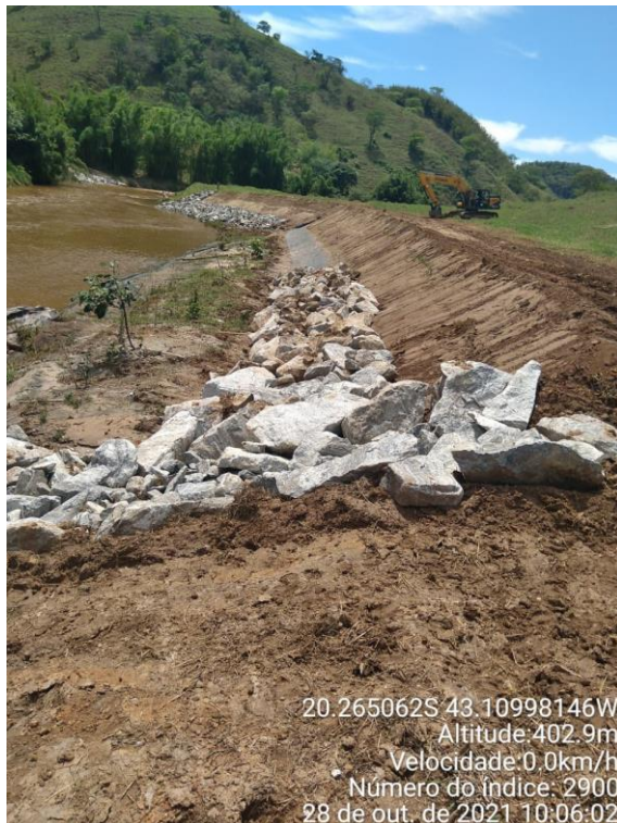
Retaludamento e enrocamento.
