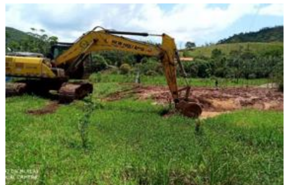
Manutenção de sistema de drenagem
