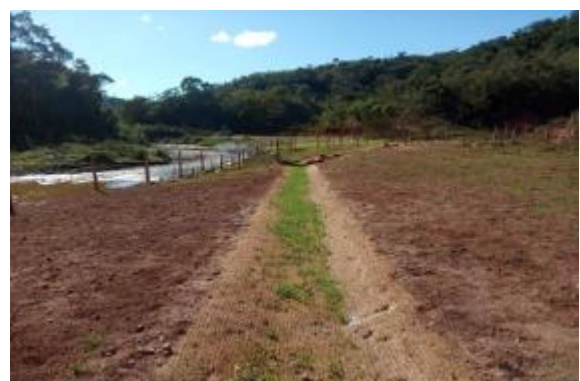
Proteção de canaleta e revestimento com biomanta
