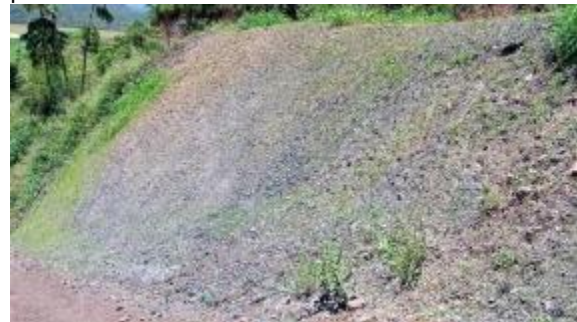
Desenvolvimento do mix de sementes nas áreas hidrossemeadas.
