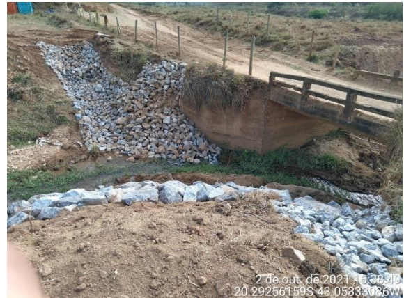
Manutenção de descidas d'água com pedra de mão.
