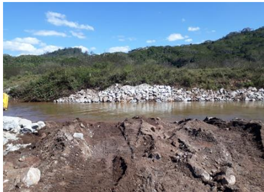
Revestimento com enrocamento
