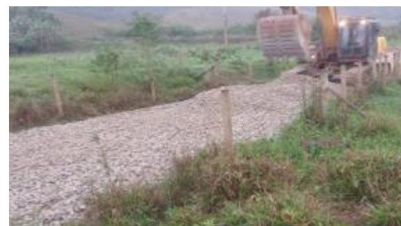
Recuperação de processo erosivo em acesso
