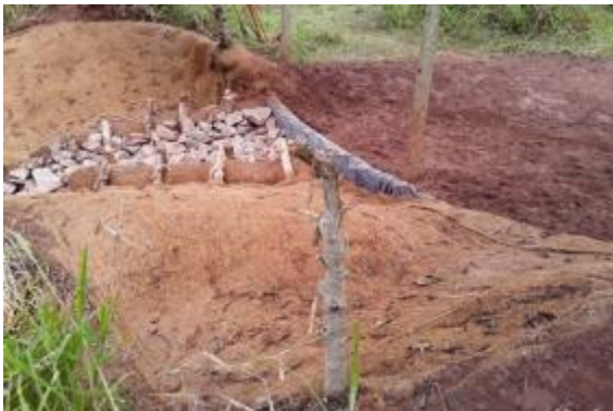
Revestimento de canaletas de drenagem com biomantas
