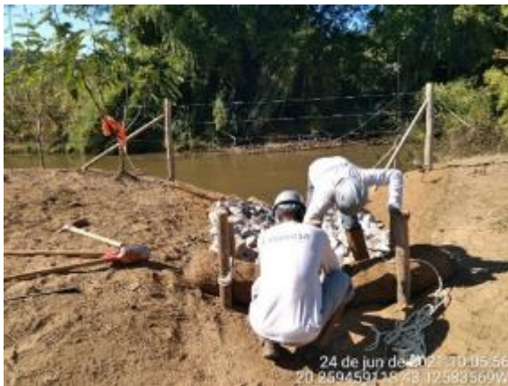
Manutenção de descida d'água
