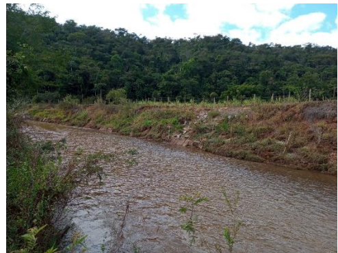
Revestimento com enrocamento
