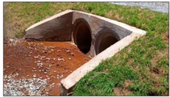
Bueiro com ala construída em concreto revegetação nas margens.
