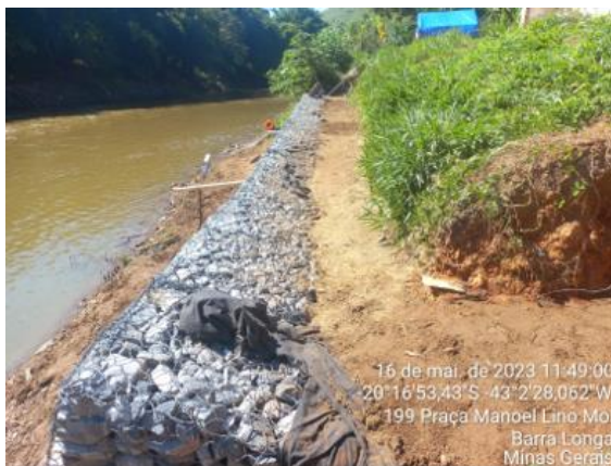
Implantação de muro de gabião
