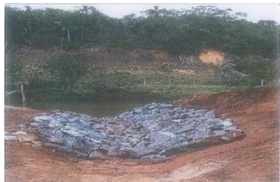
Instalação de descida d'água enrocada
