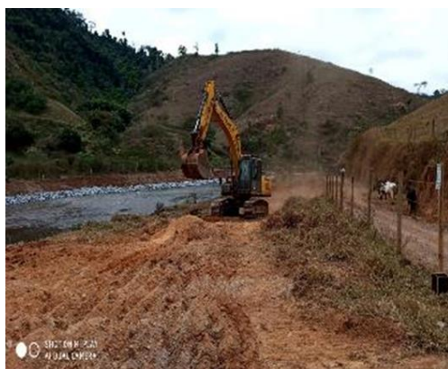
Regularização de terreno e drenagem
