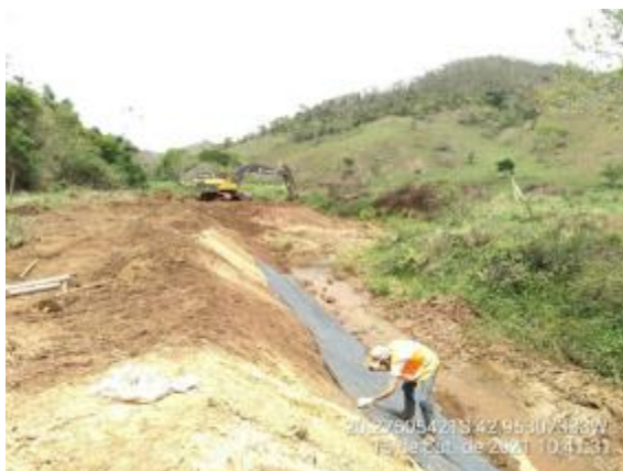
Reconformação de talude e instalação de filtro de transição
