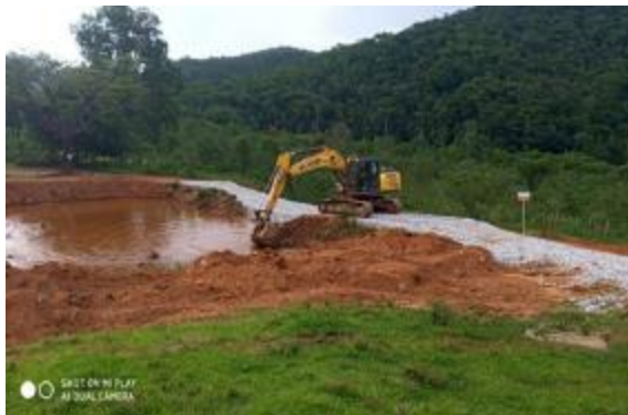
Recuperação de processo erosivo em acesso
