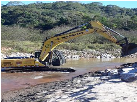
Revestimento com enrocamento
