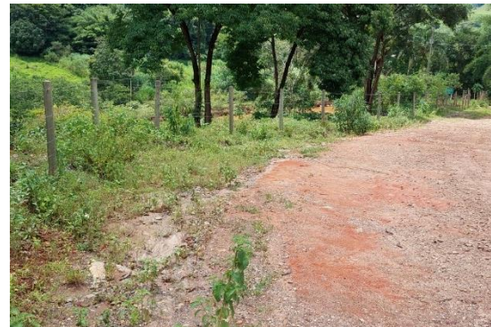
Reestabelecimento de drenagem da via
