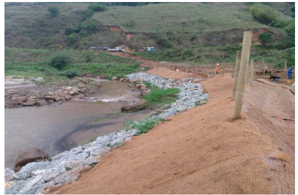
Plantio com mix de sementes e cobertura com biomanta bidimensional de coco
