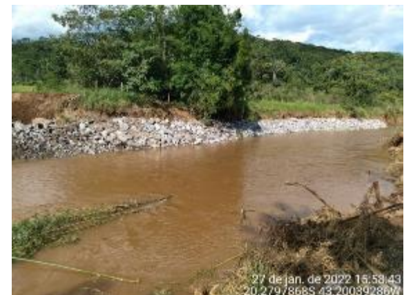
Proteção de talude com enrocamento
