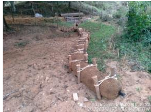
Instalação de biorretentores
