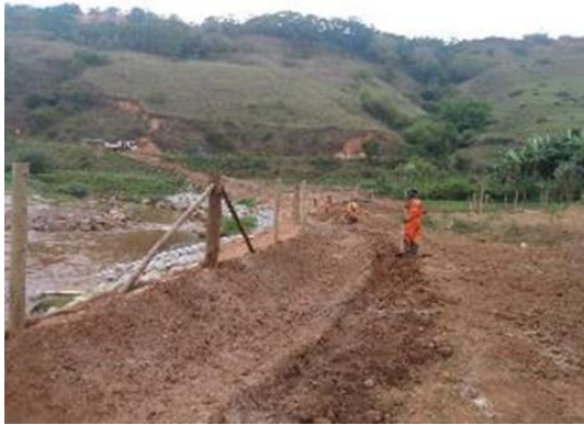
Instalação da drenagem de planície e cerca
