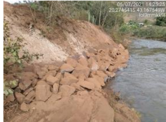
Proteção de talude com enrocamento
