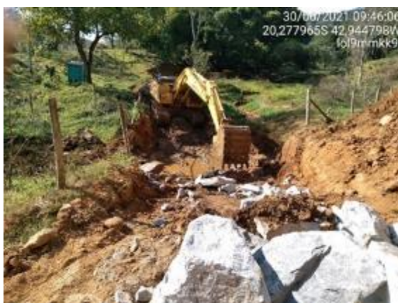
Instalação de passagem molhada
