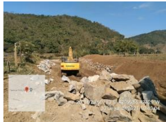
Proteção de talude com enrocamento
