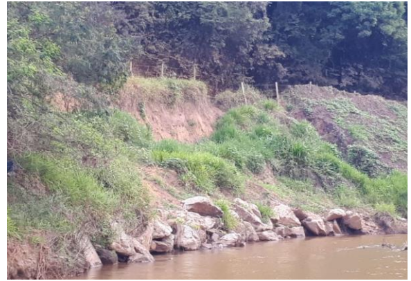
Revestimento com enrocamento
