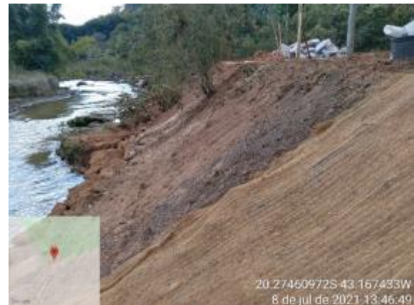
Proteção de talude com instalação de biomanta
