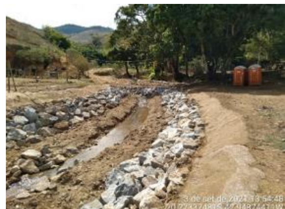
Proteção de talude com enrocamento
