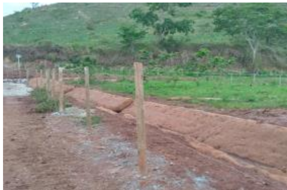
Proteção de canaleta e revestimento com biomanta
