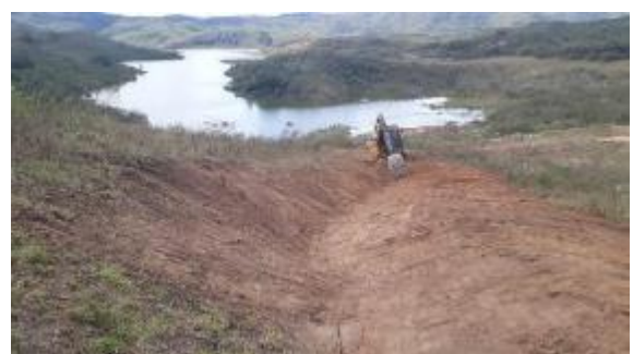
Reconformação da canaleta.
