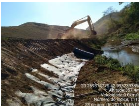
Reconformação de talude
