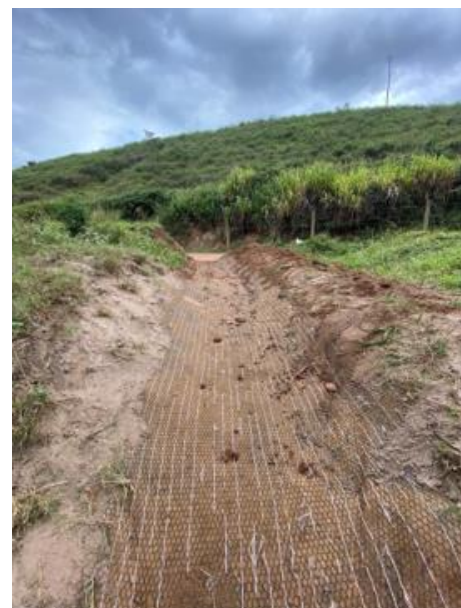
Implantação de descida d'água em canaleta verde
