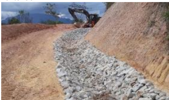
Visão parcial do local após a reconformação do acesso e instalação da canaleta.
