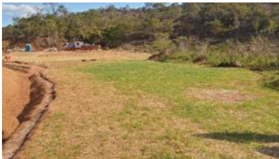
Manutenção das canaletas
