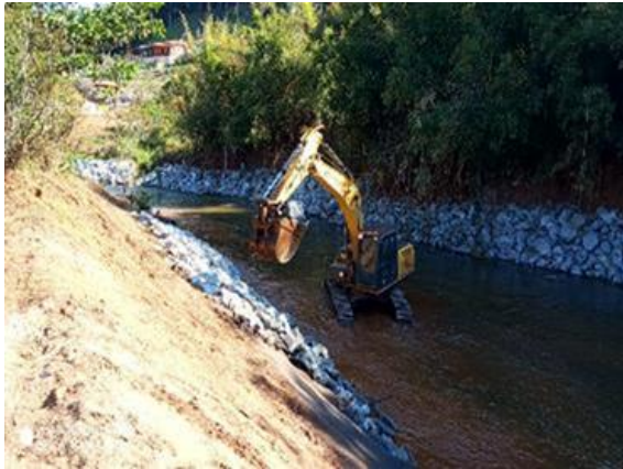
Execução de enrocamento
