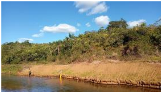
Proteção de talude com biomanta
