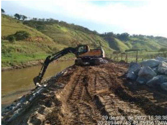
Proteção de talude com enrocamento e biomanta
