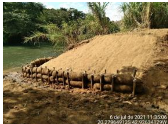
Instalação de biorretentores nas margens
