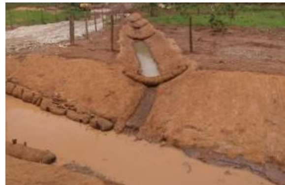
Proteção de canaleta e revestimento com biomanta
