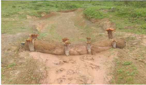
Reconformação de canaleta e revestimento com biomanta e biorretentores.
