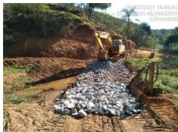
Instalação de passagem molhada
