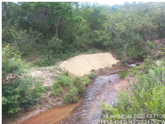
Retaludamento, adubação, semeio e cobertura com biomanta
