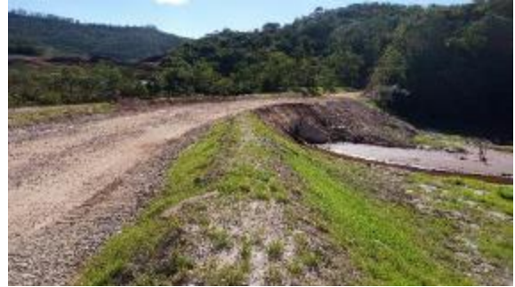
Visão de jusante do bueiro concluído e revegetação executada nos taludes e área marginal.
