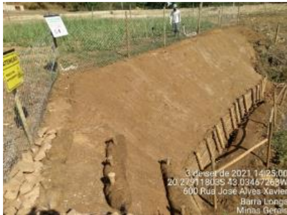
Proteção do talude com biomantas biorretentores e Instalação de paliçadas
