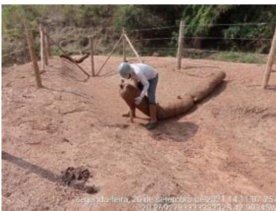
Instalação de biorretentores de sedimentos
