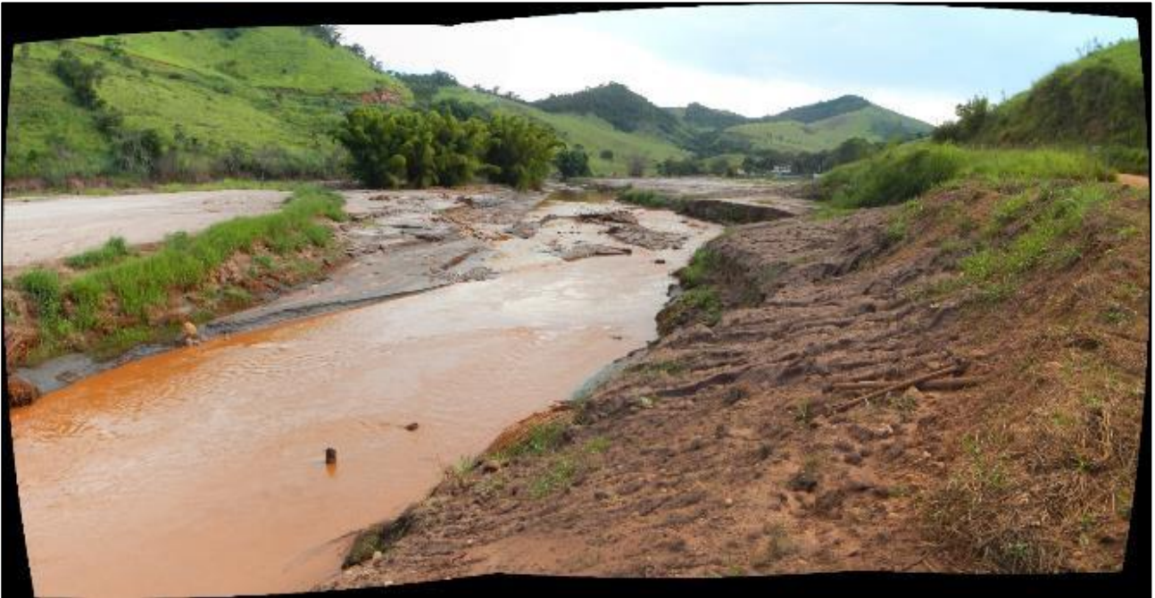
Figura 3.5.7: Condições pós-rompimento no ponto SG_15, vista para montante, a partir da margem esquerda.
