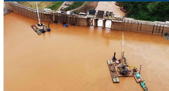
Remoção Sedimentos com Guindastes
