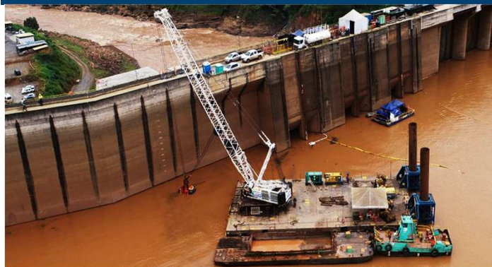
Remoção Sedimentos com Guindaste com Clamshell
