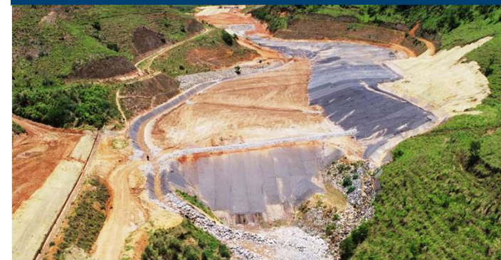
Contrapilhamento Ombreira Esquerda
