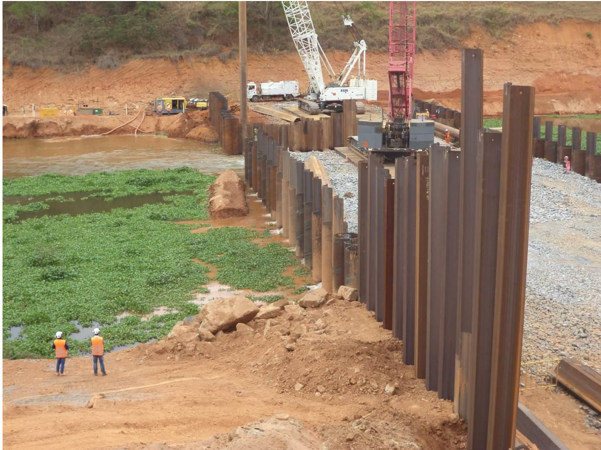
Foto 5 – Barramento C, em execução.
