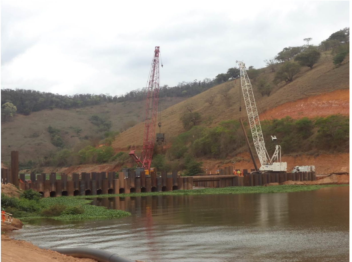
Foto 3 – Barramento C, em execução.
