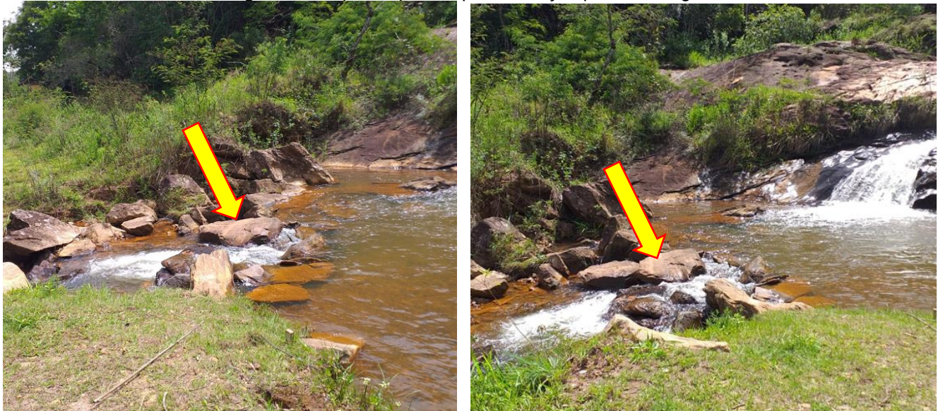
Figura 5 – Dique de pedras para retenção parcial da água
