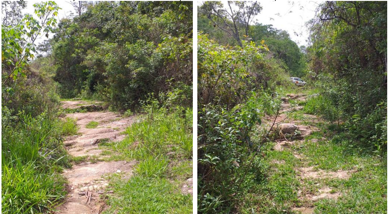
Figura 8 – Condição atual da via de acesso de pedestre entre as áreas superior e inferior da cachoeira
