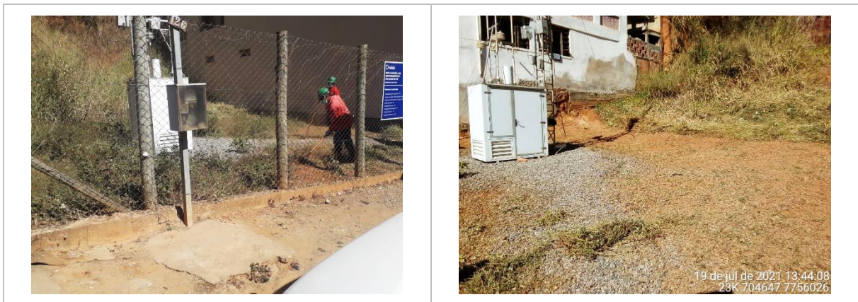
Figura A.1 - Limpeza e capina da vegetação no portal de Barra Longa próximo à estação Volta da Capela
