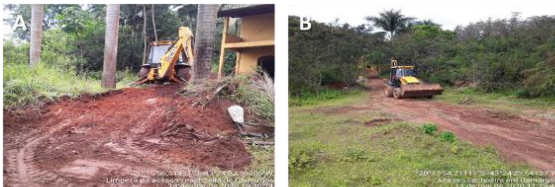
Figura 4.6: Fotografias da execução do serviço de limpeza dos acessos (Fonte: Fundação Renova, 2020a)
