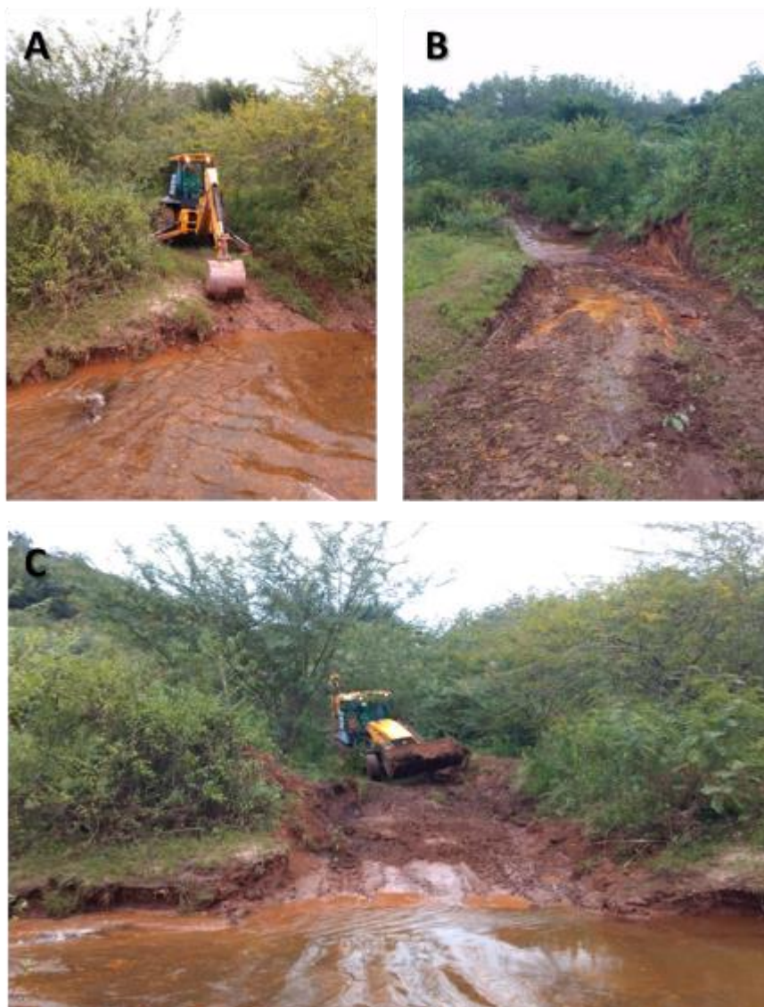
Figura 4.9: Passagem molhada durante conformação (Fonte: JM REFLORESTAMENTOS, 2020)
