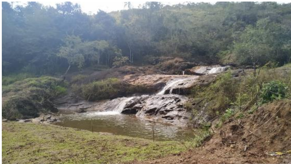
Figura 4.23: Cachoeira Camargos após a conclusão das obras de revitalização (Fonte: fornecido pela Fundação Renova)
