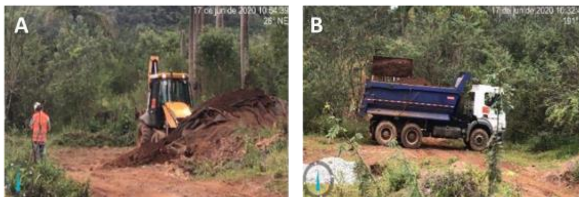
Figura 4.22: Carregamento da caçamba de caminhão “toco” com o rejeito retirado da Cachoeira Camargos (Fonte: JM REFLORESTAMENTOS, 2020)
