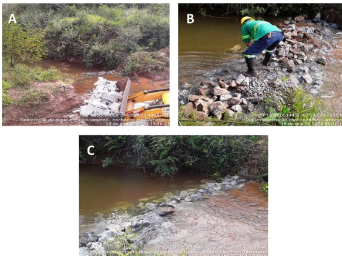
Figura 4.13: Construção do dique para retenção do material fino (Fonte: JM REFLORESTAMENTO, 2020)
