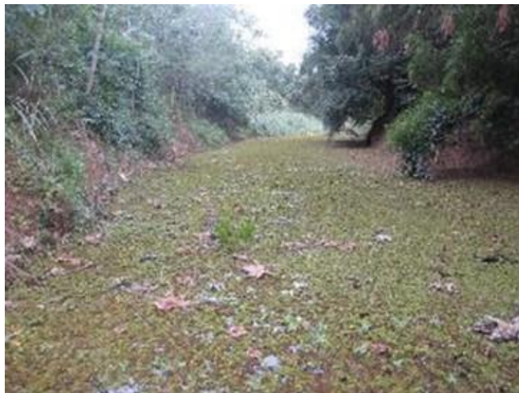
Figura 4-6: Canal a jusante da Barragem 1
