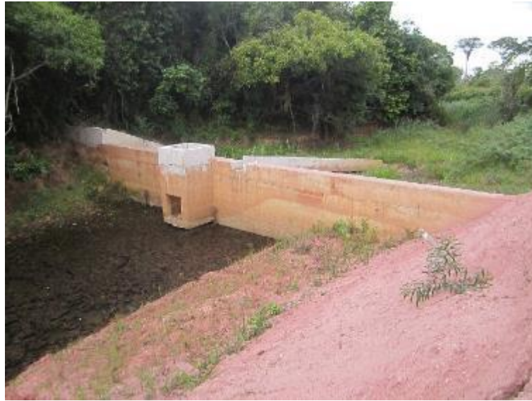
Figura 4-5: Aspecto da Barragem 2
