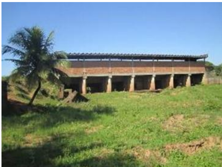
Figura 4-23: Sistema de comportas no Canal DNOS
