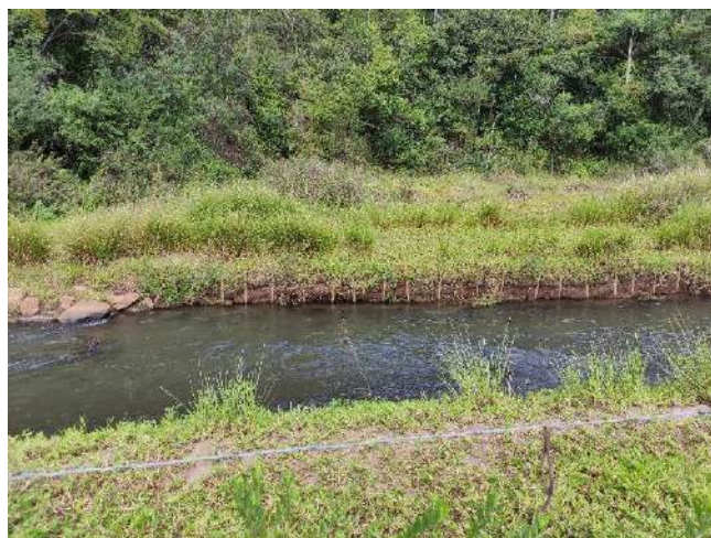
Foto 15:. Obras de Bioengenharia com uso de bermalongas e Vetiver
