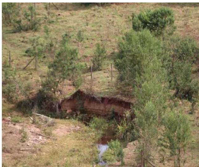
Foto 30: Processos erosivos nas margens do tributário.
