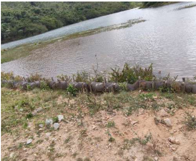
Foto 19-b: Biorretentores ITS07
