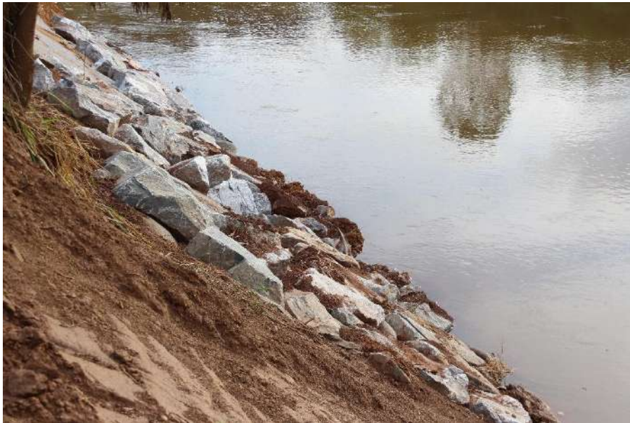
Foto 33: Enrocamento utilizando rochas grandes
