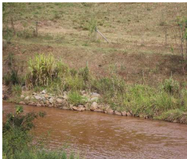
Foto 31: Obra de engenharia de enrocamento estabilizada, no rio Gualaxo, abaixo da saída do tributário.
