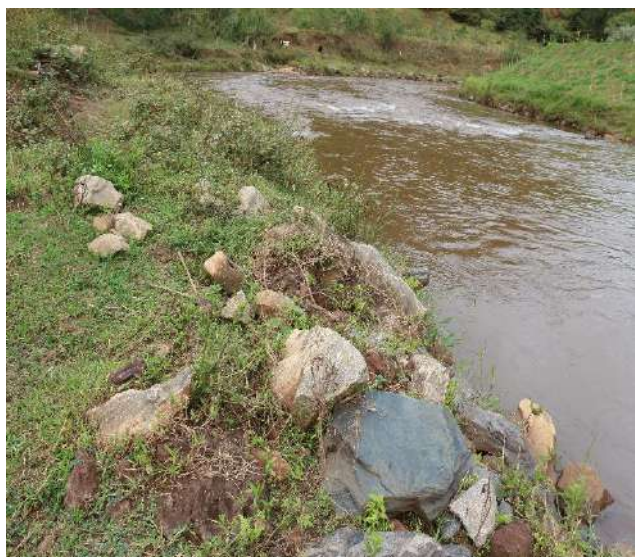
Foto 37: Enrocamento enriquecido com mix de sementes.
