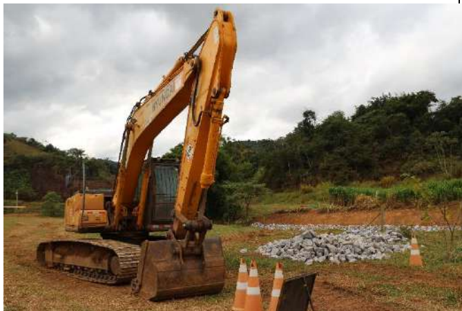
Foto 26: Obra em processo de execução
