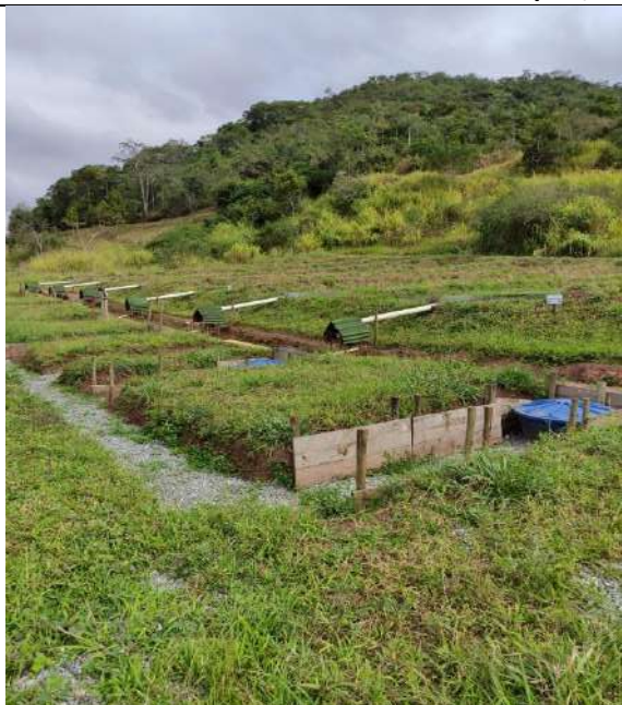
Foto 57: Sistema experimental de contenção de erosão laminar
