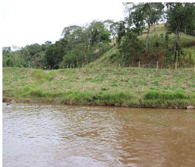
Foto 38: Enrocamento estabilizado as margens do rio Gualaxo.
