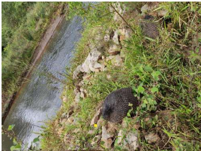
Foto 7: Enrocamento com boa incorporação vegetal
