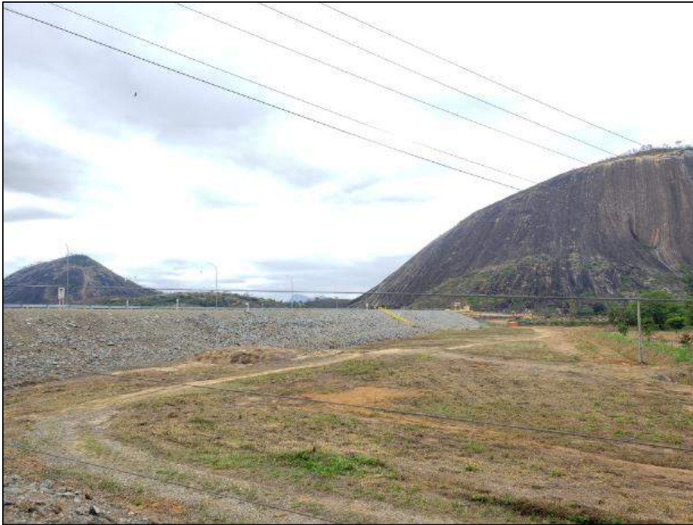
Figura 4-21 – Paramento de jusante da Barragem de Aimorés.
