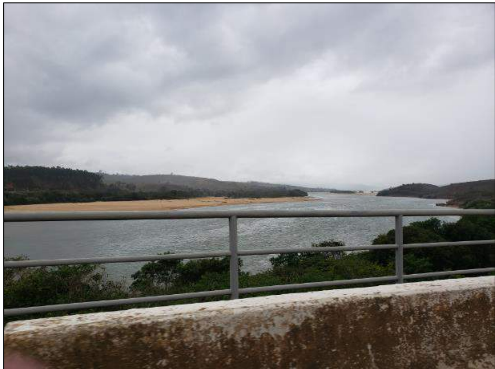
Figura 4-30 – Vista de montante e jusante do ponto 13.
