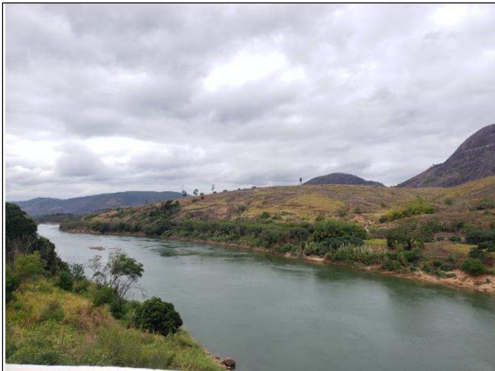
Figura 4-27 – Vista de jusante do ponto 12.
