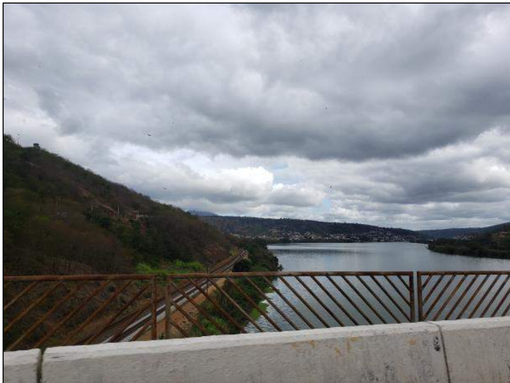
Figura 4-19 – Vista de montante e jusante do ponto 8.
