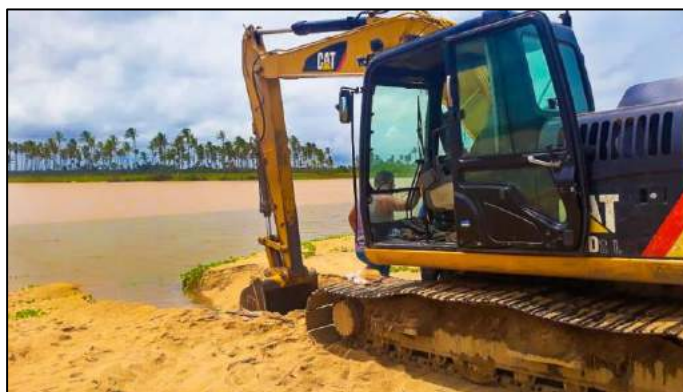
Figura 6-79 – Abertura da boca da barra em 28/01/2020. Fonte: Portal de Notícias da Prefeitura Municipal de Linhares.
