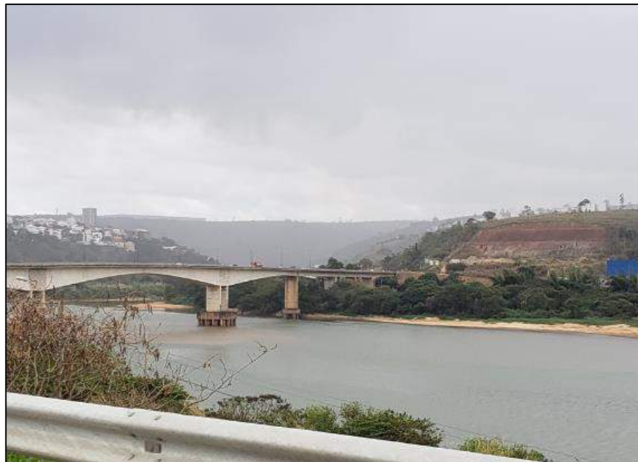
Figura 4-29 – Vista da ponte no ponto 13.
