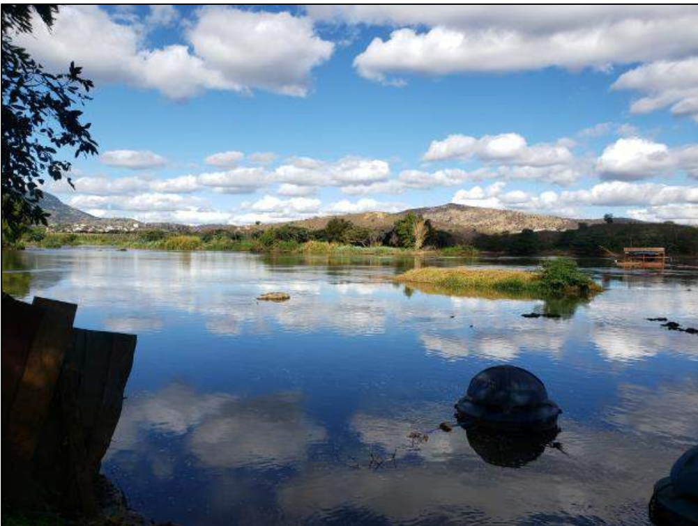
Figura 4-12 – Vista de montante e jusante do ponto 5.
