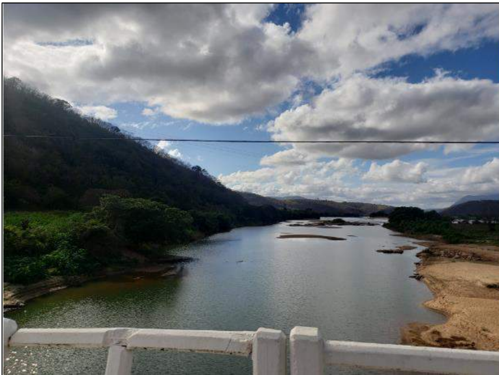
Figura 4-17 – Vista de montante e jusante do ponto 7.
