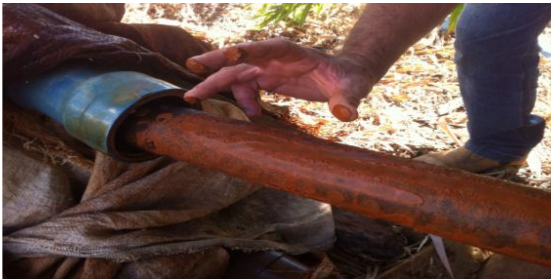
Imagem 101: Sistema de filtragem com interferência de argila e silte obstruindo a passagem de água pelo filtro.
