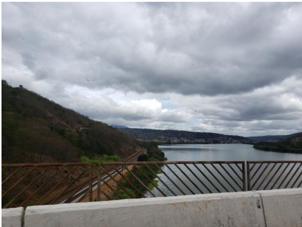
Figura 3.19 – Vista de montante e jusante do ponto 8.
