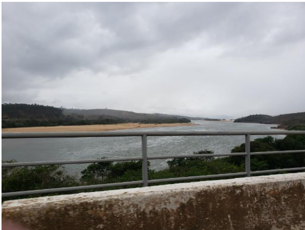
Figura 3.30 – Vista de montante e jusante do ponto 13.
