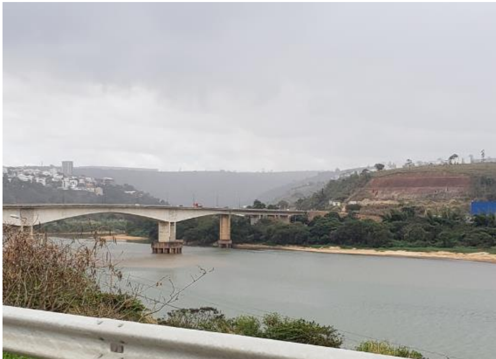
Figura 3.29 – Vista da ponte no ponto 13.
