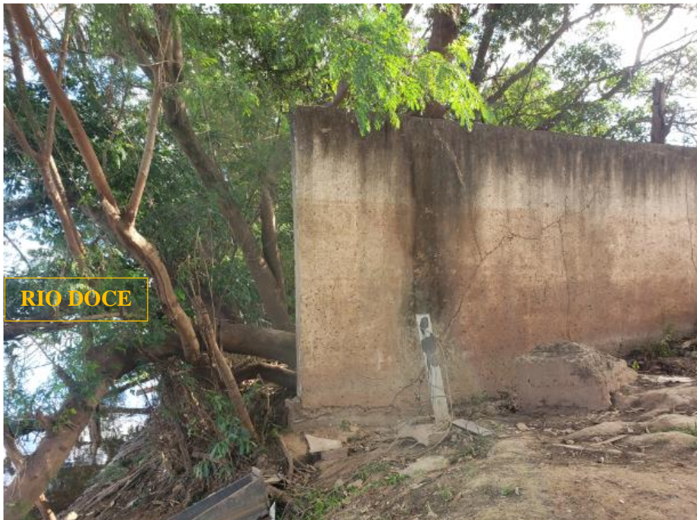
Figura 3.13 – Marca da cheia no muro.
