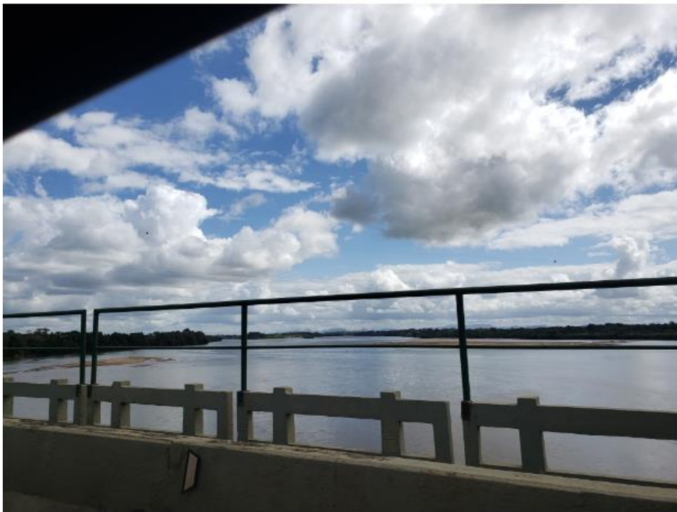
Figura 3.34 – Vista de montante e jusante do ponto 15.
