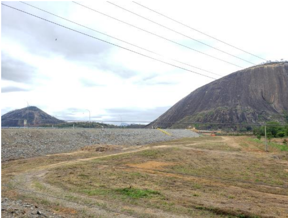
Figura 3.21 – Paramento de jusante da Barragem de Aimorés.
