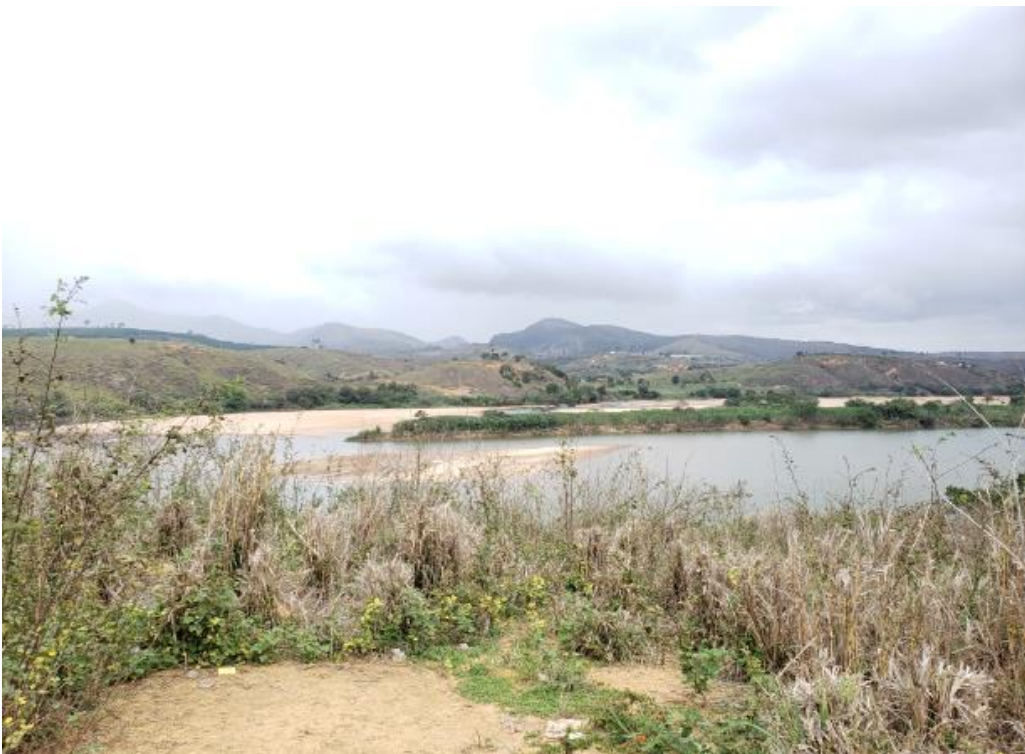
Figura 3.32 – Vista de montante e jusante do ponto 14.
