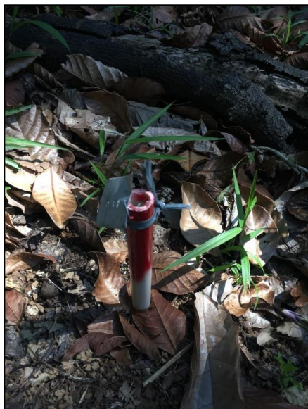
Foto 1 - Piquetes quebrados na 3T.
