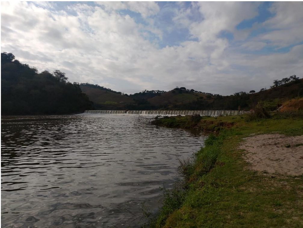
Figura 8 Ponto impactado (I-2) no reservatório da UHE Risoleta Neves, no Rio Doce.
