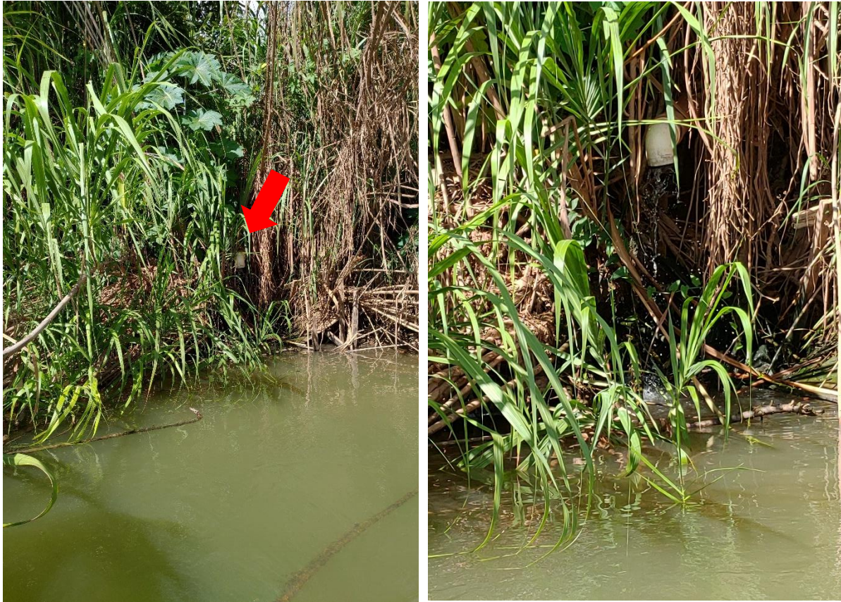
Figura 31 Registro fotográfico de canalização e lançamento de esgoto no Rio Doce na região de Colatina, ES.
