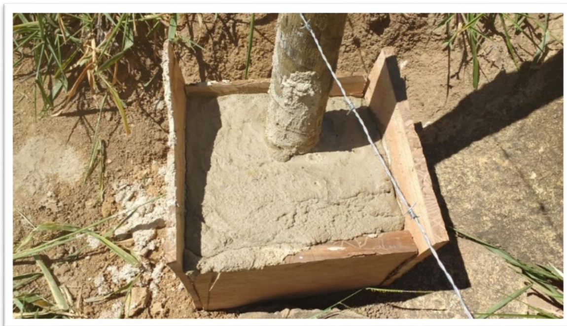
Figura 42 – Fixação de mourão de cerca sobre terreno rochoso
