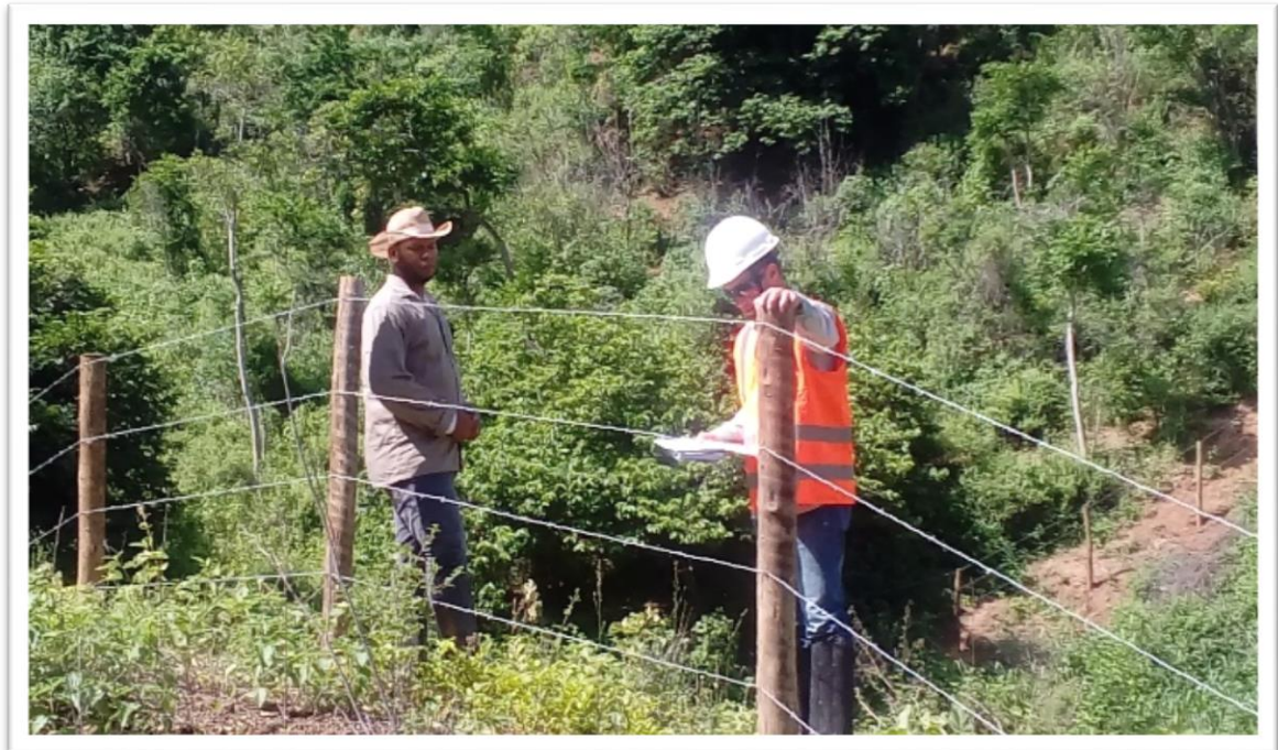
Figura 35 - Fiscalização da Fundação Renova inspecionando qualidade da cerca
