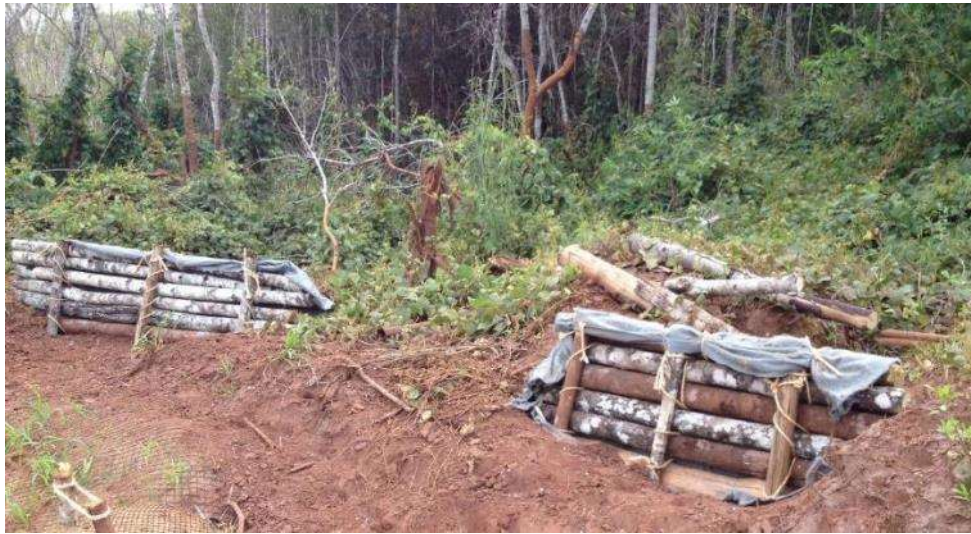
Figura 21 - Uso da madeira nas obras de Bioengenharia como paliçadas.
