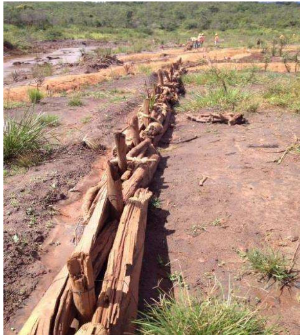
Figura 19 - Uso da madeira nas obras de Bioengenharia como feixe de galhadas.
