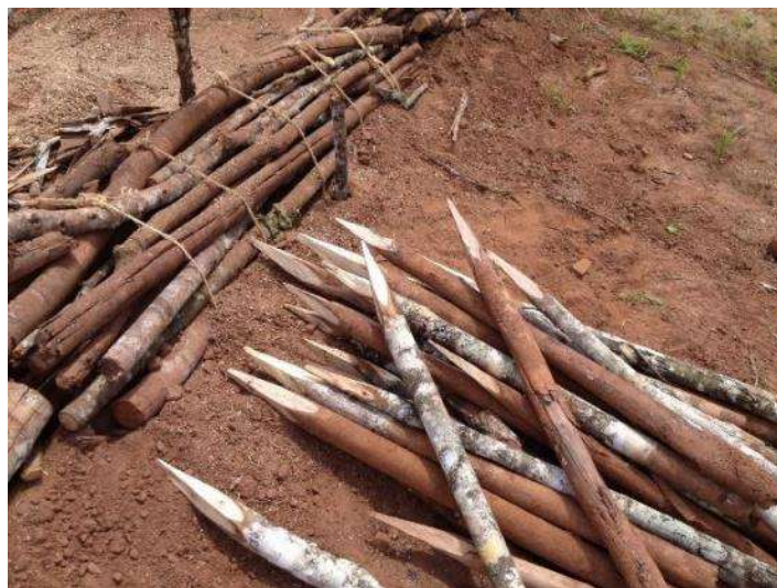
Figura 20 - Uso da madeira nas obras de Bioengenharia como estacas.
