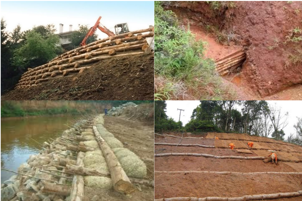
Figura 23 – Formas de utilização de paliçadas de madeira
