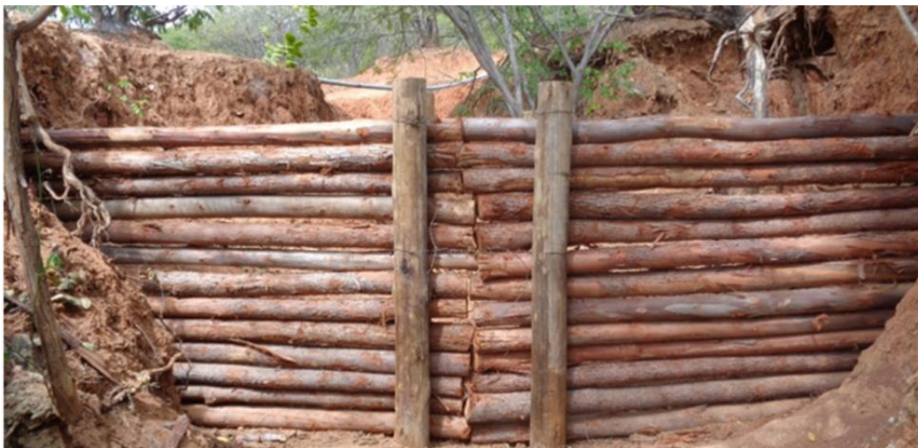
Figura 21 – Utilização de paliçada de madeira
