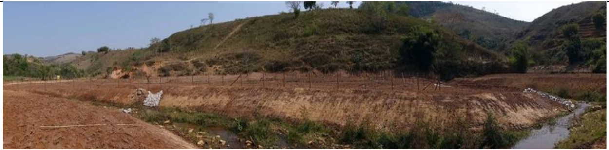
Figura 131. ITG53 imagem Vi028 relatório Fase Argos da Operação Águas equipe Vinhático.
