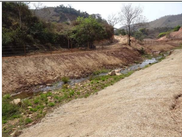
Figura 132. ITG53 imagem Vi025 relatório Fase Argos da Operação Águas equipe Vinhático.
