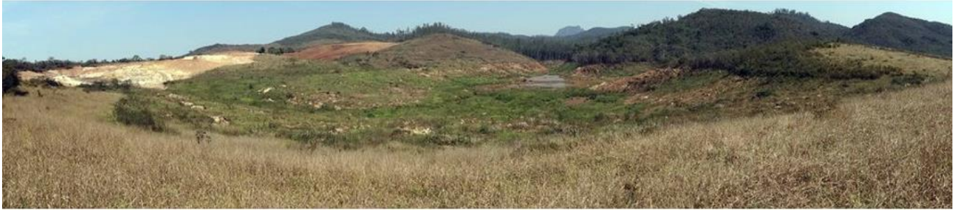
Figura 81. TS 06 imagem Vi013 relatório Fase Argos da Operação Águas equipe Vinhático.
