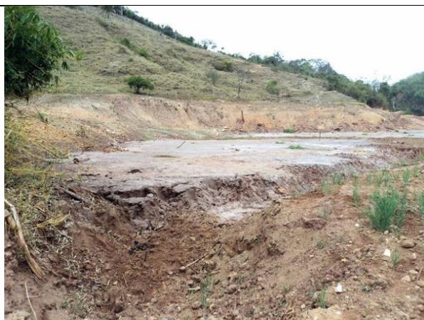
Figura 59. ITG23 imagem Ja043 relatório Fase Argos da Operação Águas equipe Jacarandá.
