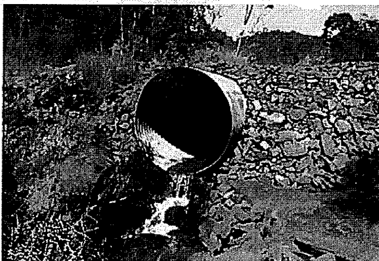
Figura 26 – Exemplo de tubo de ARMCO, a ser utilizado para passagem no corpo hídrico
