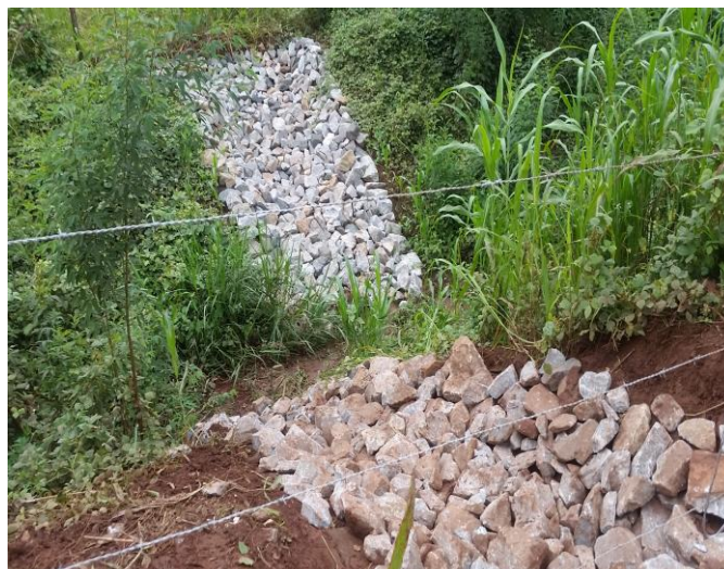
Imagem 14- Descidas d'água construídas nas planícies de inundação.
