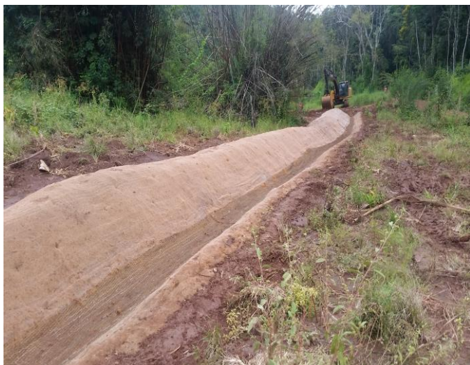
Imagem 13- Canaletas de drenagem construídas nas planícies de inundação.
