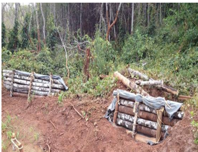
Imagem 21- Uso da madeira nas obras de Bioengenharia como paliçadas.
