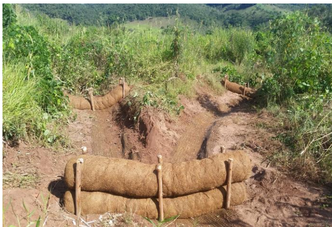
Imagem 11- Aplicação de retentores de sedimentos nas planícies.
