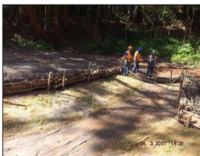
Imagem 22- Uso da madeira nas obras de Bioengenharia.
