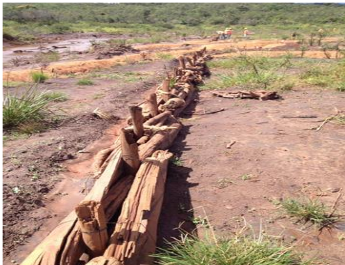
Imagem 19- Uso da madeira nas obras de Bioengenharia como feixe de galhadas.
