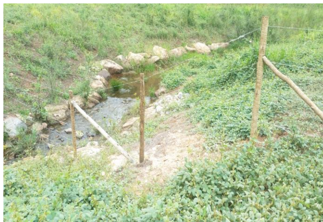
Imagem 12- Construção de enrocamento nas margens.
