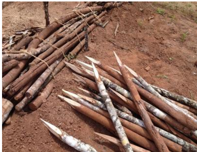
Imagem 20- Uso da madeira nas obras de Bioengenharia como estacas.
