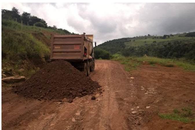
Imagem 27- Manutenção de estradas e acessos.
