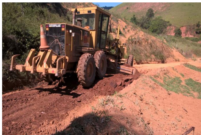
Imagem 28- Manutenção de estradas e acessos.
