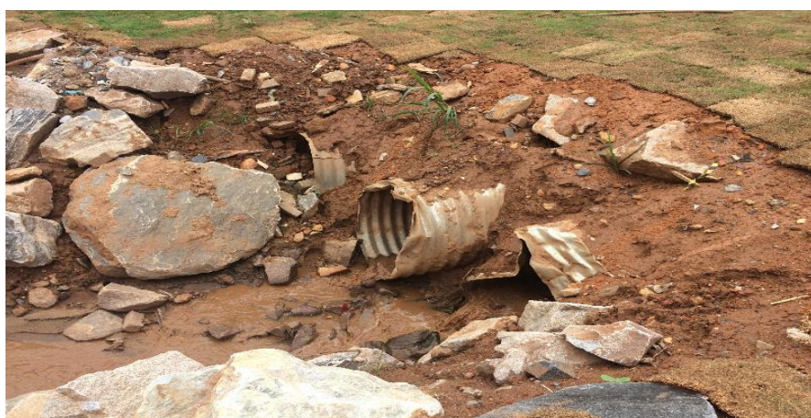
Figura 3: Situação da saída das tubulações de água pluvial e esgoto na seção E-A15-03
