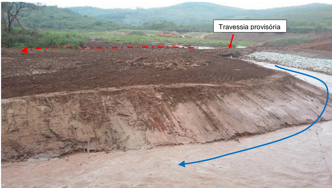
Figura 11: Vista de jusante para montante da margem direita da área de interesse em 12/11/16.
