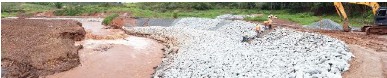
Figura 10: Execução de seção protegida com enrocamento na margem esquerda entre E.G. 860 e 865, situação em 09/12/16.
