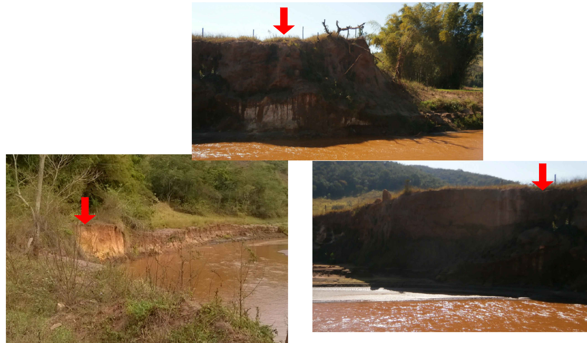
TIPO E - LOCAIS FORTEMENTE ERODIDOS NA FACE DO PENHASCO, EXIGINDO PROJETO DE ENGENHARIA DE CONCEPÇÃO ESPECÍFICA PARA CADA LOCAL.
