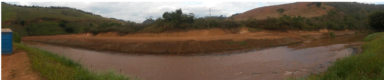
Figura 31: Rio Gualaxo do Norte em 03/08/16, próximo da coordenada de referência E 694.646/ N 7.758.277, visada da margem direita a partir da margem esquerda.
