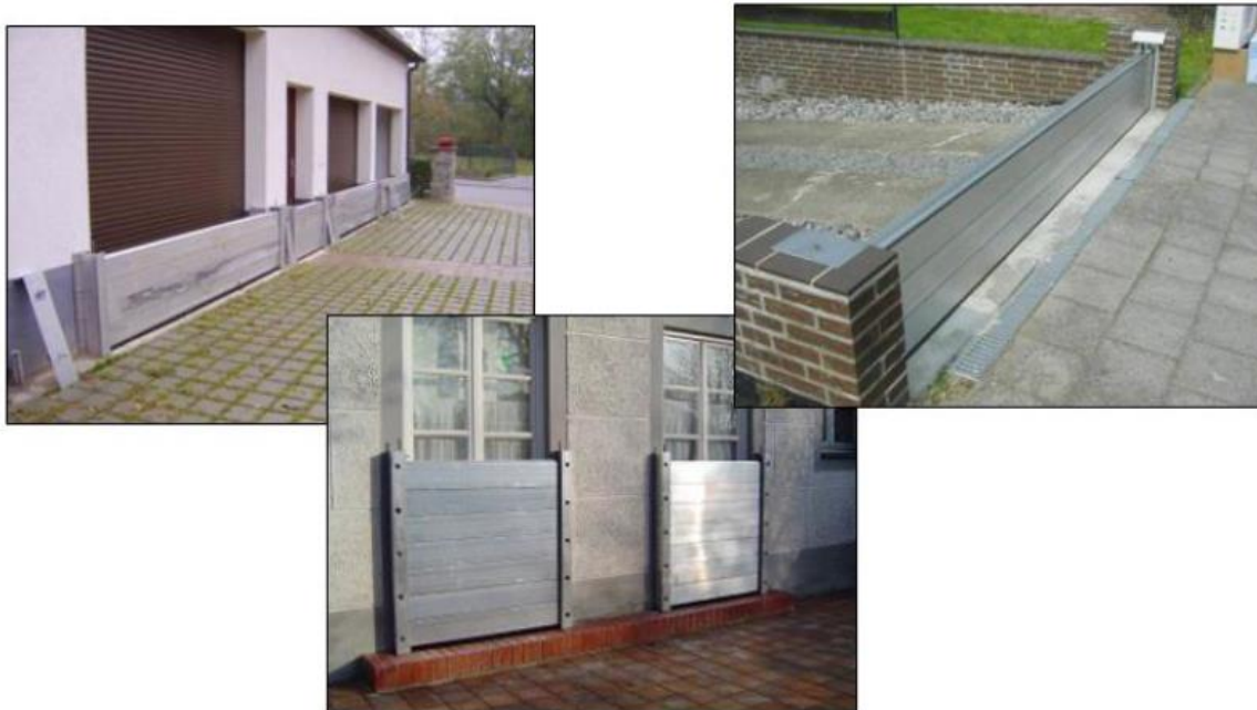
Figura 25: Proteção em nível de propriedade individual.
