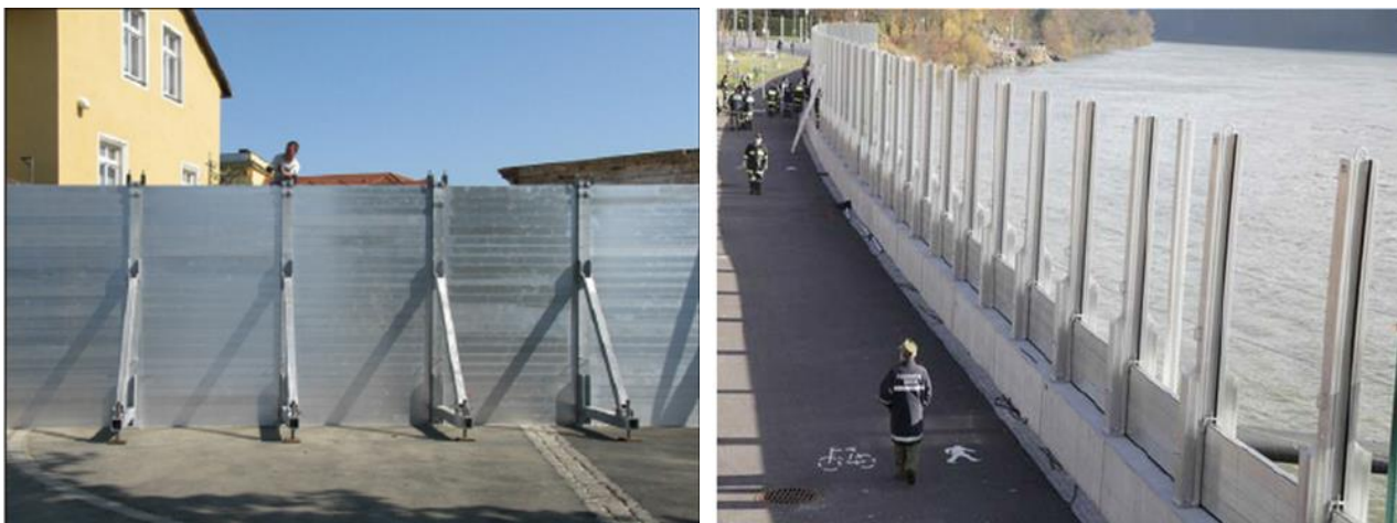
Figura 20: Arranjo temporário de muro de contenção.
