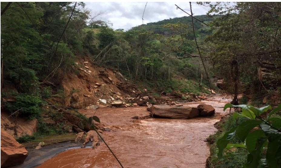
Figura 4: Vista de jusante para montante do local onde ocorreu a ruptura no talude (13/12/2016)
